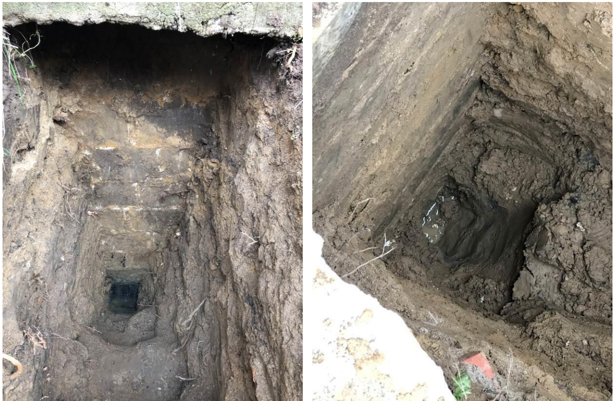
Rys. 11. Odkrytki fundamentów budynku Komisariatu Policji
