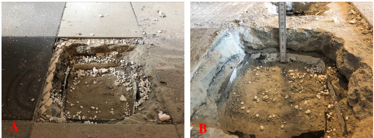
Rys. 14: Odkrywki warstw podłogi na korytarzach: O 1 - na parterze i O 2 – piętrze
