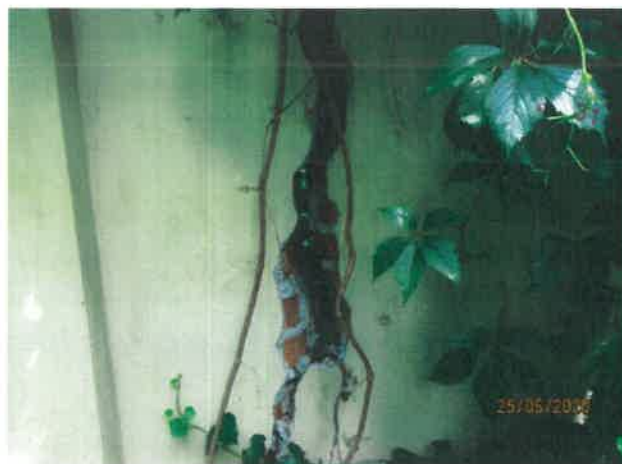
Fot. 5 - Mur graniczny - widok od strony południowej, pęknięcie pionowe.
