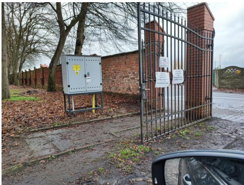
Zdj. 1. Punkt redukcyjno-pomiarowy
