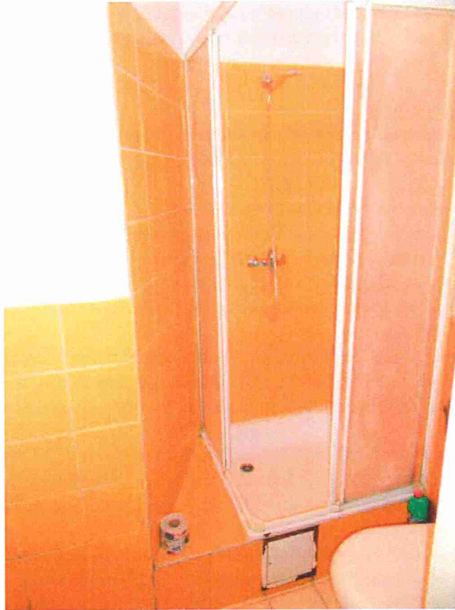
Fot. 1. Stan istniejący – widok na kabinę prysznicową
