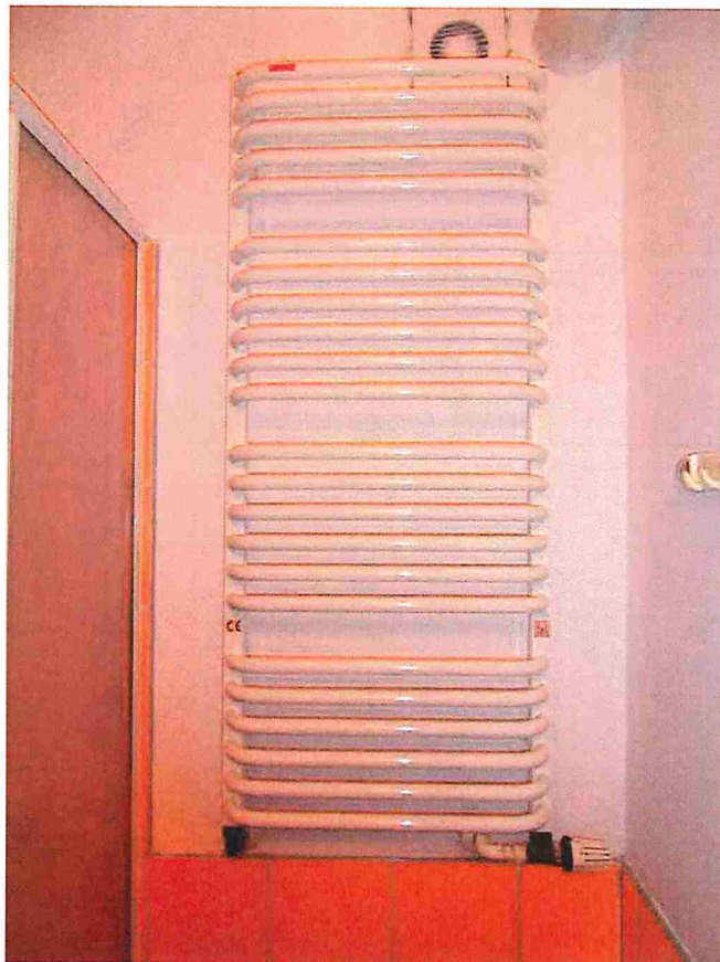
Fot. 4. Stan istniejący – widok na grzejnik
