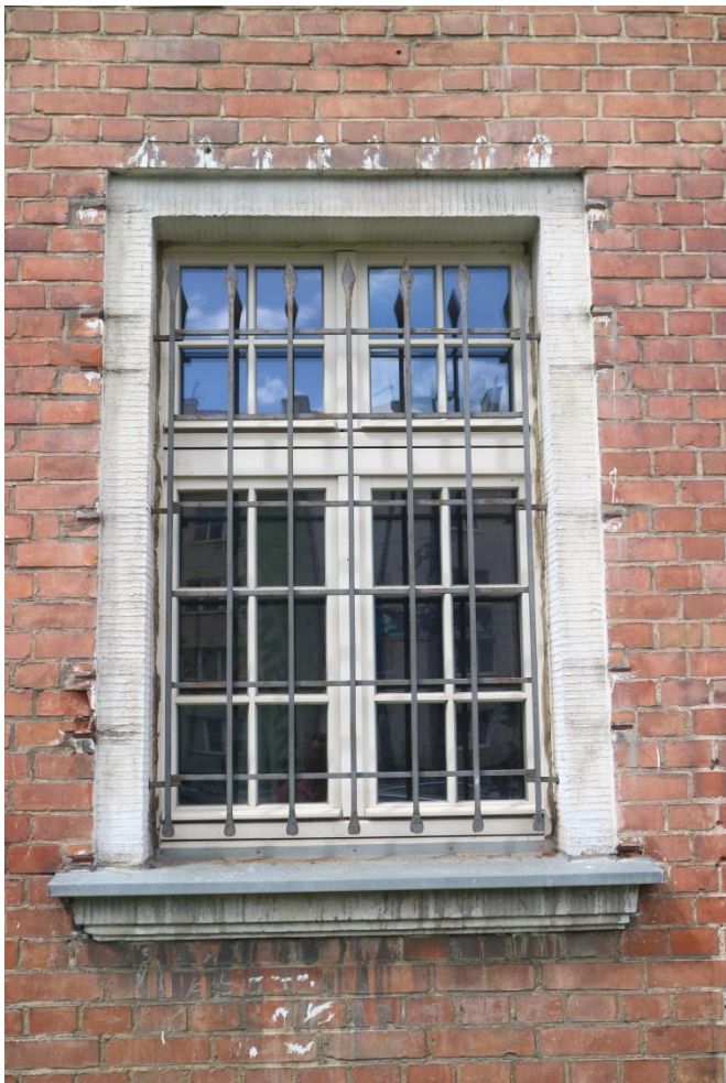
Uszkodzenia po demontażu krat
