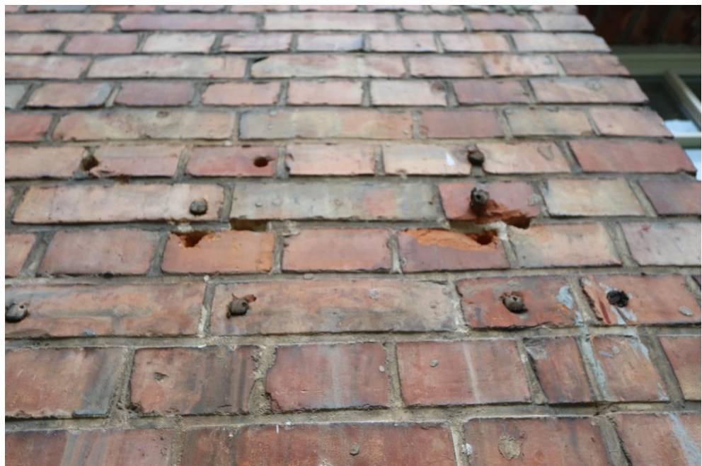
Otwory po montażu tablic.
