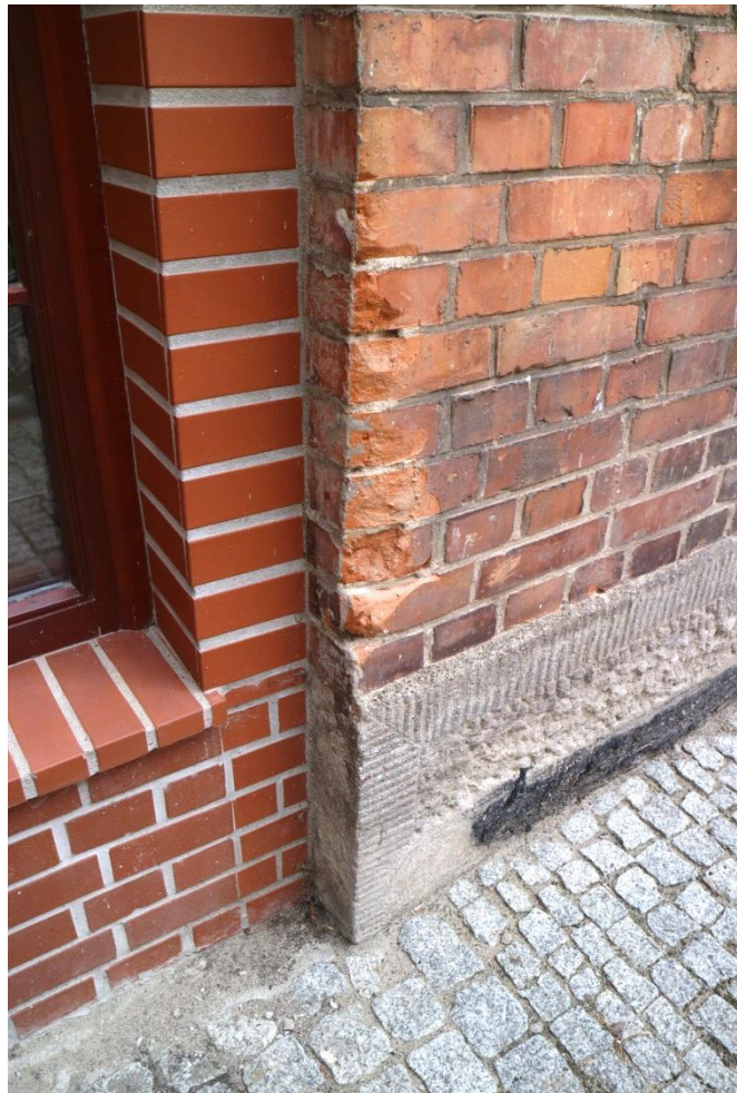
Uszkodzenia mechaniczne
