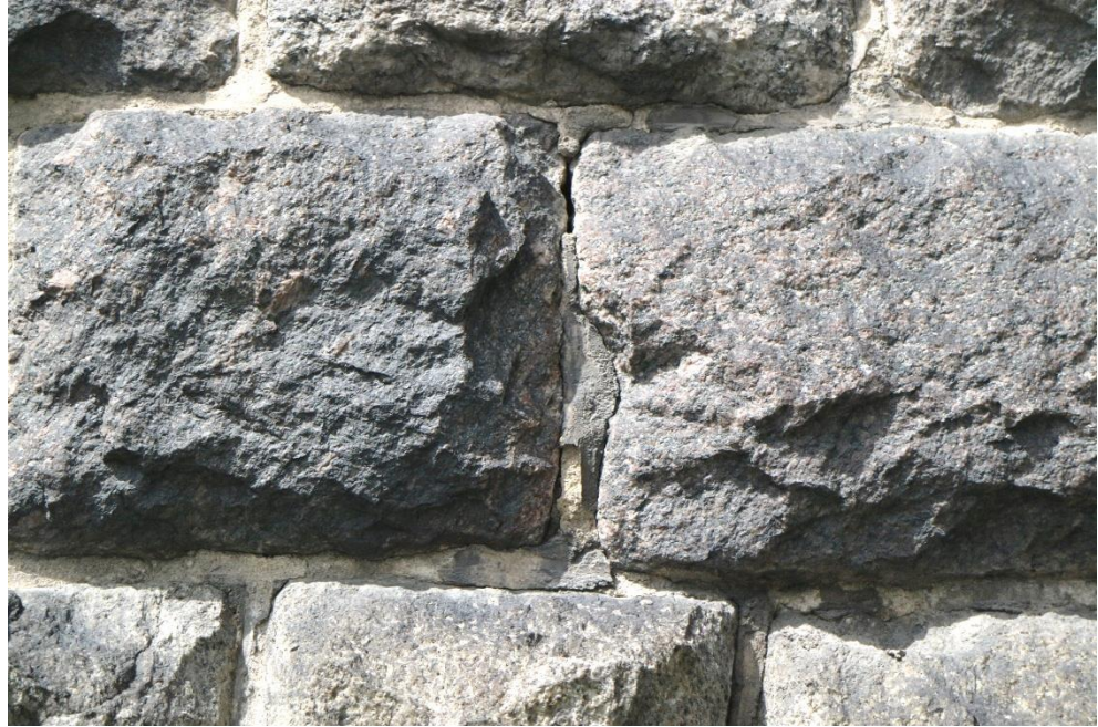
Zbliżenie pęknięcia partii cokołowej
