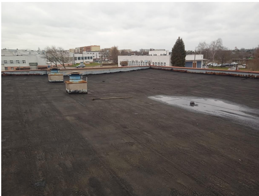
Zdjęcie nr 4. Budynek B - widok na dach.
