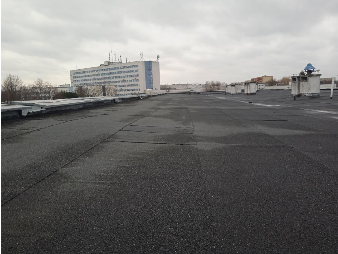
Zdjęcie nr 2. Budynek A - widok na dach.
