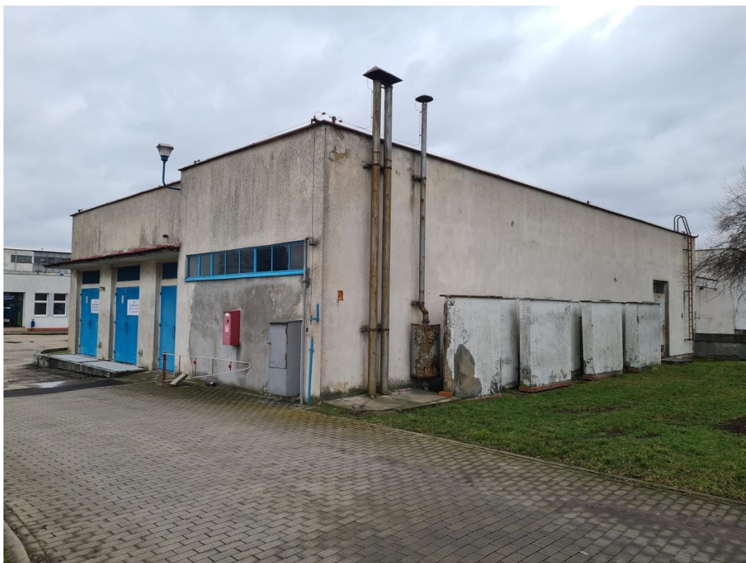
Zdjęcie nr 3. Budynek B - widok na elewację północną.
