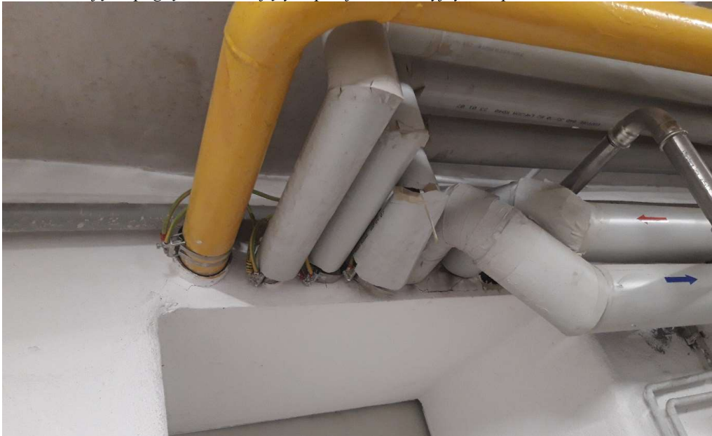
Fot. Zdjęcia poglądowe istniejących przejść instalacyjnych w pomieszczeniu kotłowni
