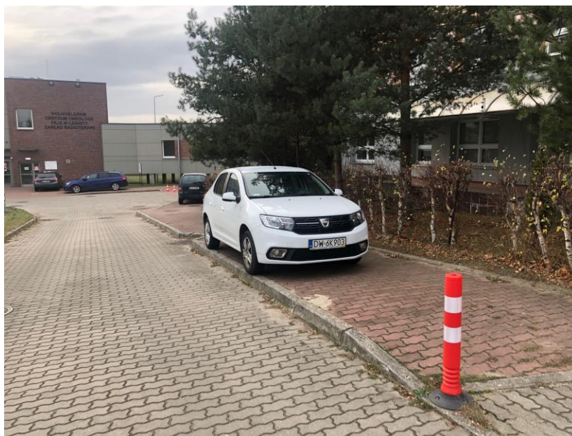
Fot. Nr 5 - Rodzaj nawierzchni drogi oraz chodnika – do przełożenia zgodnie z nową lokalizacją oraz żywopłot przeznaczony do wycięcia
