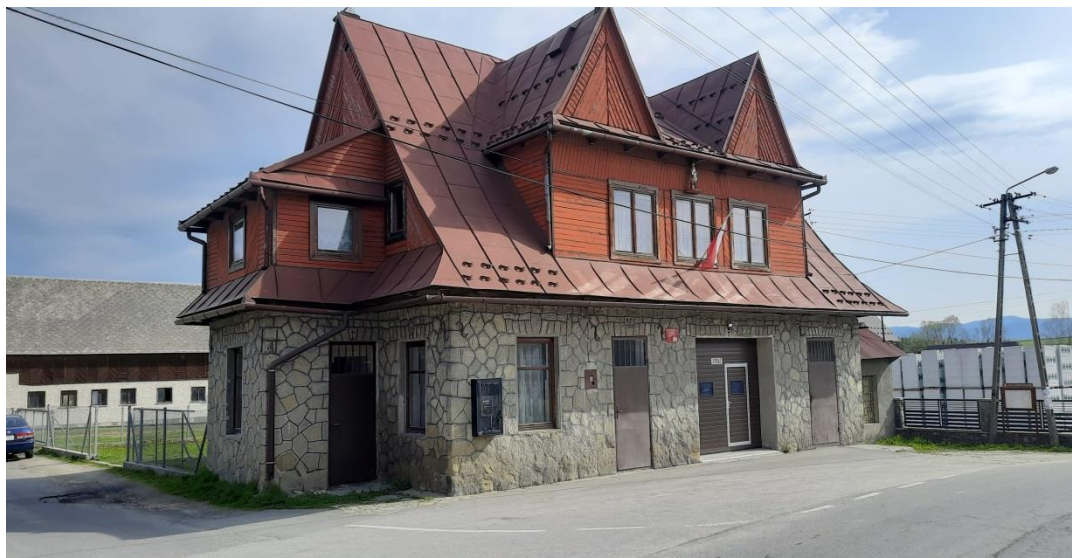
Istniejący budynek remizy OSP-strona południowa
