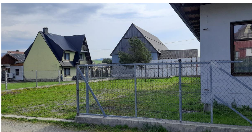
Istniejący budynek remizy OSP - teren za budynkiem od strony północnej
