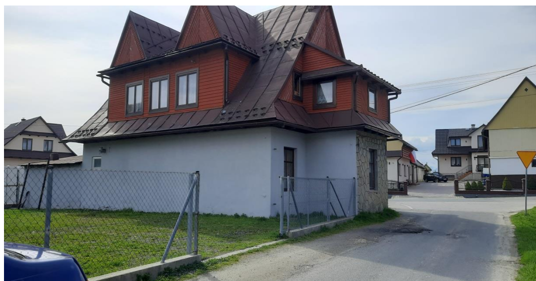
Istniejący budynek remizy OSP -strona północna
