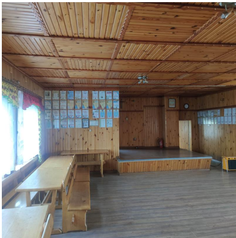
Istniejący budynek remizy OSP – poziom piętra (sala)
