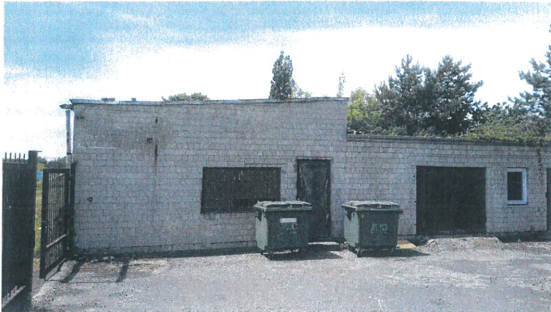
fot. 2. Widok elewacji bocznej (wschodniej) budynku.
