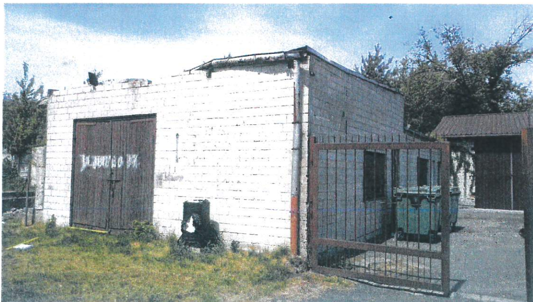
fot. 1. Widok elewacji frontowej budynku od strony wjazdu na teren OSiR „Huragan” Wołomin
