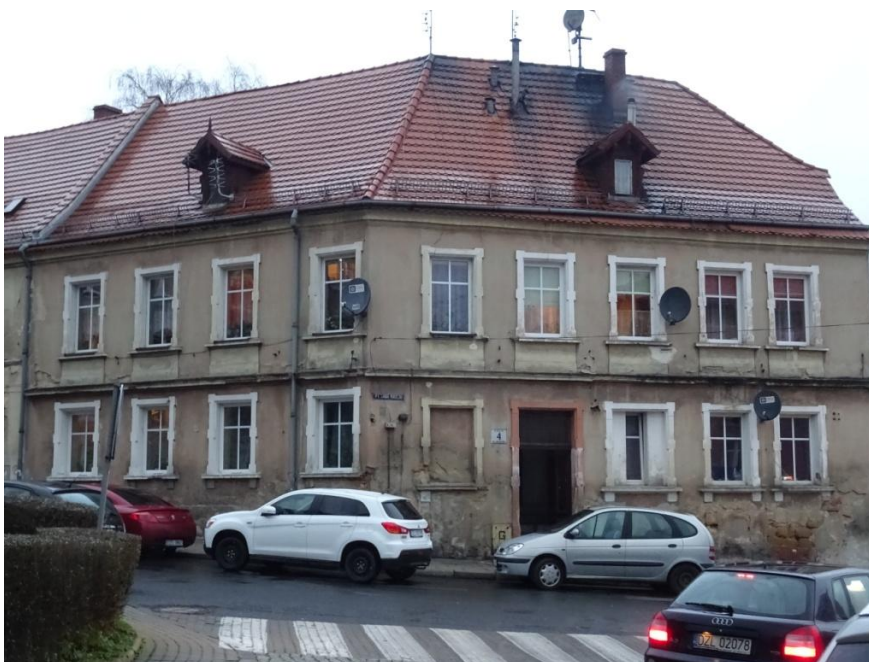
Fot.1 Widok elewacji frontowych – południowej i północno-wschodniej budynku.
