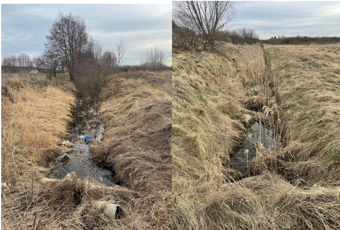
Fot. 1 Rów melioracyjny przylegający do pasa drogowego dz. nr 60 obręb 5 (rów do zachowania) Fot. 2 Rów melioracyjny na granicy działki 12 i 11/2 obręb 5 (do przebudowy – zmiana przebiegu)
