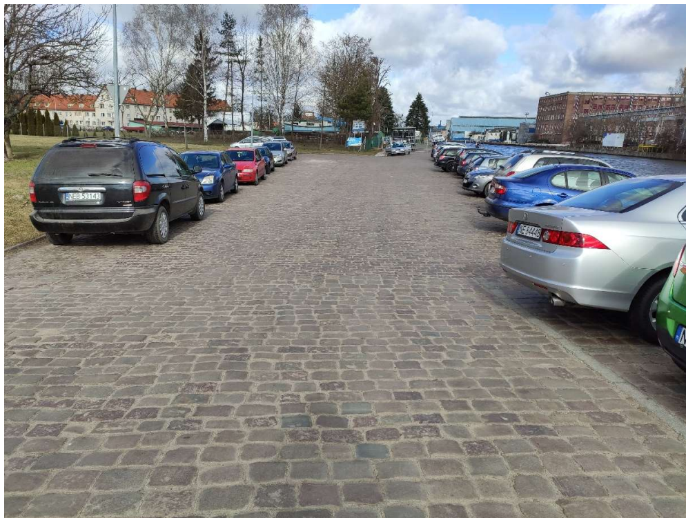
Fot. 4. Plac w rejonie ulic Orlej i Prowiantowej wykonany z kostki brukowej, którą należy przełożyć i wyregulować wysokościowo.
