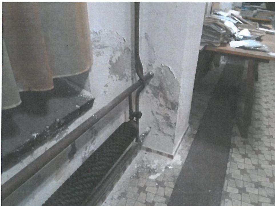
Fot.10. Przykładowy widok powierzchni wewnętrznej ściany zachodniej w piwnicach budynku zlokalizowanego przy ul. Kanoniej 14-17.
