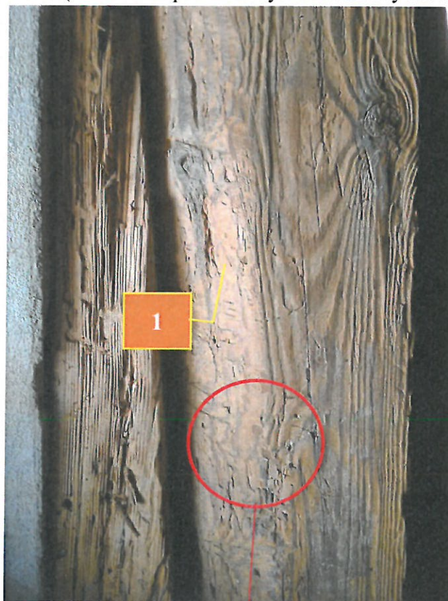
Fot.4. Przykładowy widok z jednej z krokwi w połaci wschodniej. Widoczne znaczne porażenie krokwi (element ten powinien być wzmocniony lub wymieniony).
