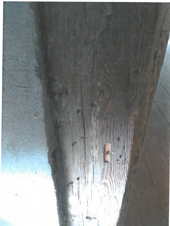
Fot.8. Przykładowy widok nieociosanego (nieoczyszczonego) elementu drewnianego z widocznymi otworami wylotowymi po owadach.
