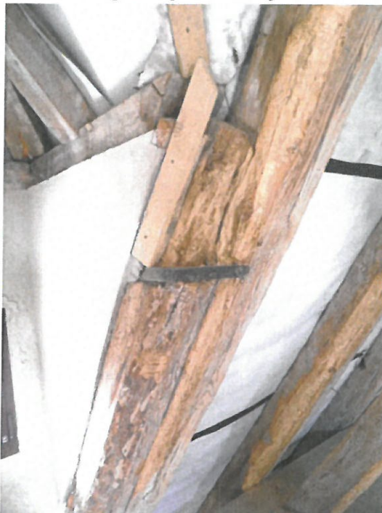
Fot.4. Przykładowy widok z jednej z krokwi w połaci wschodniej. Widoczne znaczne porażenie krokwi (element ten powinien być wzmocniony lub wymieniony).
