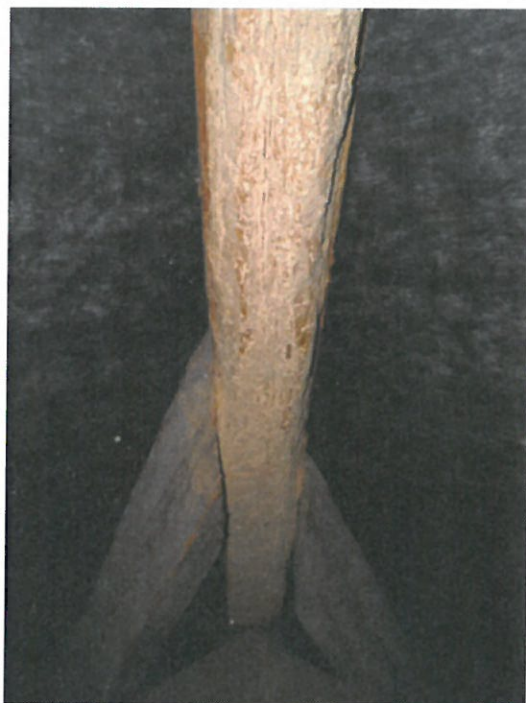
Fot.1. Widok północno-zachodniej krokwi narożnej.
