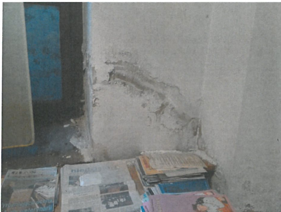
Fot.13. Jak fot. 12, ale widok z boku pilastra przyściennego.
