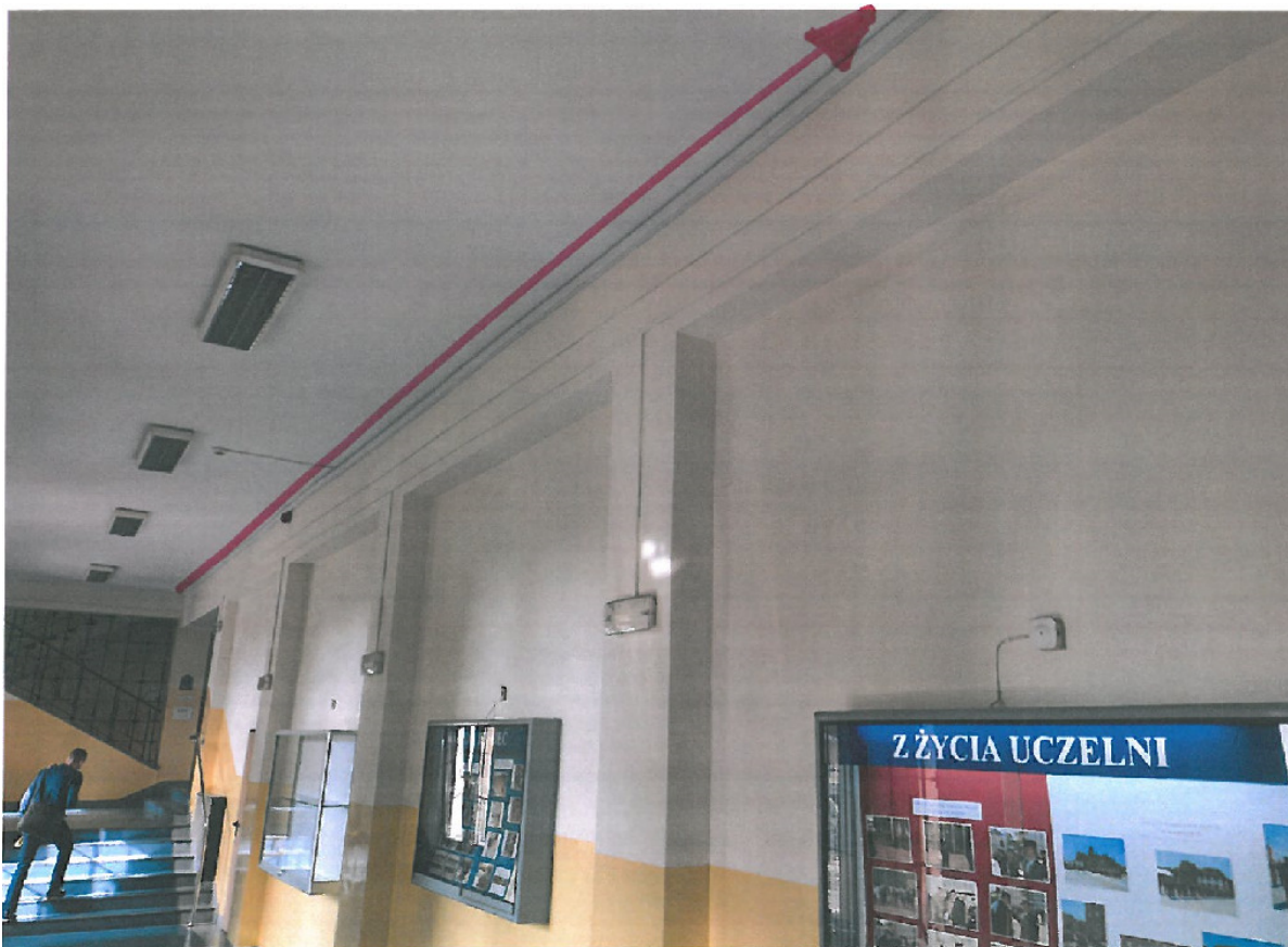
Rys. 10. Czerwoną linią oznaczono trasę kabla w bud. 5
