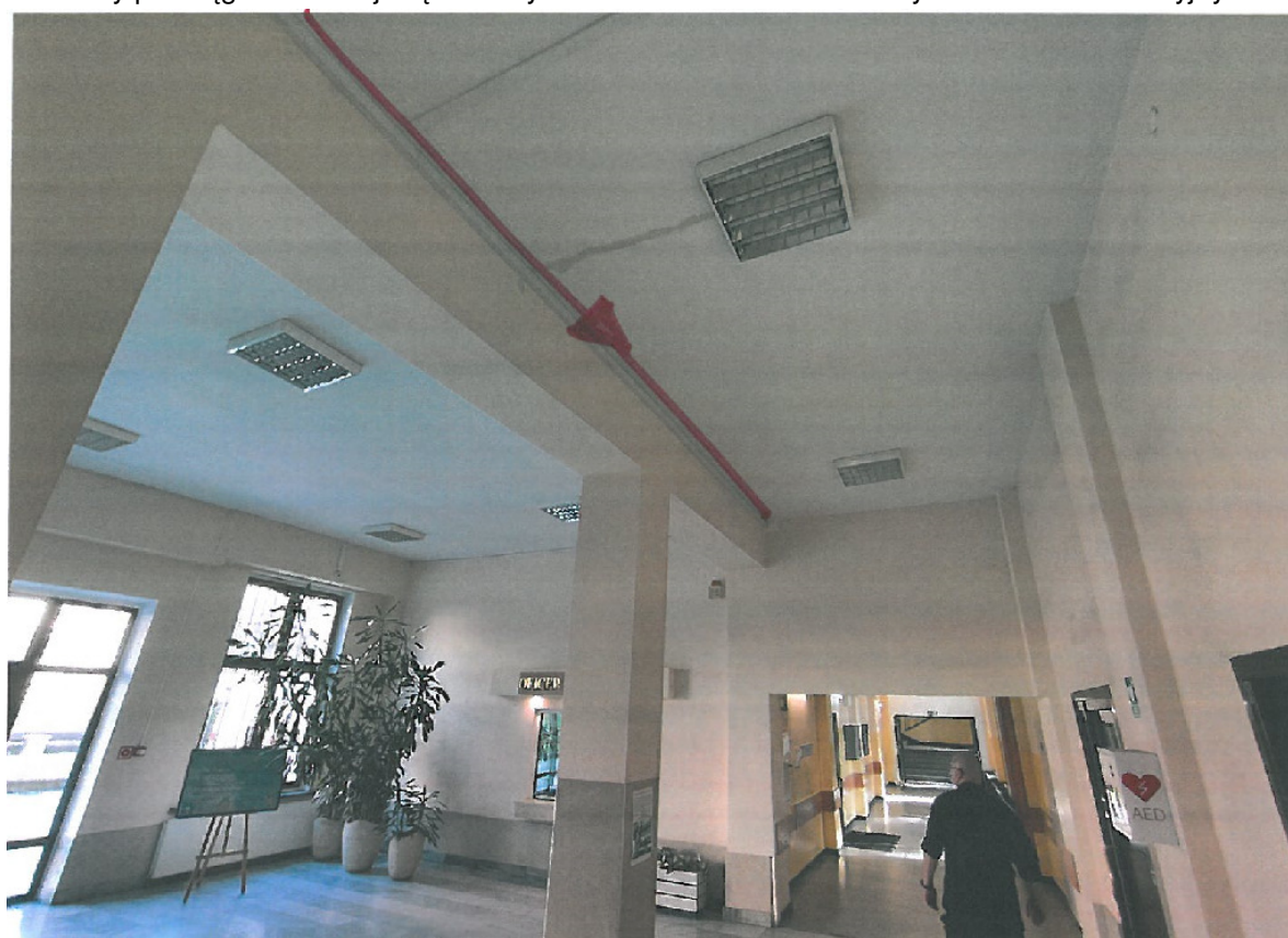
Rys. 9. Czerwoną linią oznaczono trasę kabla w bud. 5
