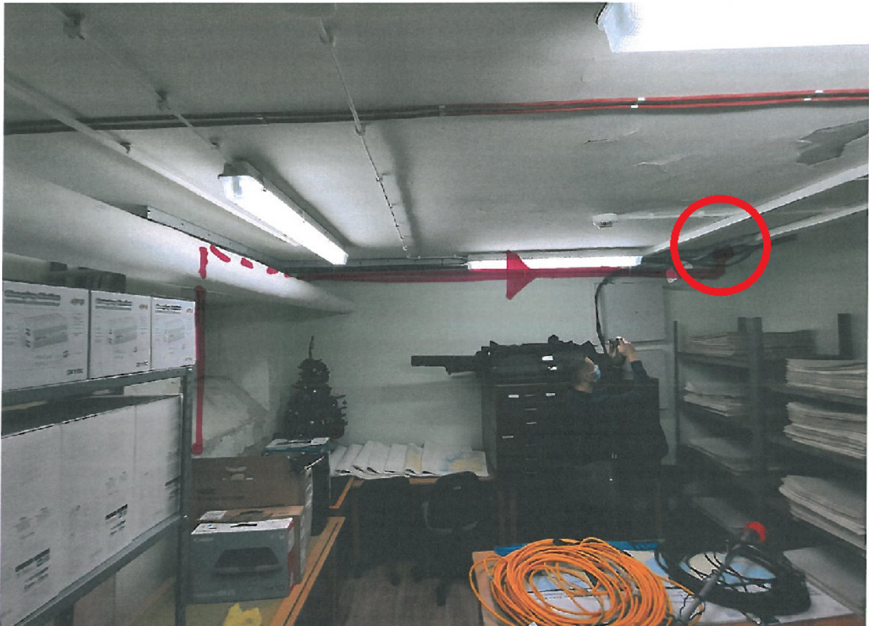
Rys. 1. Miejsce przejścia przez strop z serwerowni w bud. 10 do piwnic budynku 10. Z pomieszczenia widocznego na fotografii przejść należy przez ścianę w kierunku korytarza.
