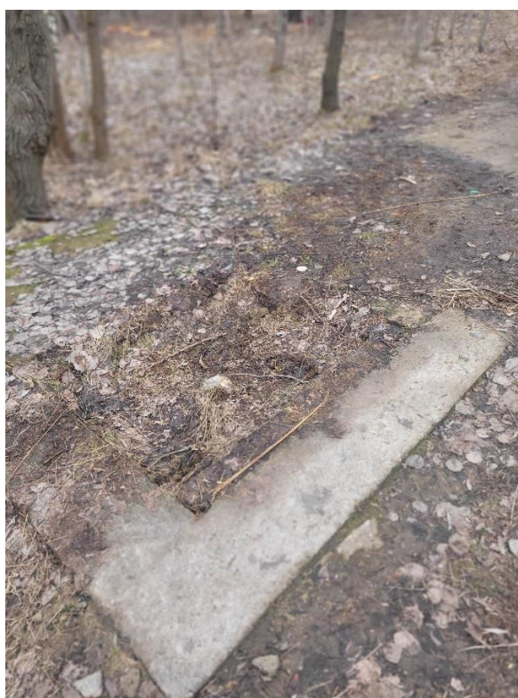
Ryc. 3 Istniejące, widoczne płyty betonowe w terenie – stan obecny
