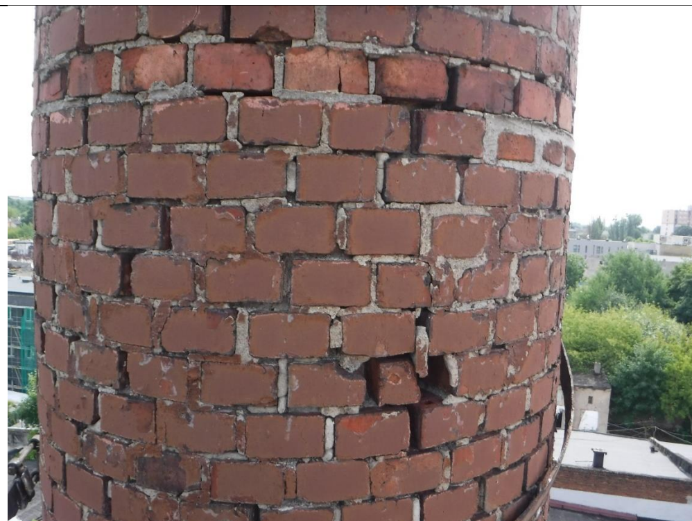
fot.9 ubytki zaprawy i cegły h=20m
