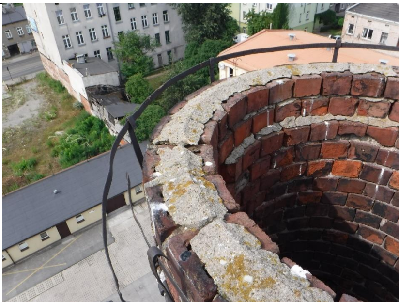
fot.2 Głowica – erozja spoin od wewnątrz, zerwana opaska instalacji odgromowej
