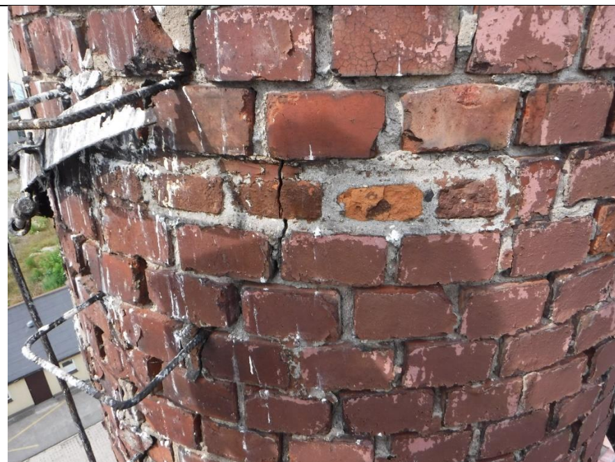
fot.5 Zerwana obręcz, rysa pionowa h=19m
