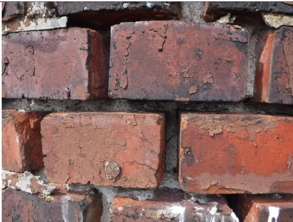
fot.3 Wyplukane spoiny – h=21m str.pd-wsch
