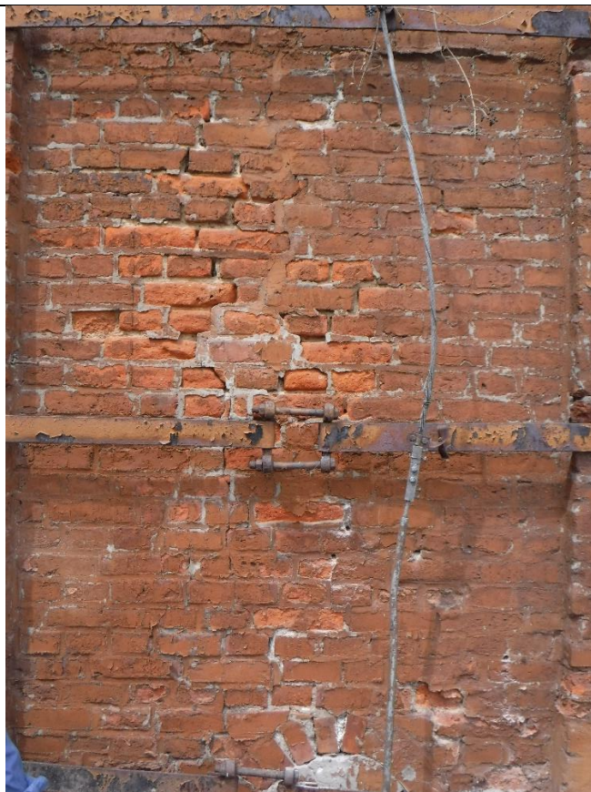
fot.14 Elewacja wschodnia – erozja muru
