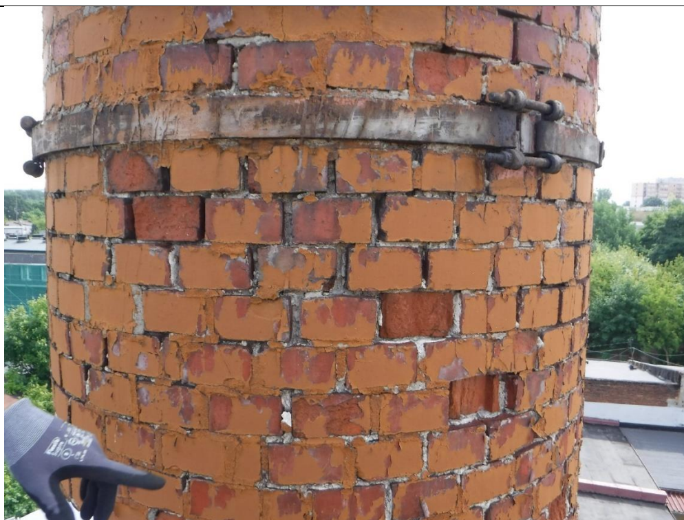
fot.8 erozja muru h=16m
