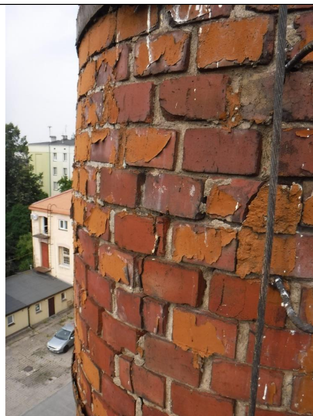
fot.6 rysa pionowa h=16m
