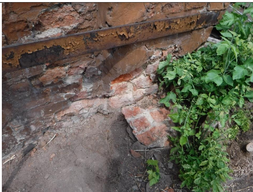
fot.13 Podstawa elewacja wsch., erozja cegły
