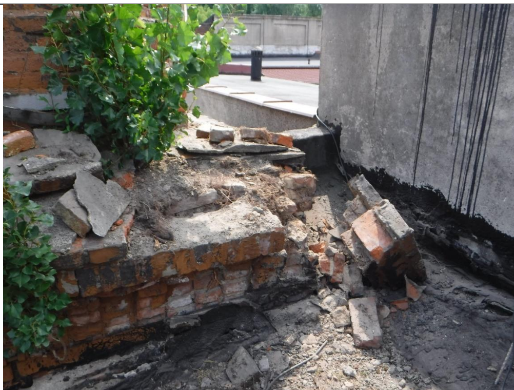
fot.12 Podstawa – uszkodzenia muru
