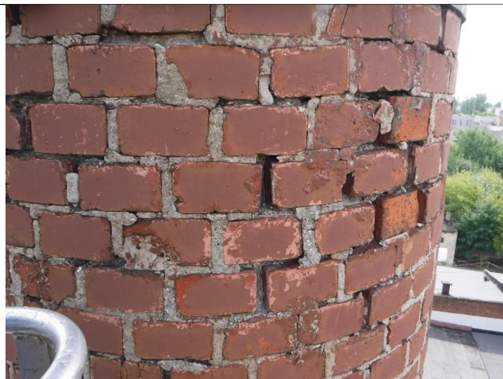
fot.10 ubytki zaprawy h=21m
