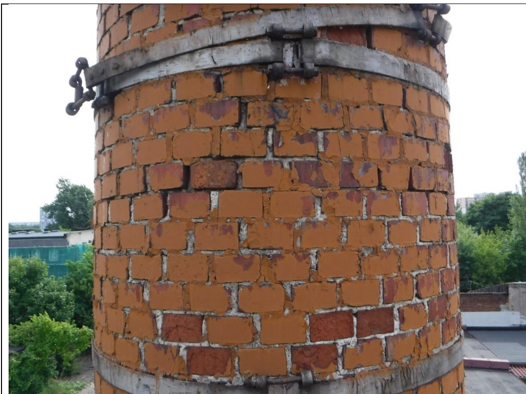
fot.7 wypłukane spoiny, zerwana obręcz h=11m
