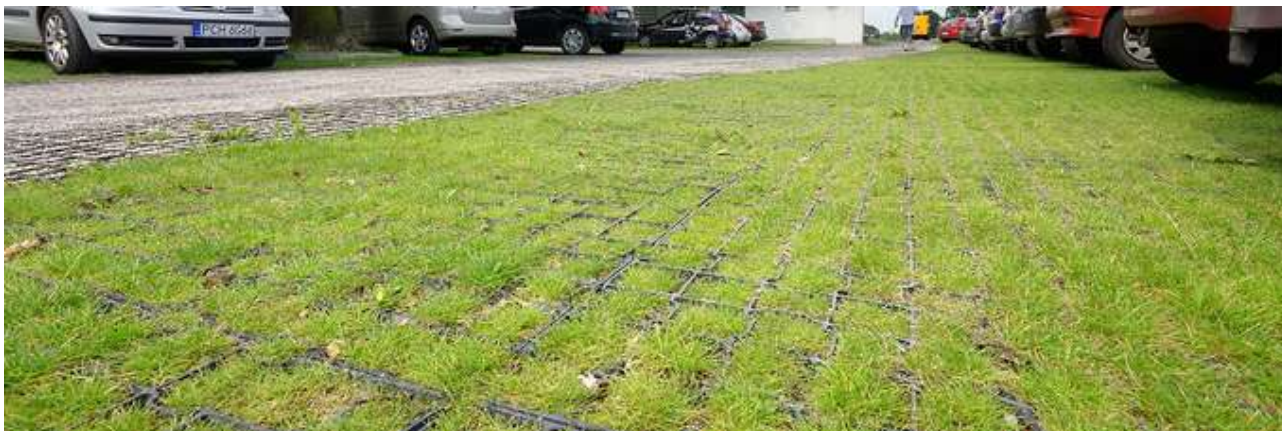
Przykład zastosowania geokraty zarastającej trawą.
