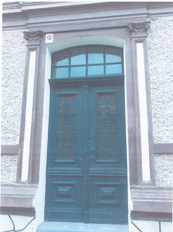
Widok drzwi proponowane do wymiany w elewacji bocznej wschodniej w budynku szkoły.
