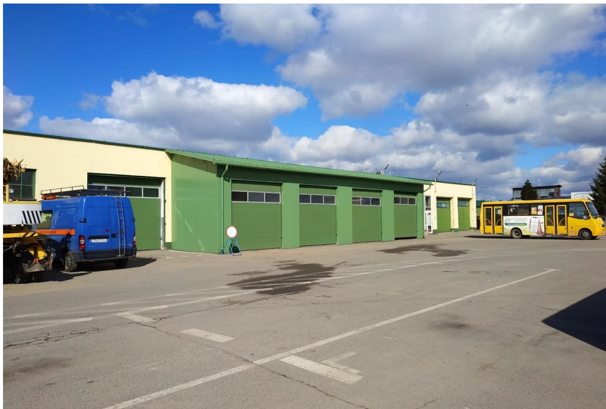
Źródło: Dokumentacja projektowa udostępniona przez Inwestora Rysunek 3, 4 i 5: Zdjęcia budynku o najwyższym potencjale wykorzystania instalacji fotowoltaicznej
