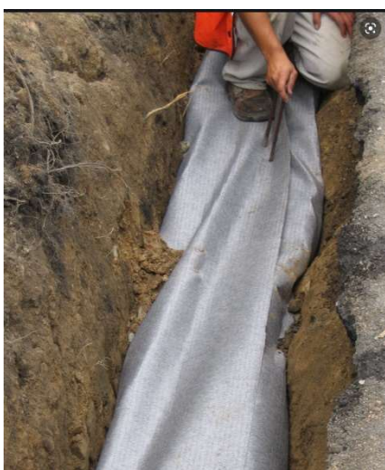
Rys. 4. Wykonanie zakładu i zastabilizowanie za pomocą szpilek
