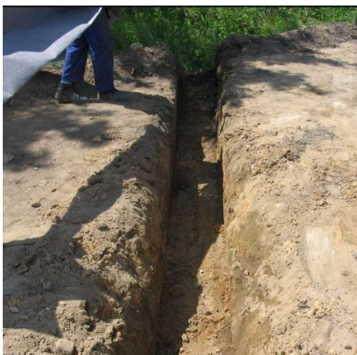
Rys. 1. Rów drenażowy o ścianach pionowych bez umocnienia
