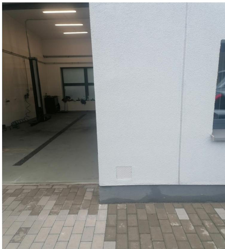
Fot. nr 2 Ściana zewnętrzna pomieszczenia warsztatowego
