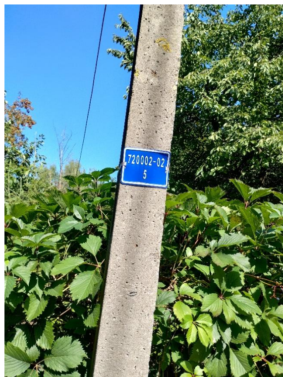
Rysunek 14 Numeracja słupa według nowego systemu z oznaczeniem stacji zasilającej i numeru obwodu
