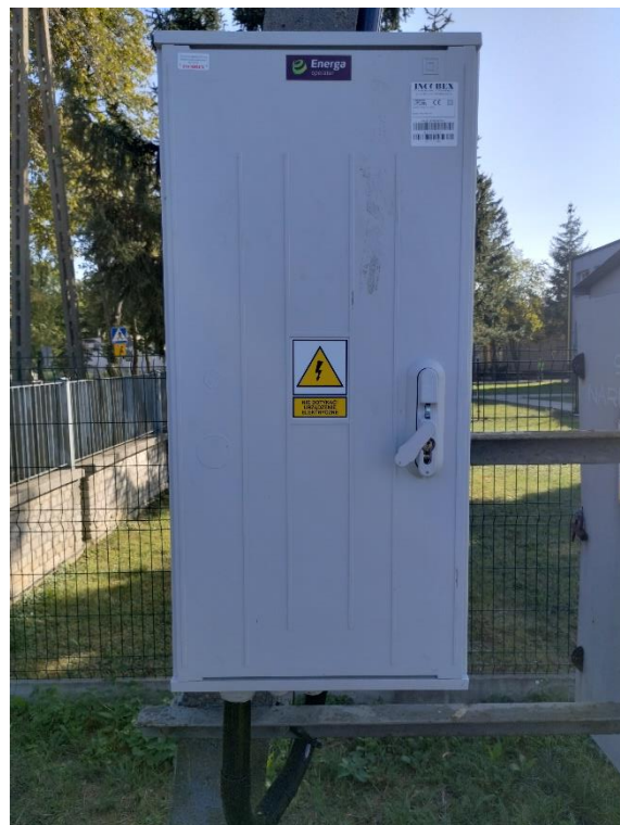
Rysunek 11 Typowa szafka oświetleniowa SO-7 (Naruszewo)
