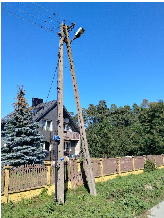
Rysunek 7 Oprawa zamocowana na krótkim wysięgniku, zbyt daleko od krawędzi jezdni, linia nieizolowana (Nowe Naruszewo)
