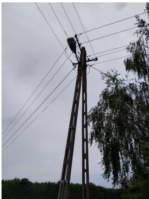
Rysunek 3 Oprawa zawieszona na słupie typu ŻN pod nieizolowaną linią abonencką (Strzembowo)
