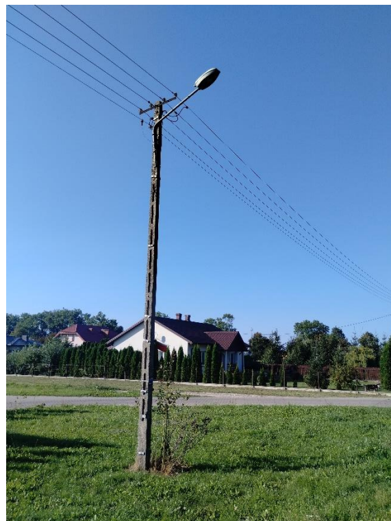
Rysunek 5 Oprawa oświetleniowa zawieszona na słupie znajdującym się zbyt daleko od drogi
