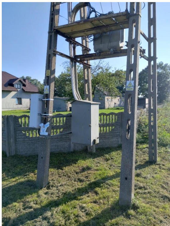
Rysunek 10 Typowy zestaw zasilający obwody oświetleniowe i stacja trafo (Zaborowo)
