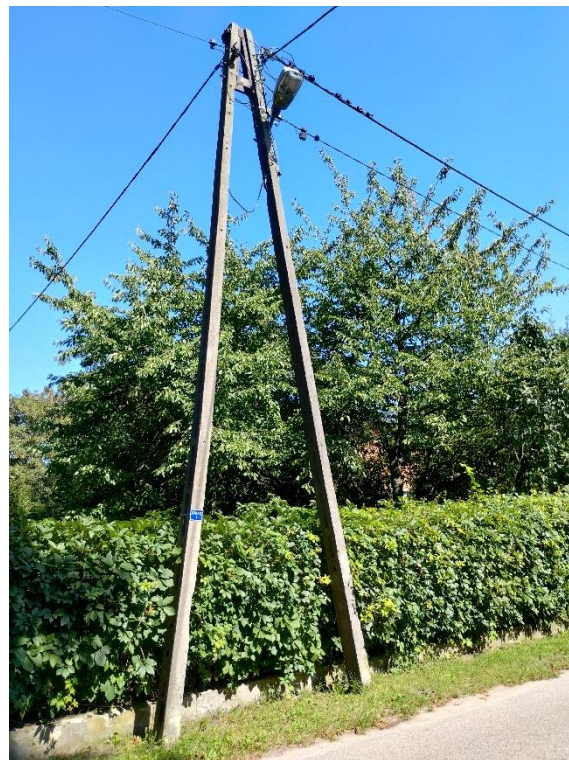
Rysunek 8 Oprawa zamocowana na krótkim wysięgniku we właściwej odległości do krawędzi jezdni, linia izolowana (Radzyminek)
