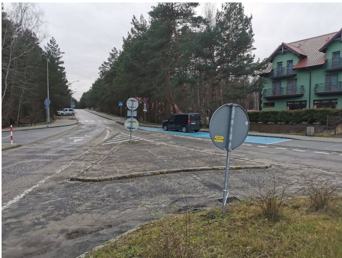
Zdjęcie nr 6: widok ogólny stanu istniejącego
