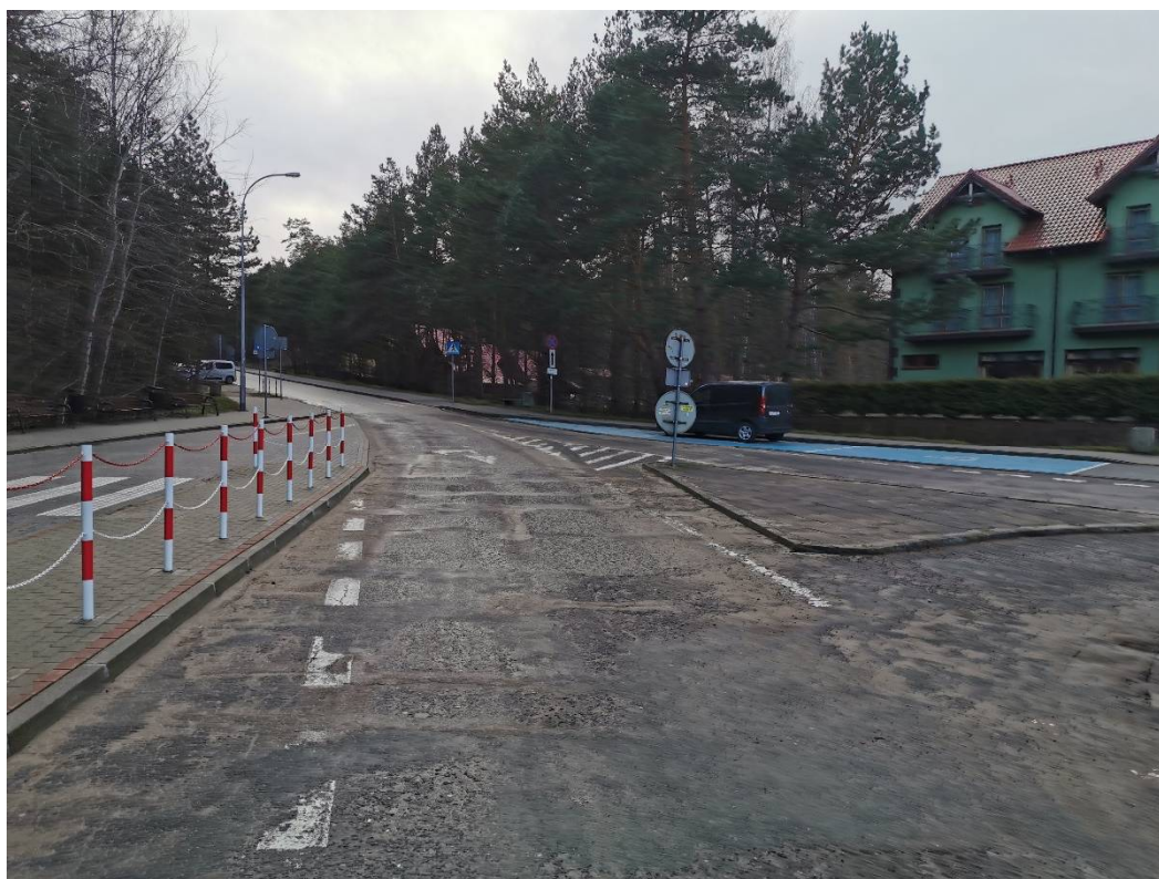
Zdjęcie nr 2: widok ogólny stanu istniejącego
