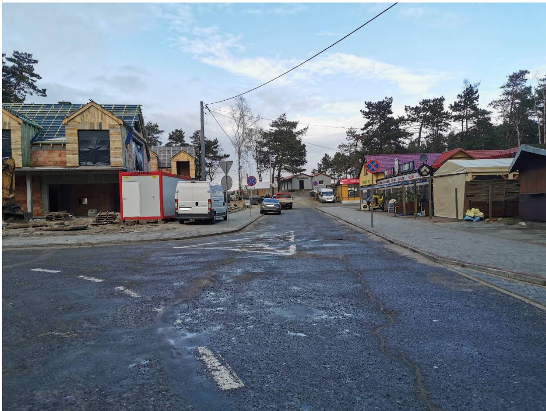
Zdjęcie nr 5: widok ogólny stanu istniejącego
