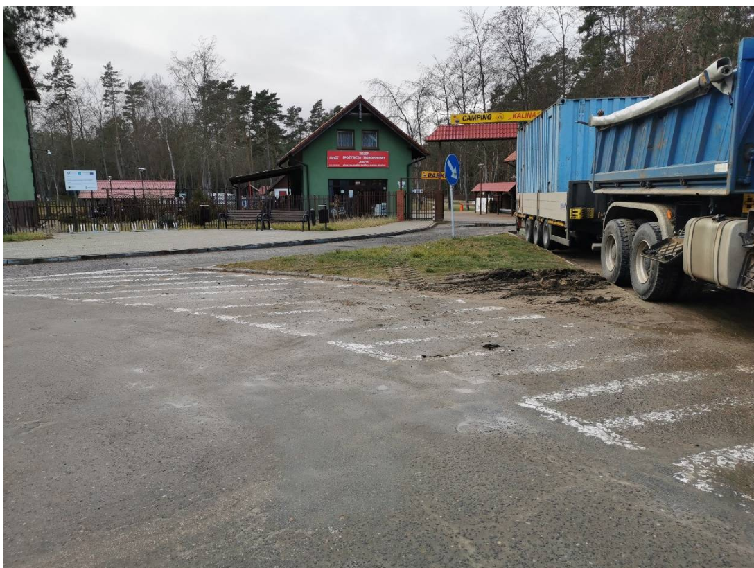
Zdjęcie nr 4: widok ogólny stanu istniejącego
