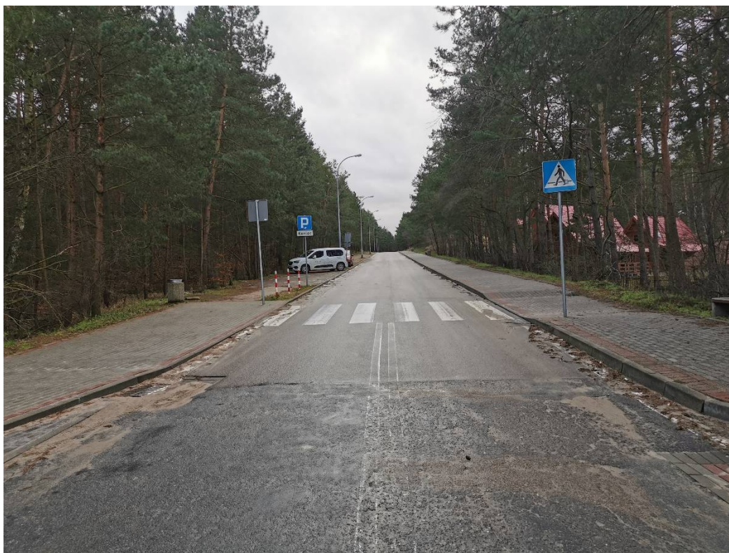
Zdjęcie nr 1: km 0+000 widok ogólny stanu istniejącego
