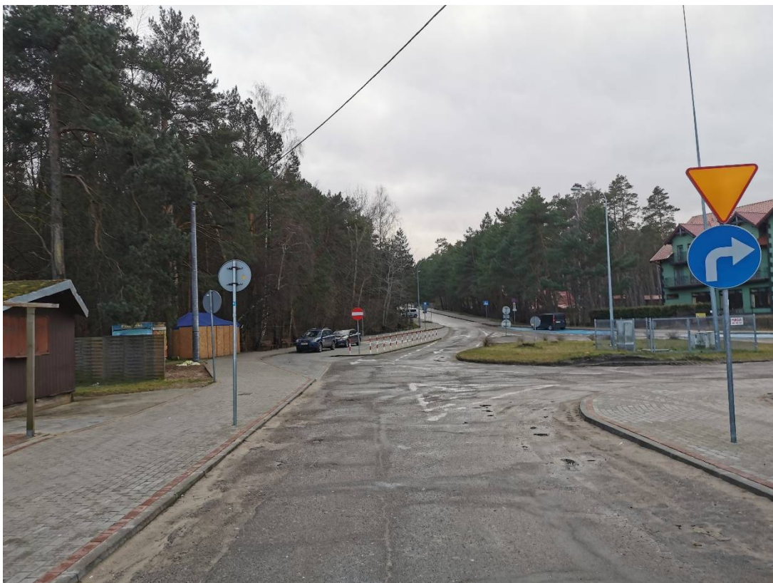
Zdjęcie nr 3: widok ogólny stanu istniejącego
