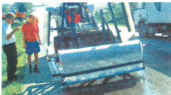
Układanie geosyntetyków za pomocą urządzeń TenCate.
