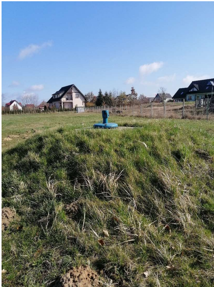
Studnia głębinowa nr 4 na dz. nr 33
