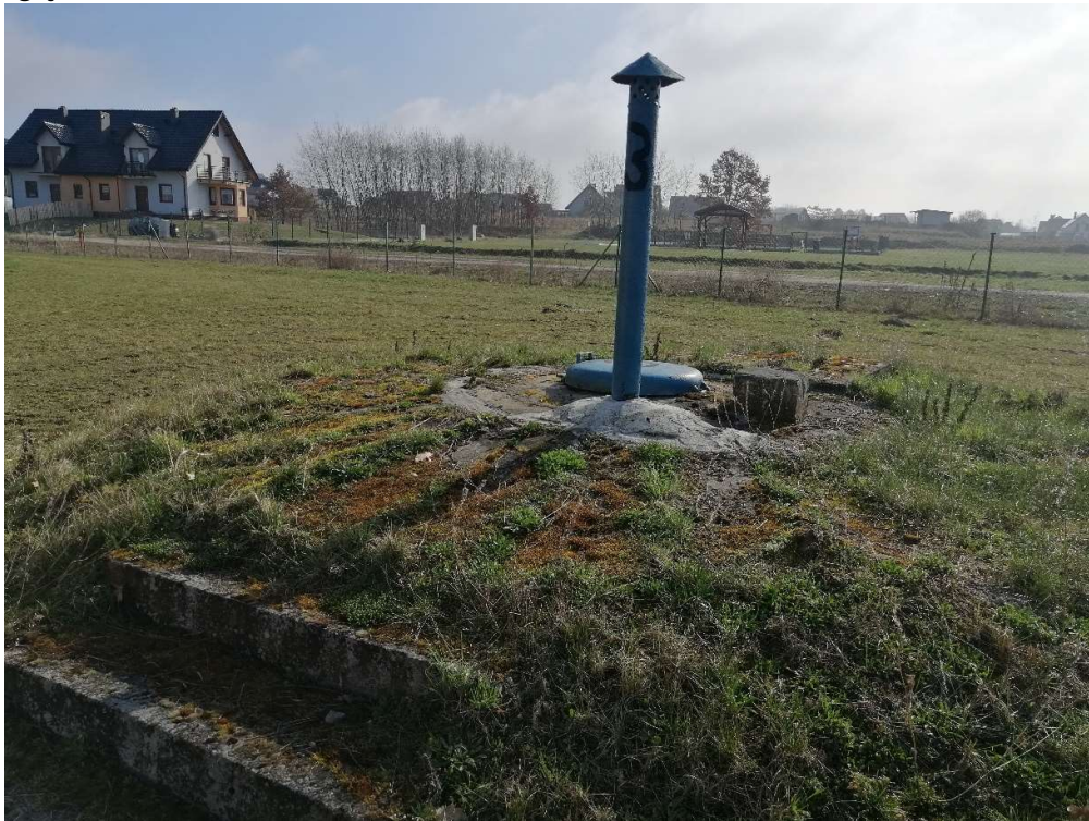
Studnia głębinowa nr 3 na dz. nr 33
