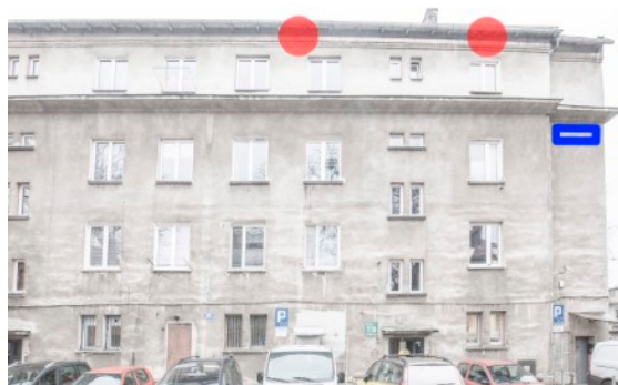
Fot. 6. Budynek ul. Kościuszki 11, 11a, 11b w Tarnowskich Górach Zaznaczono potencjalne siedliska lęgowe jerzyka - czerwone punkty. Propozycja zlokalizowania budek lęgowych dla jerzyka - niebieska ramka.
