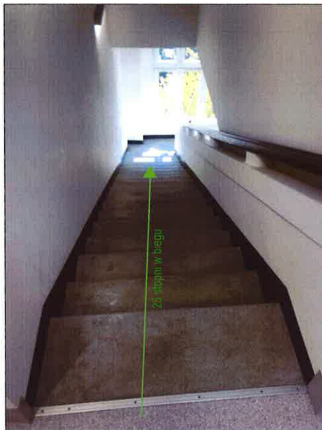
Fotografia 1 Widok na klatkę schodową K10 - ewakuacja z kondygnacji IV piętra
