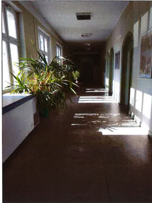
Fotografia 15 Widok komunikacji w strefie pożarowej SP13 na kondygnacji I piętra
