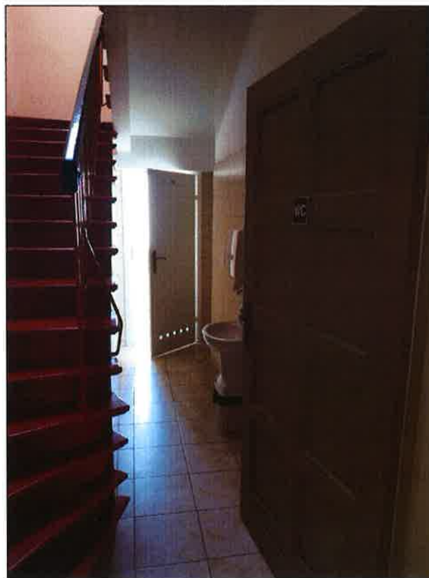
Fotografia 16 Widok na klatkę schodową K2 na kondygnacji II piętra (pomieszczenia WC do likwidacji)
