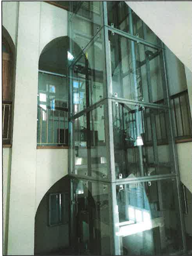
Fotografia 13 Widok na windę K2 łączącą kondygnację parteru z III piętrzem
