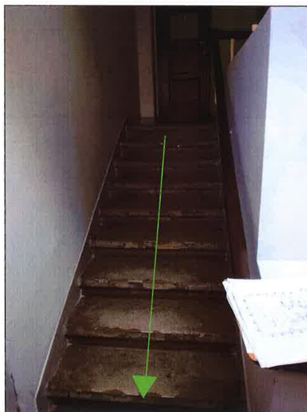
Fotografia 12 Widok klatki schodowej K2 z półpiętra (+1,50 m) na kondygnację parteru
