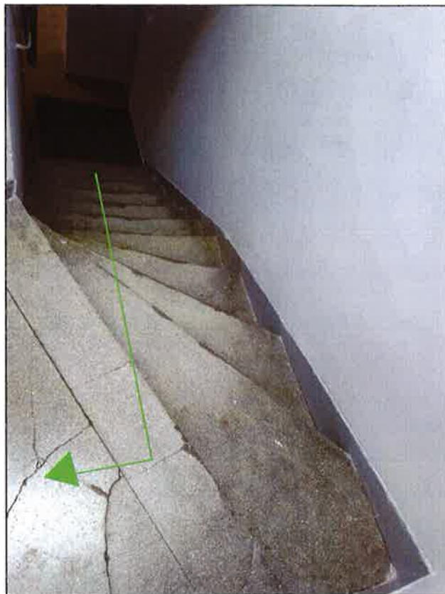
Fotografia 11 Widok zejścia klatki schodowej K2 na kondygnację piwnicy
