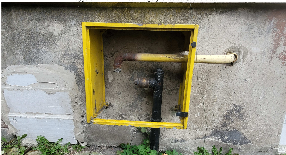
Zdjęcie numer 2 – fragment elewacji frontowej zachodniej, główne przyłącze gazu, zniszczona skrzynka gazowa
