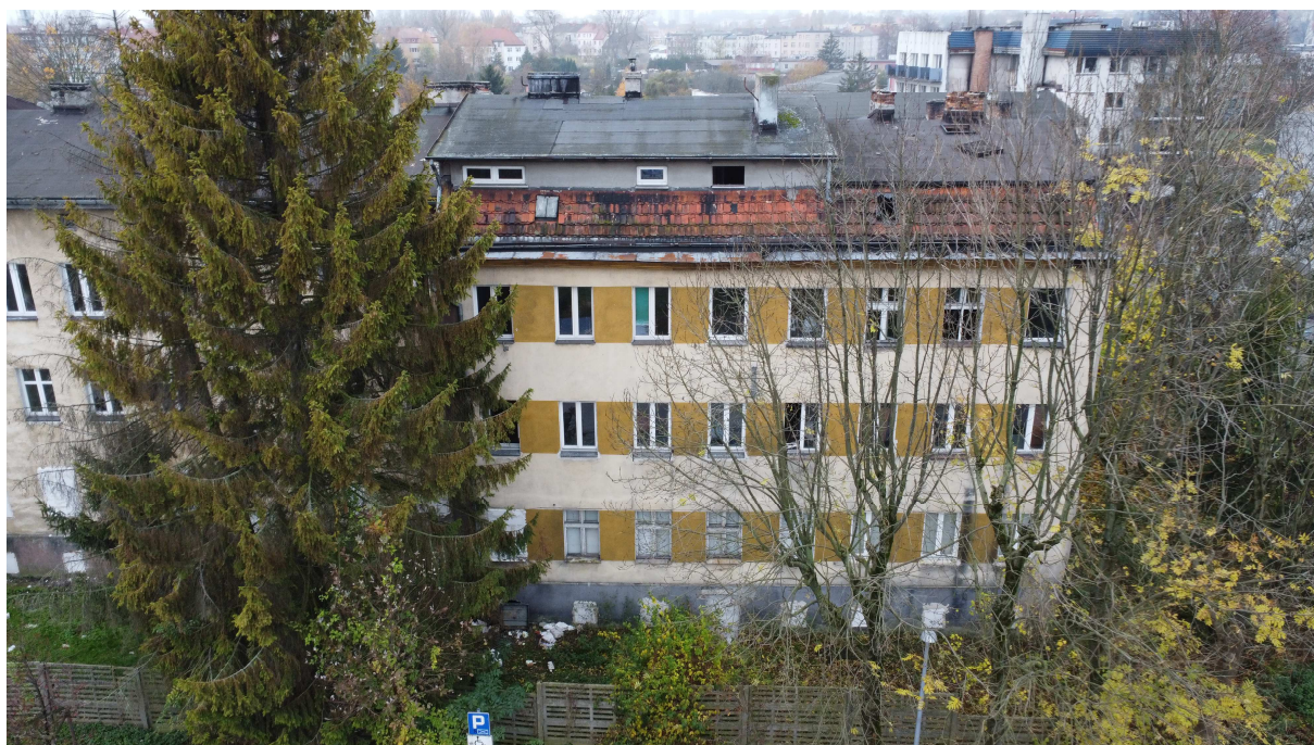
Zdjęcie numer 4 – fragment elewacji tylnej wschodniej, widoczna mansarda dachowa wykończona dachówką ceramiczną oraz podniesiony fragment połaci dachowej
