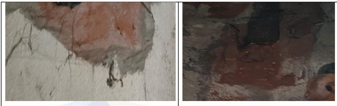
Fot. nr. 9,10 Ściany murowane osłonowe, konstrukcyjne z cegły ceramicznej
