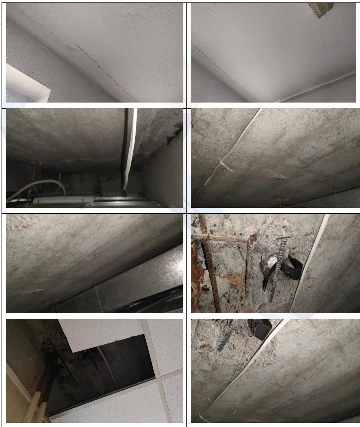
Fot. nr.1,2,3,4,5,6,7,8 Strop międzykondygnacyjny prefabrykowany z płyt kanałowych
