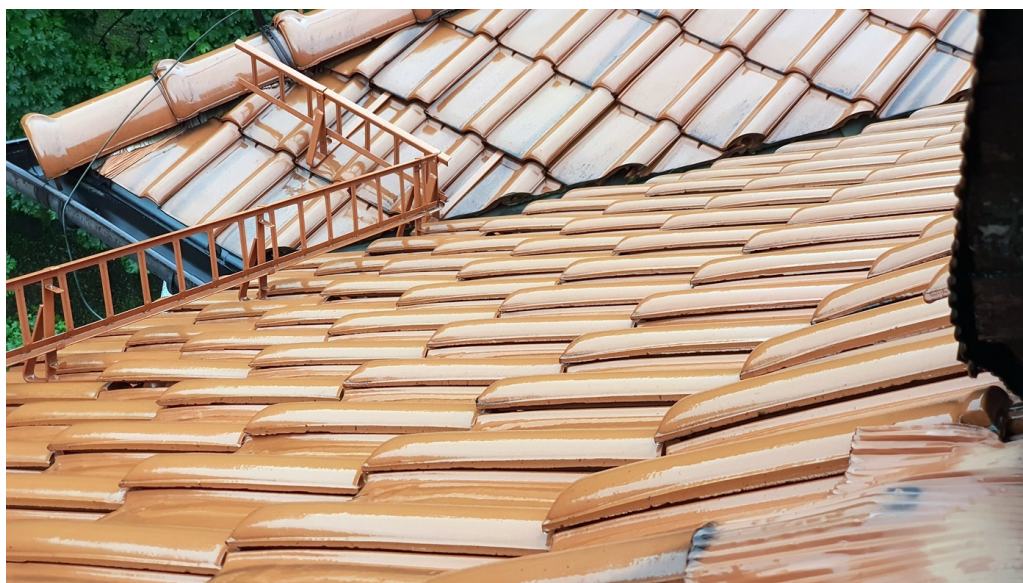
Fot. 1; fragment dachu od strony południowej;
