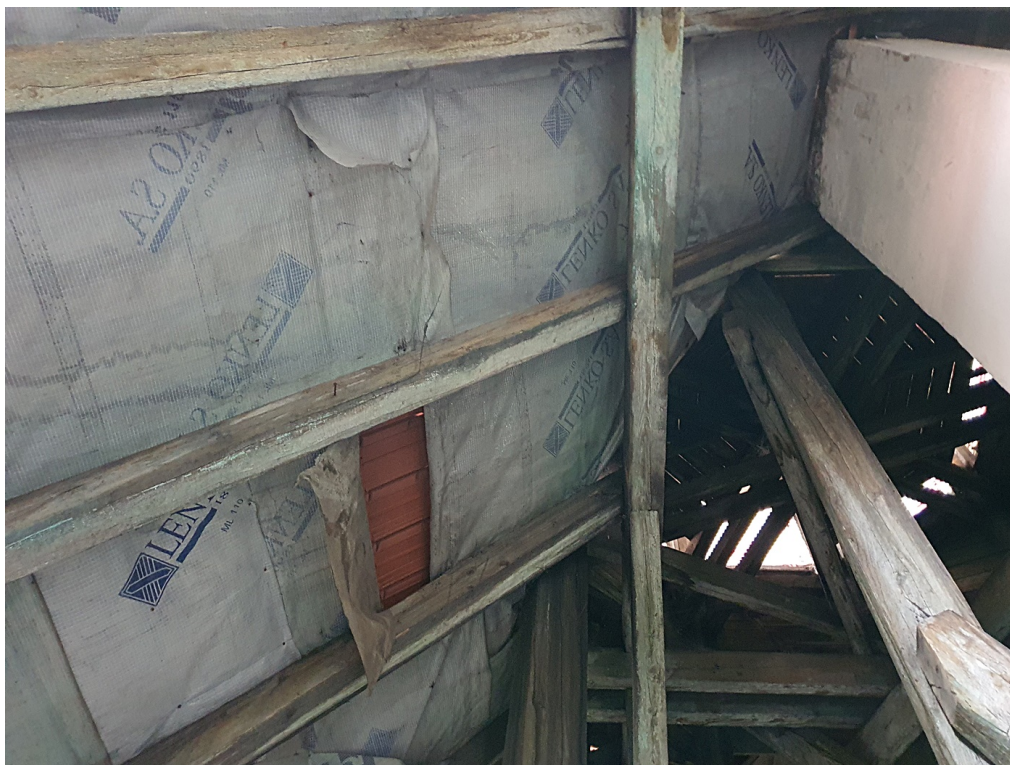
Fot 3; fragment pokrycia przy wieżyczce od strony południowej;
