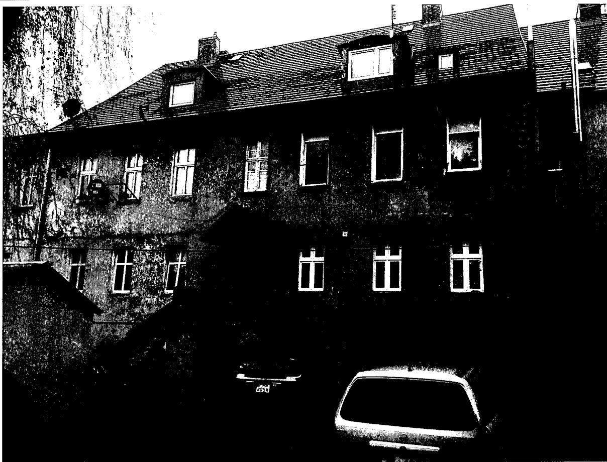
Fot. 3 Widok elewacji od podwórza (południowej).
