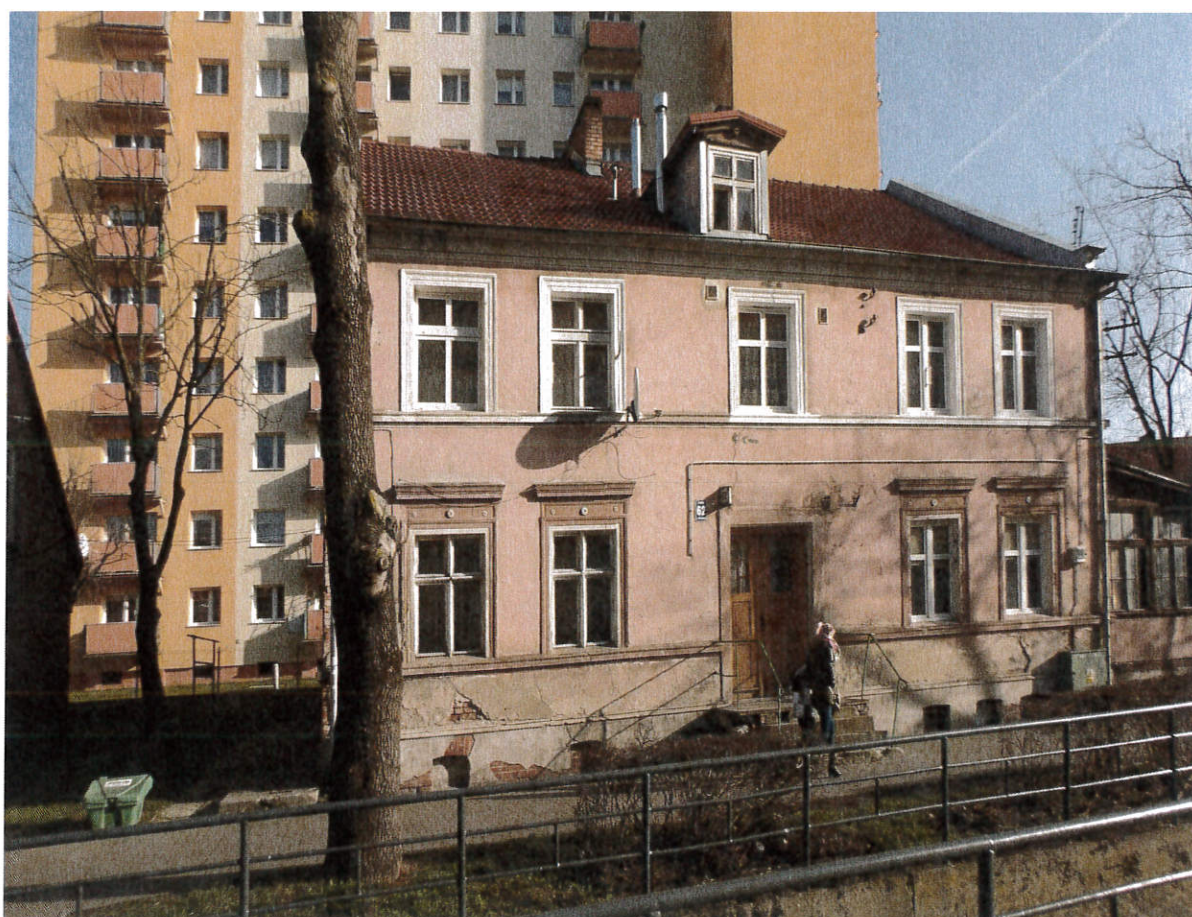
Widok na zachodnią elewację budynku
