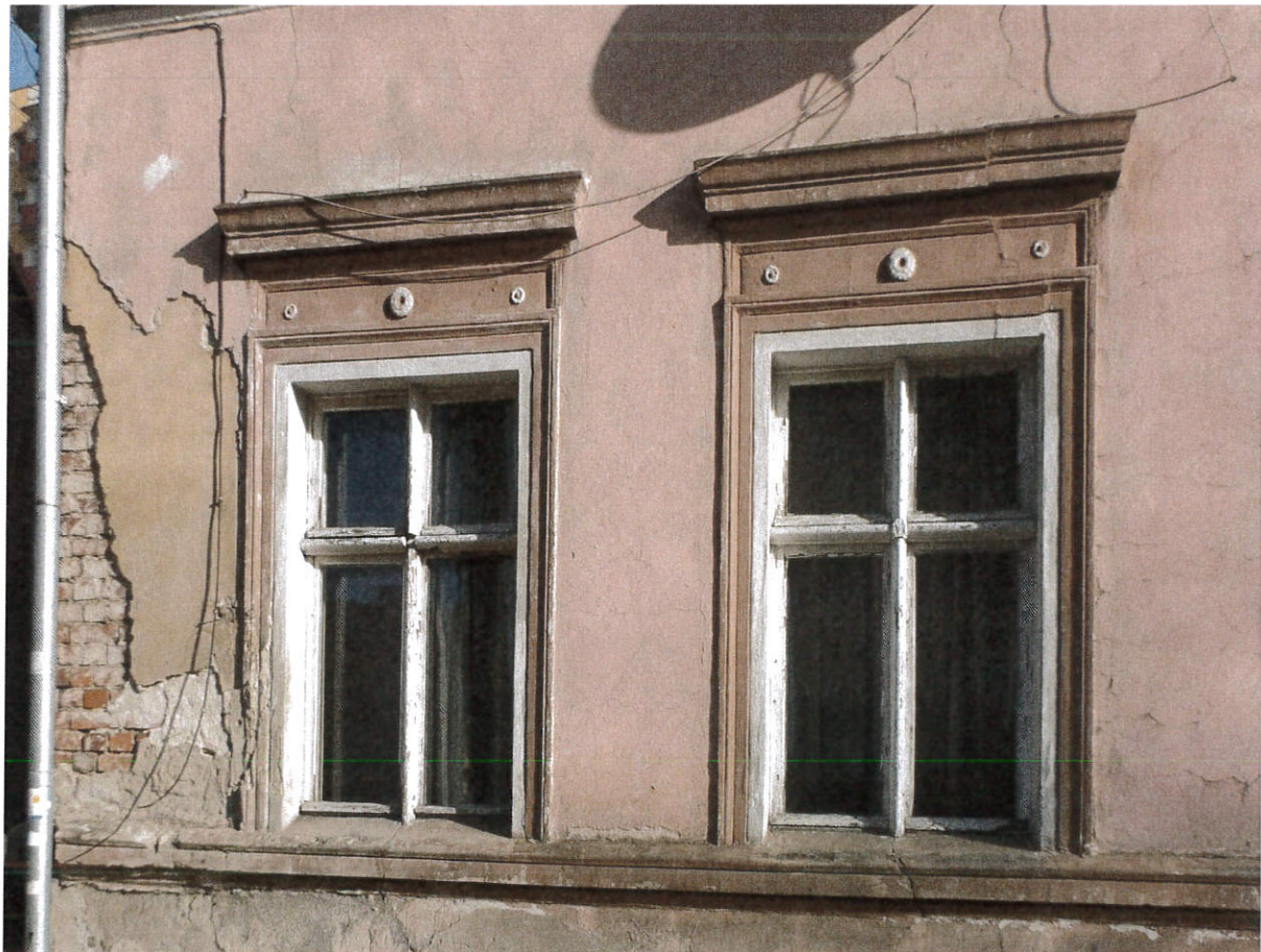
Stolarka okienna frontowej elewacji obiektu
