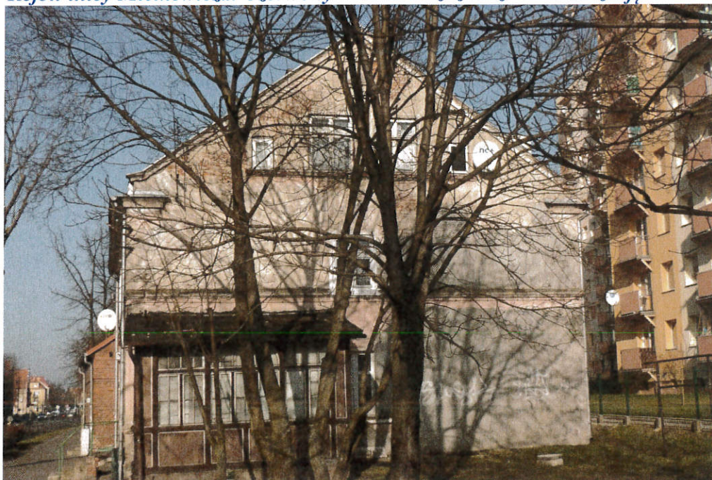
Południowa elewacja budynku. Widoczna drewniana weranda z początku XX wieku
