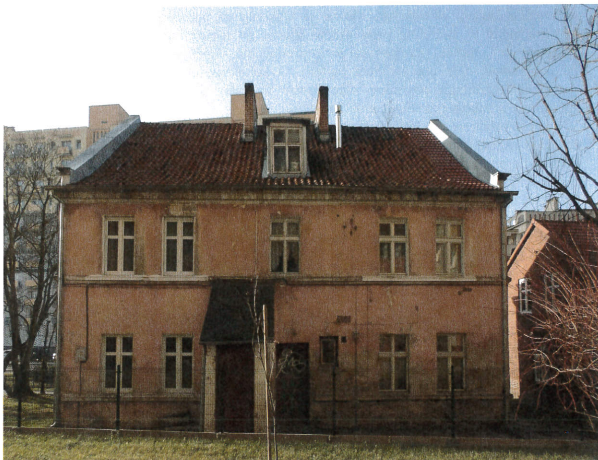
Widok elewacji tylnej budynku
