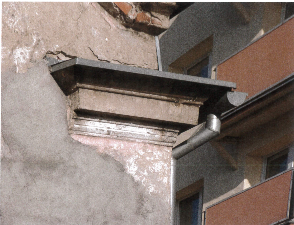
Gzyms podokapowy budynku
