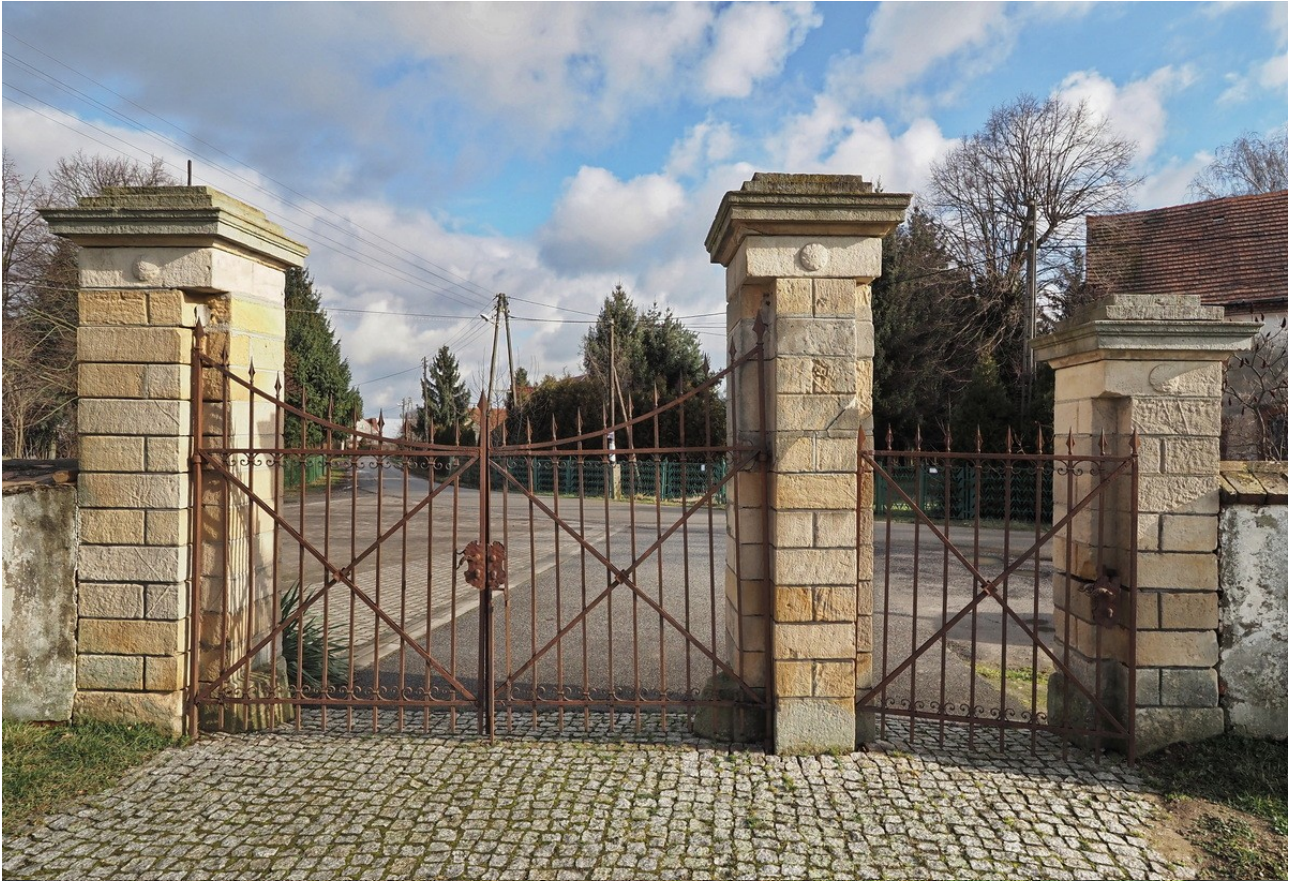
Fot. 5. Brama wschodnia – widok od strony kościoła.
