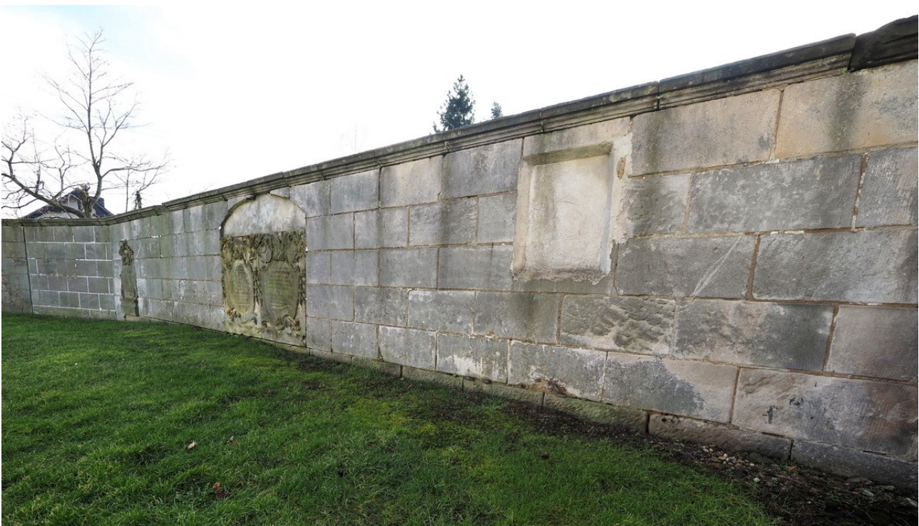
Fot. 22, 23. Widok na kamieniarkę piaskowcową południowej części muru: od strony kościoła.
