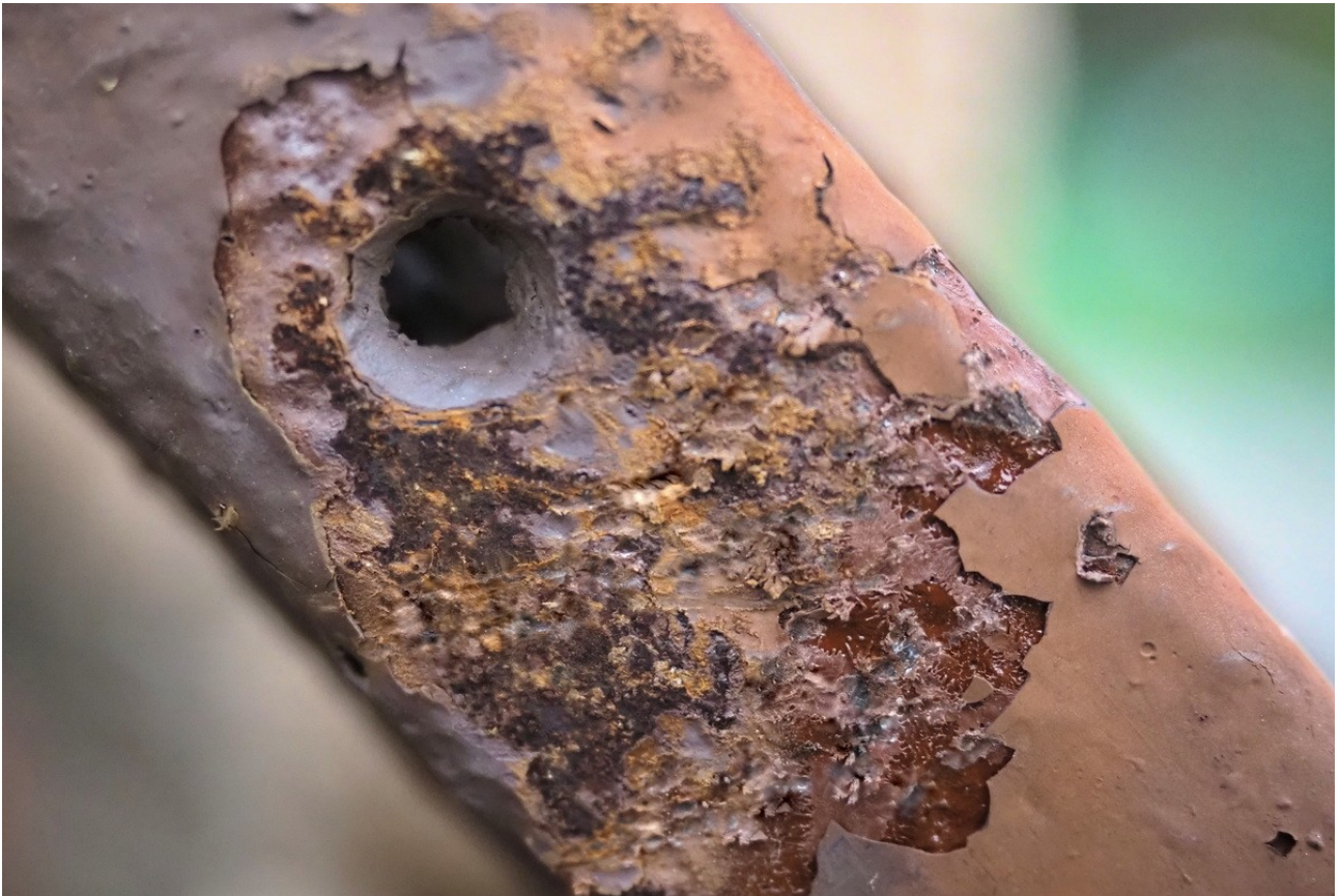
Fot. 14. Krata bramy wschodniej – przykładowy obszar, gdzie w miejscu złuszczenia się powłoki malarskiej widać układ stratygraficzny przemalowań.
