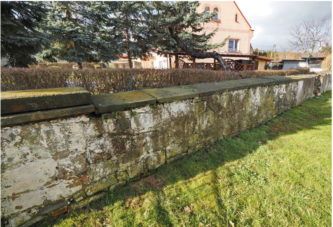
Fot. 34. Piaskowcowa wtórna nakrywa w południowo – zachodniej części muru.
