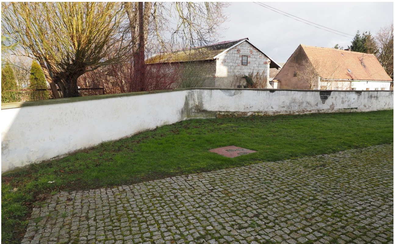
Fot. 45. Północna część muru. Widok od strony kościoła.
