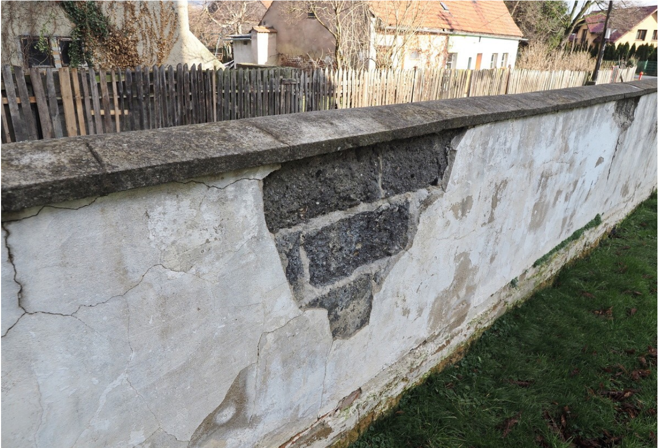
Fot. 46. Współczesna partia muru północnego wzniesiona z bloczków betonowych, z nakrywą opracowaną z zaprawy cementowej.
