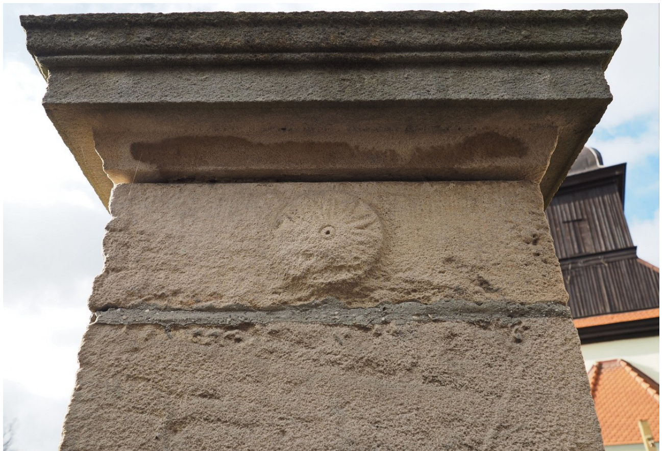
Fot. 9, 10. Brama wschodnia – stan zachowania kamieniarki, c.d.
