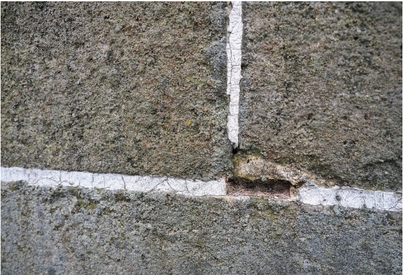
Fot. 31, 32. Spoina między blokami piaskowcowego muru południowego.
