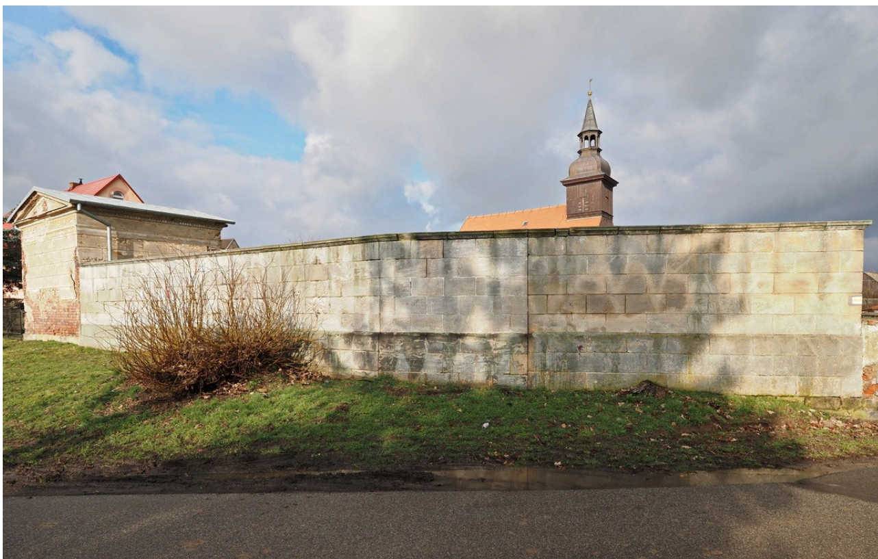
Fot. 1, 2. Widok na mur od strony ulicy: u góry – od wschodu, u dołu – od południowego wschodu.
