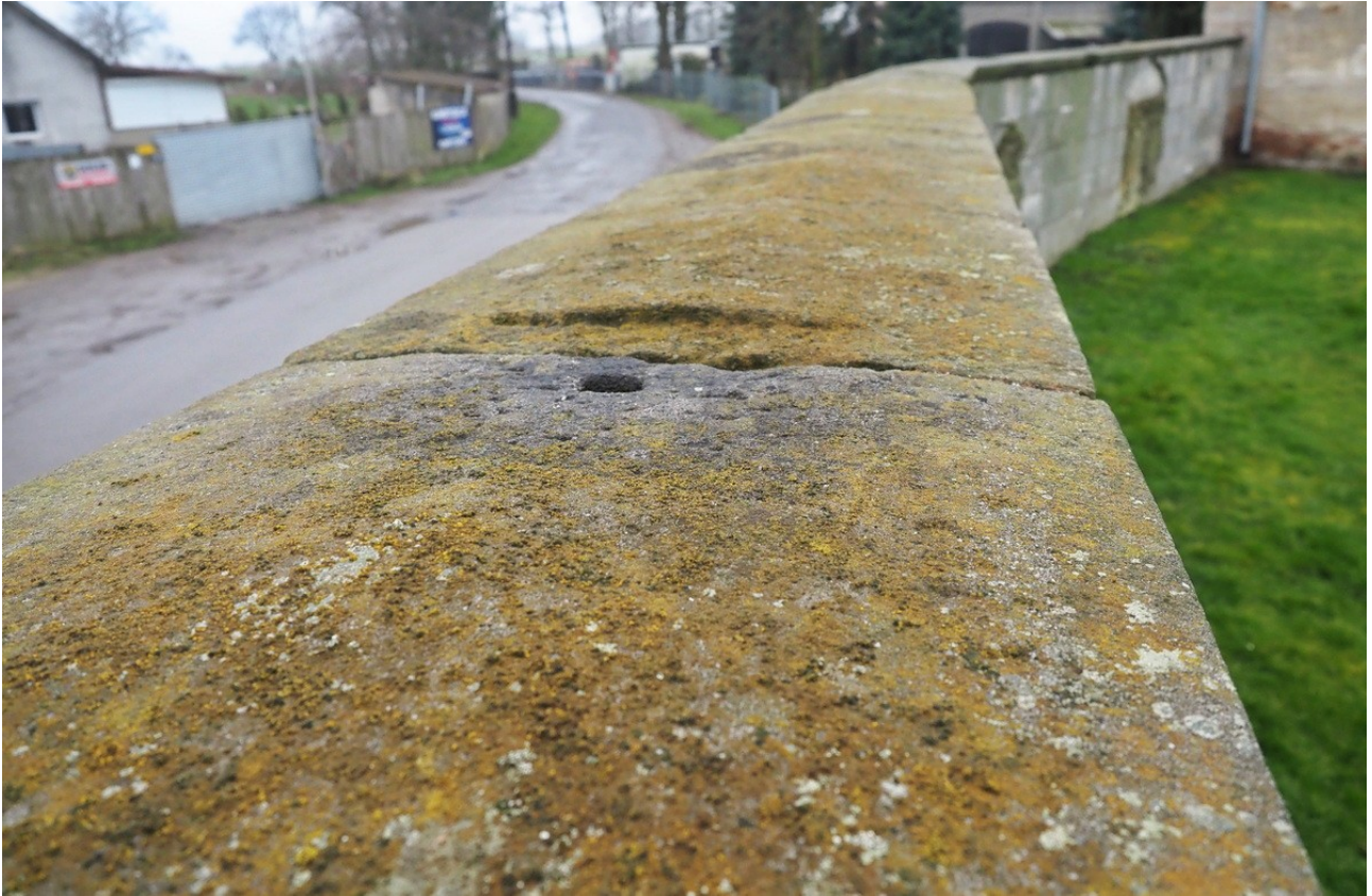
Fot. 26. Nakrywa piaskowcowa muru południowego.
