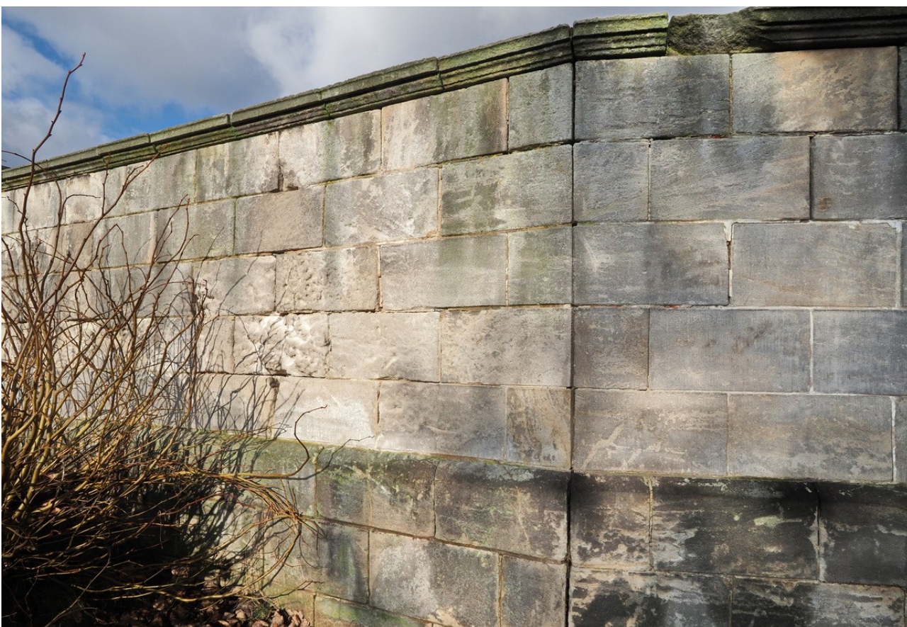
Fot. 3, 4. Widok na kamieniarkę piaskowcową w południowo – wschodniej części muru: od strony ulicy.
