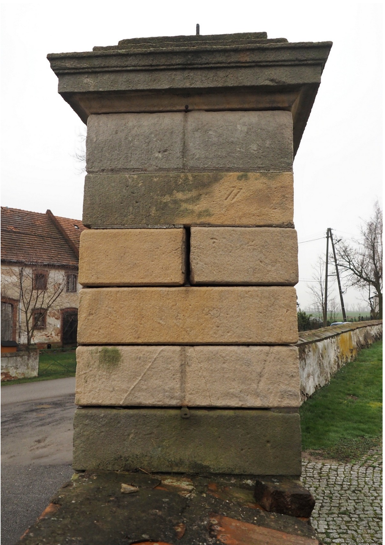
Fot. 11. Brama wschodnia – stan zachowania kamieniarki, c.d.
