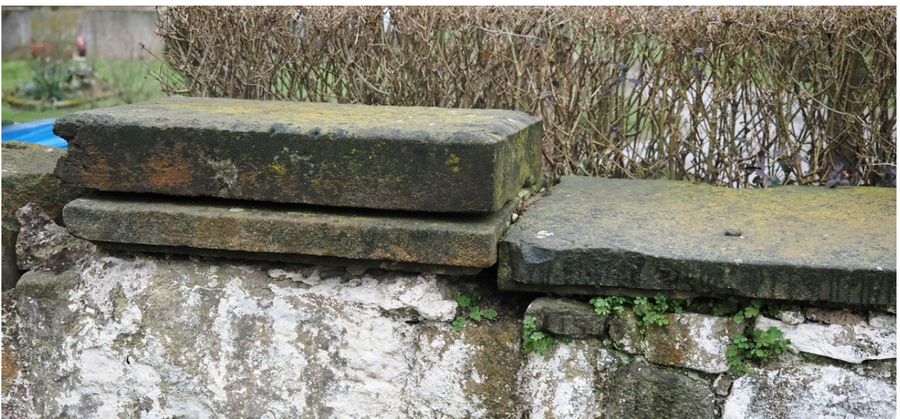
Fot. 35, 36, 37. Piaskowcowa wtórna nakrywa w południowo – zachodniej części muru, c.d.
