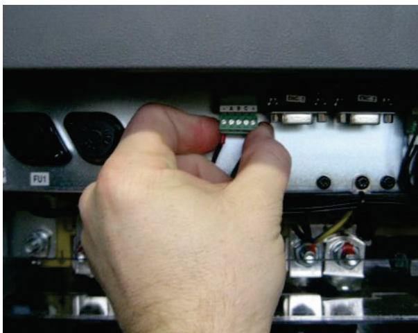
141 Odłączenie zacisków tachogenerators na przekształtniku przed robotami spawalniczymi
