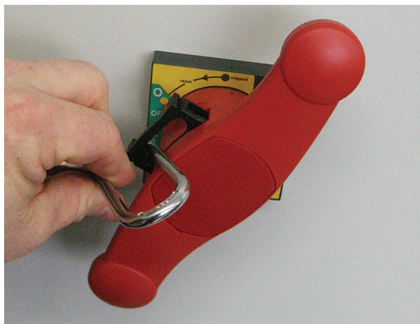
77 Zabezpieczenie wyłącznika głównego przed ponownym włączeniem
