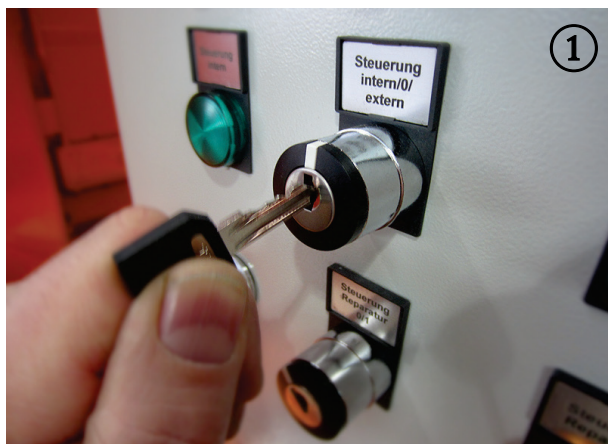
49 Przełącznik kluczykowy Sterowanie wewnętrzna/0/zewnętrzna
