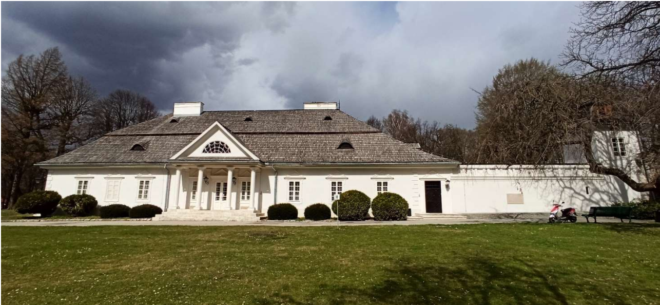
Fot.1 Widok elewacji frontowej Dworu wraz z wirydarzem i wieżyczką.
