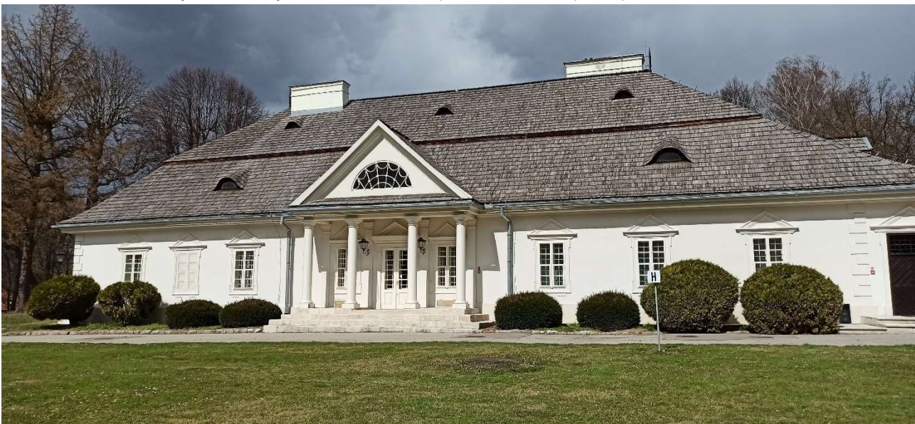
Fot.2 Zbliżenie na elewację frontową budynku głównego z czterokolumnowym portykiem.
