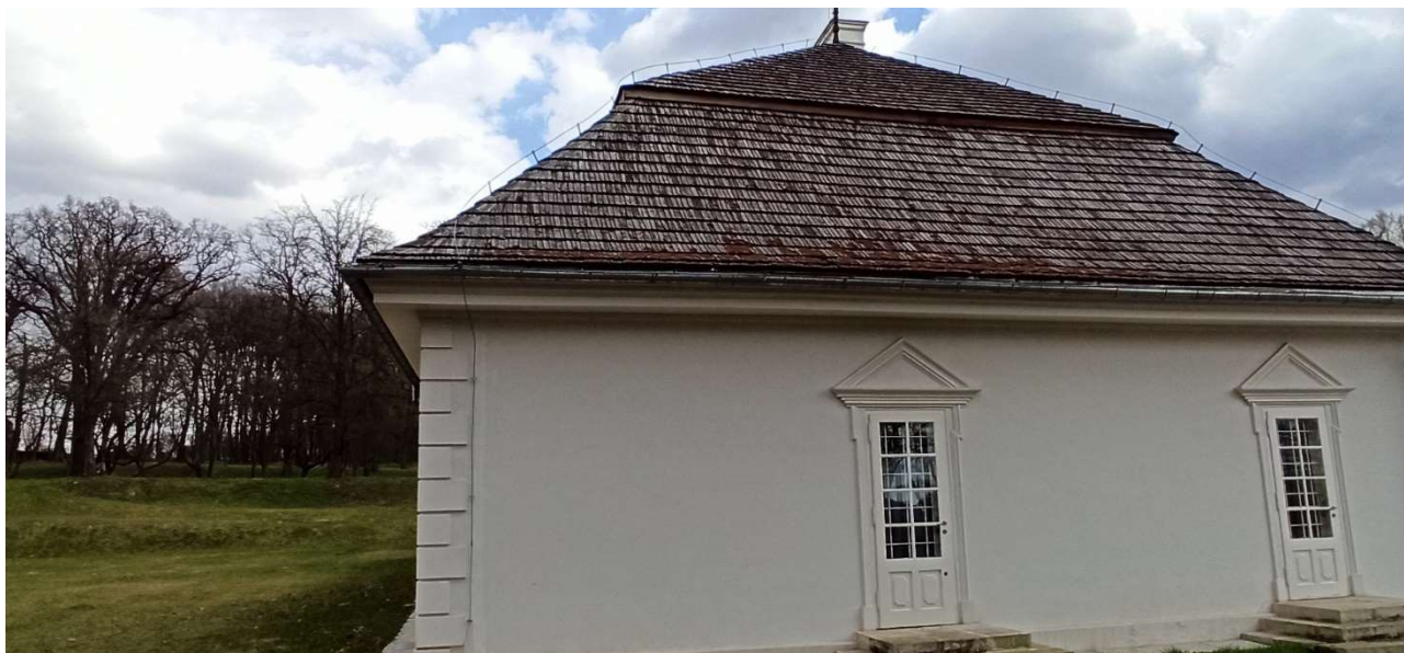
Fot.4 Widok na elewację zachodnią
