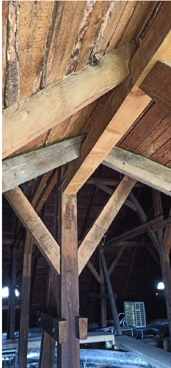
Fot. 12,13 Stan zachowania więzby dachowej i deskowania potłaci
