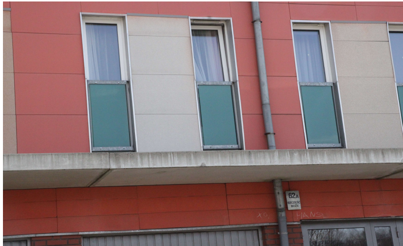
Rys. nr 16. Zacieki na płycie betonowej, odkształcenia i odchylenia płytek elewacyjnych. [1.3]
