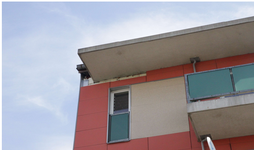
Rys. nr 17. Miejscowe ubytki płyt elewacyjnych z odkryciem materiału izolacyjnego, zacieki i zabrudzenia płyty betonowej od spodu. [1.3]
