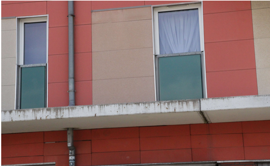
Rys. nr 33. Odształcenia rury spustowej, zabrudzenia czoła płyty betonowej. [1.3]
