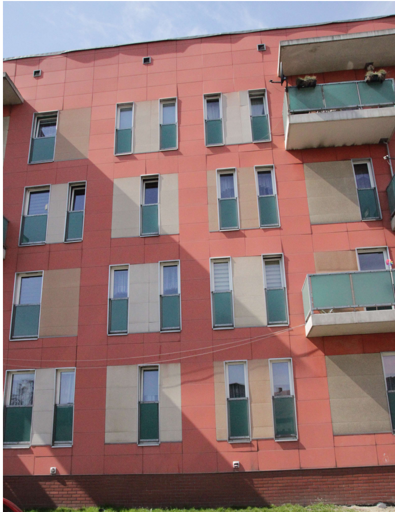
Rys. nr 21. Miejscowe zniszczenia, odchylenia i odkształcenia elewacyjnych płytek poliestrowych. [1.3]
