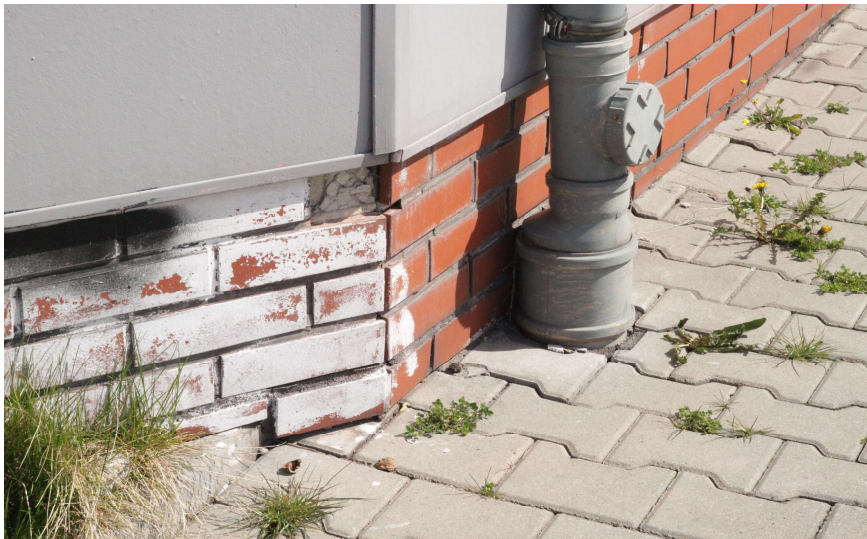
Rys. nr 14. Miejscowe ubytki płytek klinkierowych w ścianie przyziemia. [1.3]
