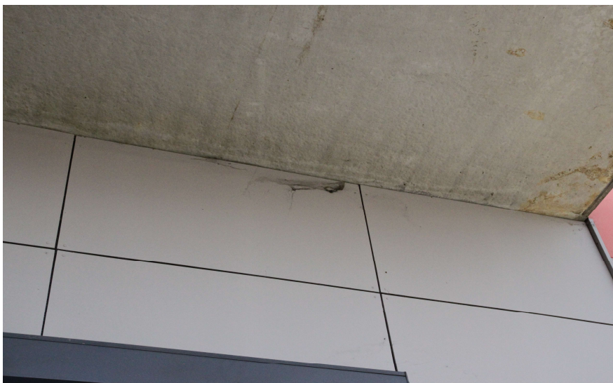
Rys. nr 10. Wysolenia i miejscowe zacieki na spodzie płyt betonowych. [1.3]
