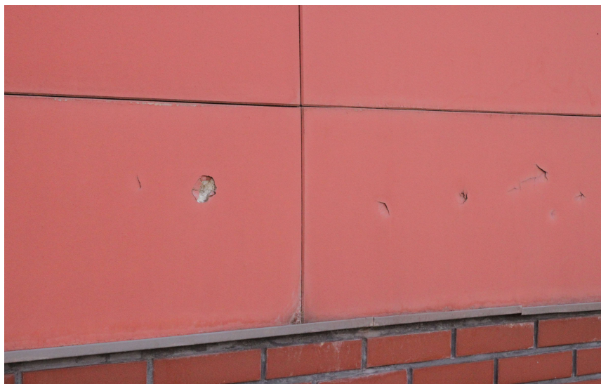
Rys. nr 17. Miejscowe ubytki płyt elewacyjnych z odkryciem materiału izolacyjnego, zacieki i zabrudzenia płyty betonowej od spodu. [1.3]
