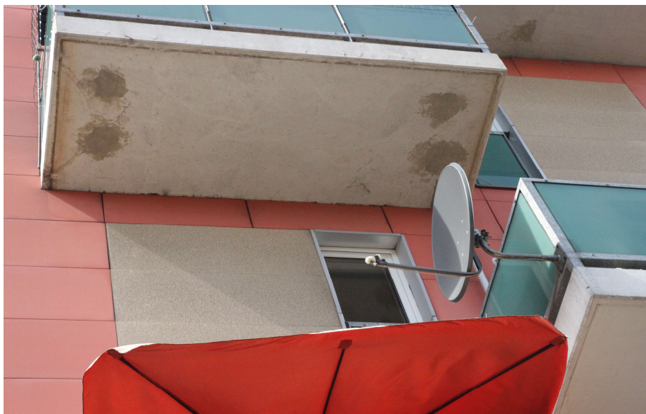
Rys. nr 31. Lokalne zabrudzenia płyty balkonowej od spodu. [1.3]
