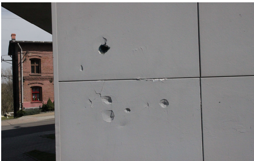
Rys. nr 12. Zniszczone elewacyjne płyty poliestrowe. [1.3]
