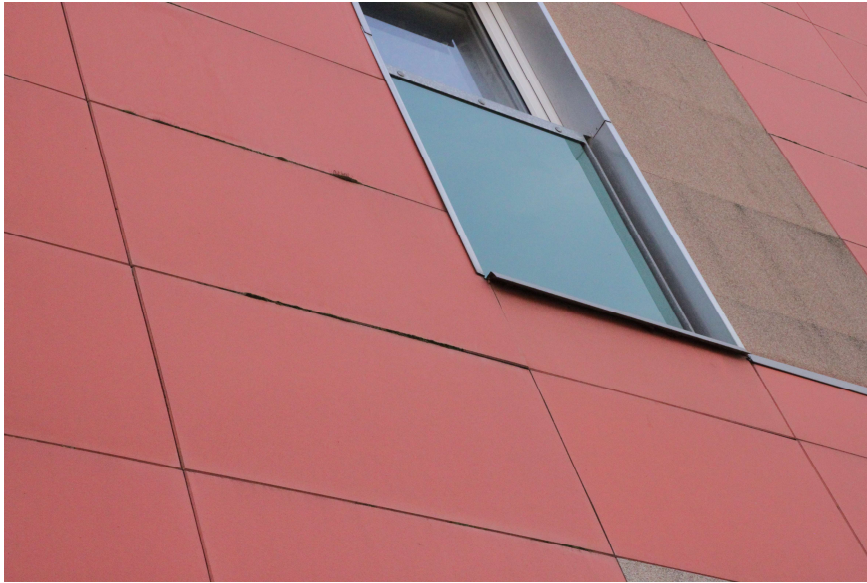
Rys. nr 18,19. Miejscowe zniszczenia, odchylenia i odkształcenia elewacyjnych płytek poliestrowych. [1.3]
