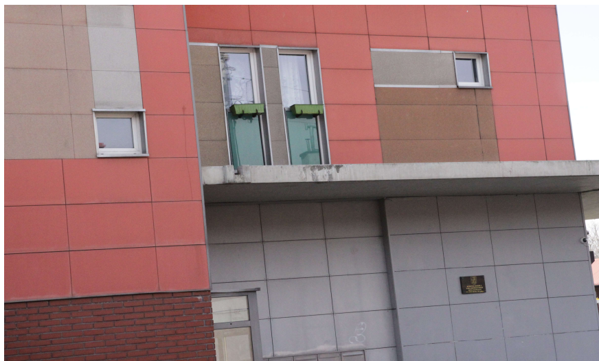
Rys. nr 7. Odkształcenia i przebarwienia płyt poliestrowych, zacieki na płycie – brak obróbki blacharskiej. [1.3]
