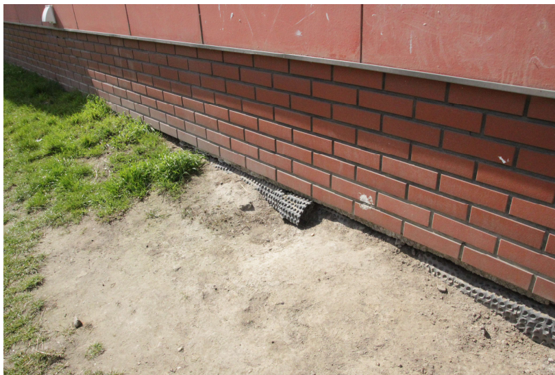
Rys. nr 26. Izolacja przeciwwilgociowa ścian przyziemia przedmiotowego budynku. [1.3]
