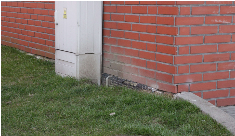
Rys. nr 35. Izolacja przeciwwilgociowa ścian przyziemia, miejscowe wypłukanie zaprawy z fug spomiędzy cegieł klinkierowych. [1.3]
