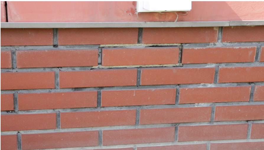
Rys. nr 28. Miejscowe wypłukanie zaprawy spomiędzy cegieł klinkierowych. [1.3]
