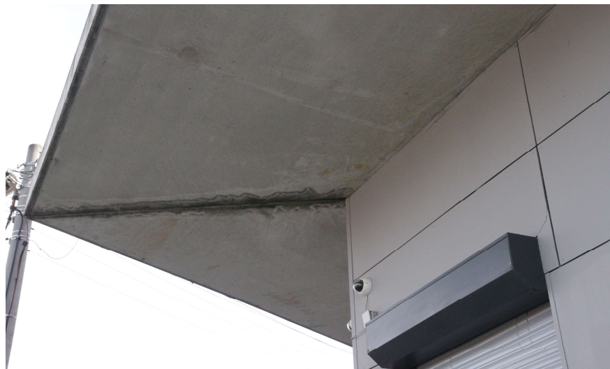
Rys. nr 11. Wysolenia i miejscowe zacieki na spodzie płyt betonowych, brak odpowiedniej obróbki blacharskiej. [1.3]
