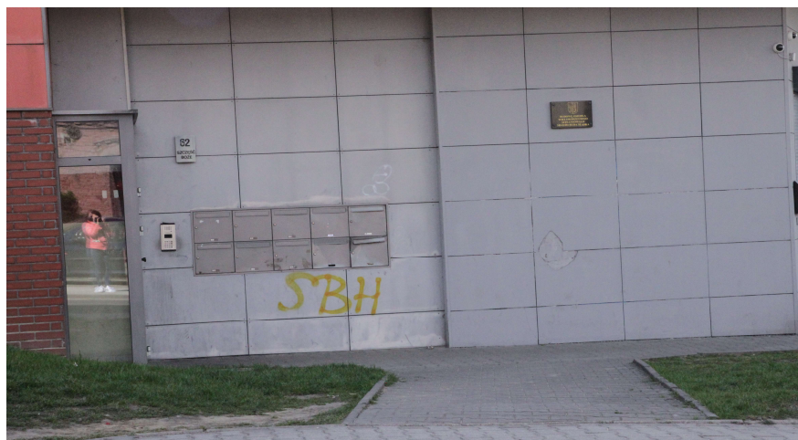
Rys. nr 8. Odkształcenia i przebarwienia płyt poliestrowych, napisy graffiti na płytach, uszczerbienie płyt. [1.3]
