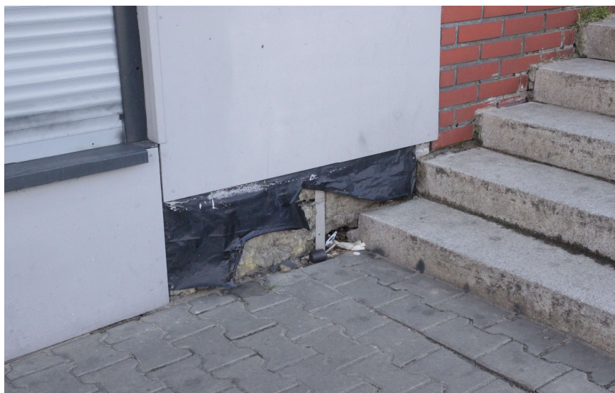
Rys. nr 9. Brak powłoki elewacyjnej przy ścianie przyziemia. [1.3]
