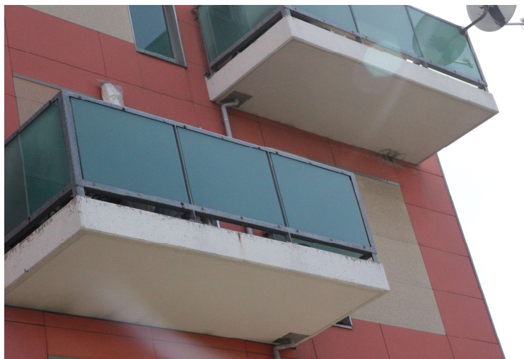
Rys. nr 23,24. Zniszczenia, zacieki i miejscowe wysolenia na płytach betonowych, odkształcenia i odchylenia . [1.3]
