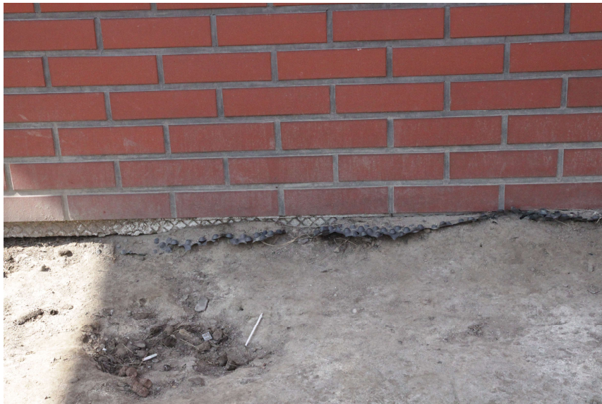
Rys. nr 20. Izolacja przeciwwilgociowa ścian przyziemia. [1.3]
