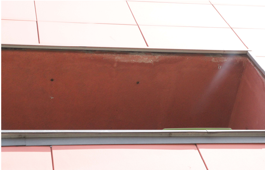
Rys. nr 13. Wysolenia płyt loggii. [1.3]
