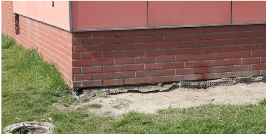
Rys. nr 30. Widok izolacji przeciwwilgociowej ścian przyziemia, brak odpowiedniego zakończenia. [1.3]
