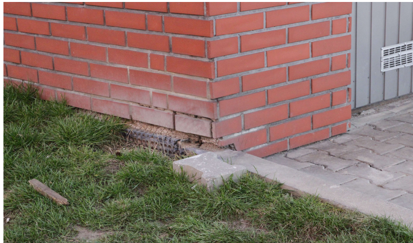
Rys. nr 25. Miejscowe wypłukanie zaprawy spomiędzy cegieł klinkierowych, widok izolacji przeciwwilgociowej ścian przyziemia. [1.3]
