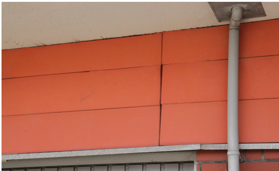
Rys. nr 34. Odchylenia płyt elewacyjnych. [1.3]
