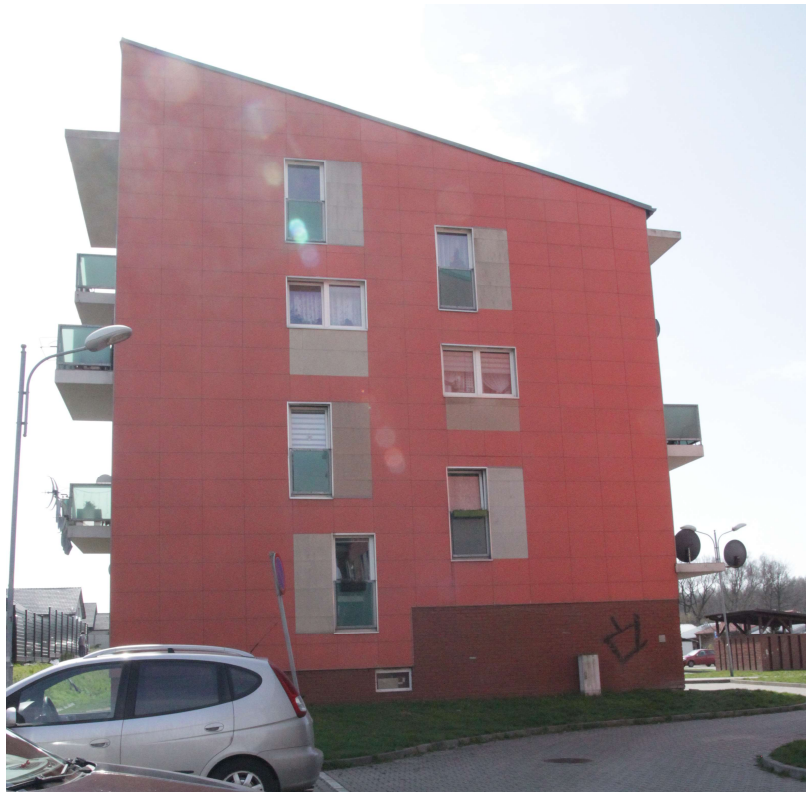
Rys. nr 25. Zniszczenia ściany klinkierowej, miejscowe odchylenia i odkształcenia elewacyjnych płyt poliestrowych. [1.3]
