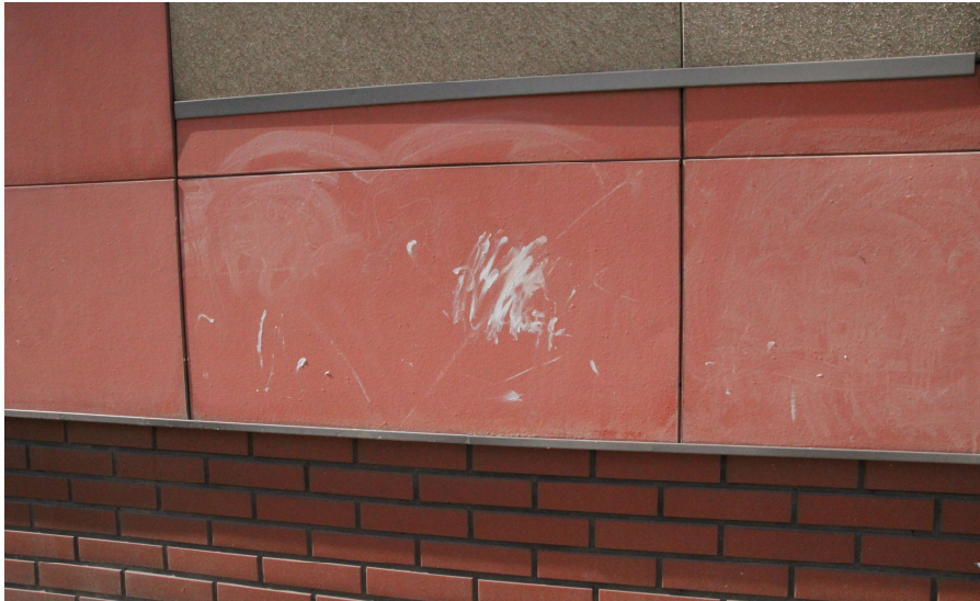
Rys. nr 27. Przebarwienia na płytach elewacyjnych. [1.3]
