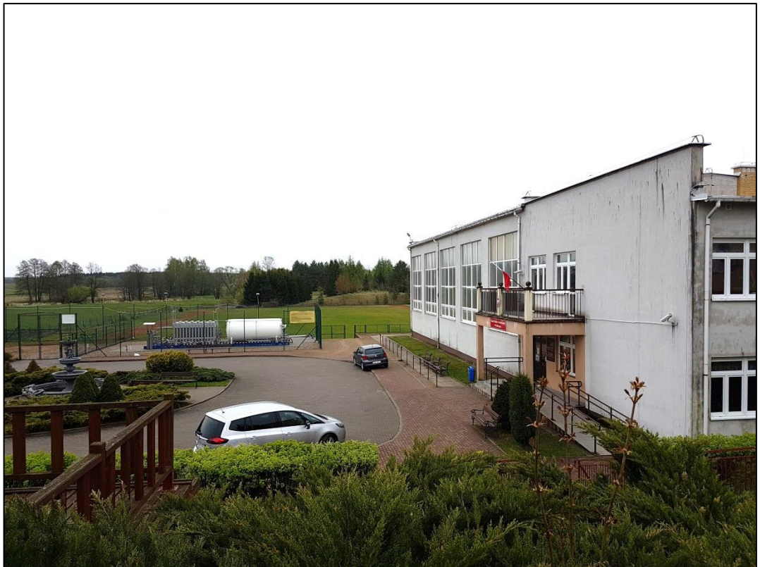
Widok stacji regazyfikacji przy sali sportowej
