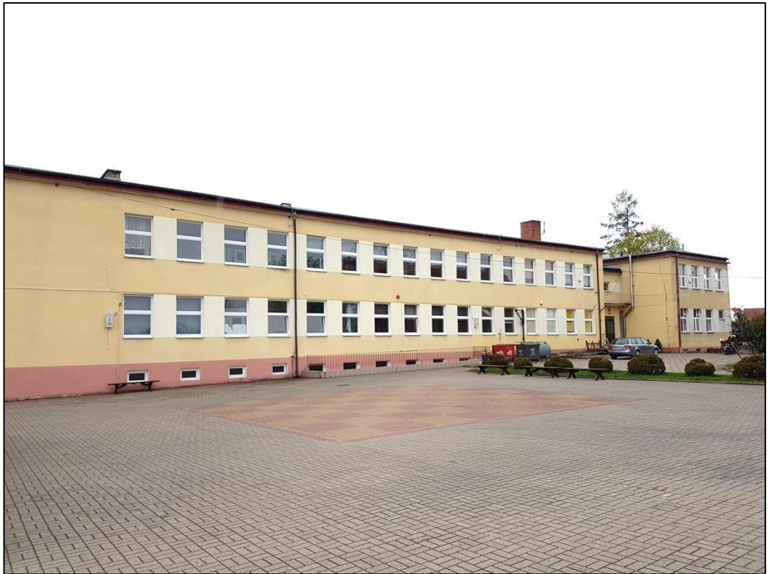
Widok elewacji wschodniej starszej części budynku z wejściem głównym do szkoły
