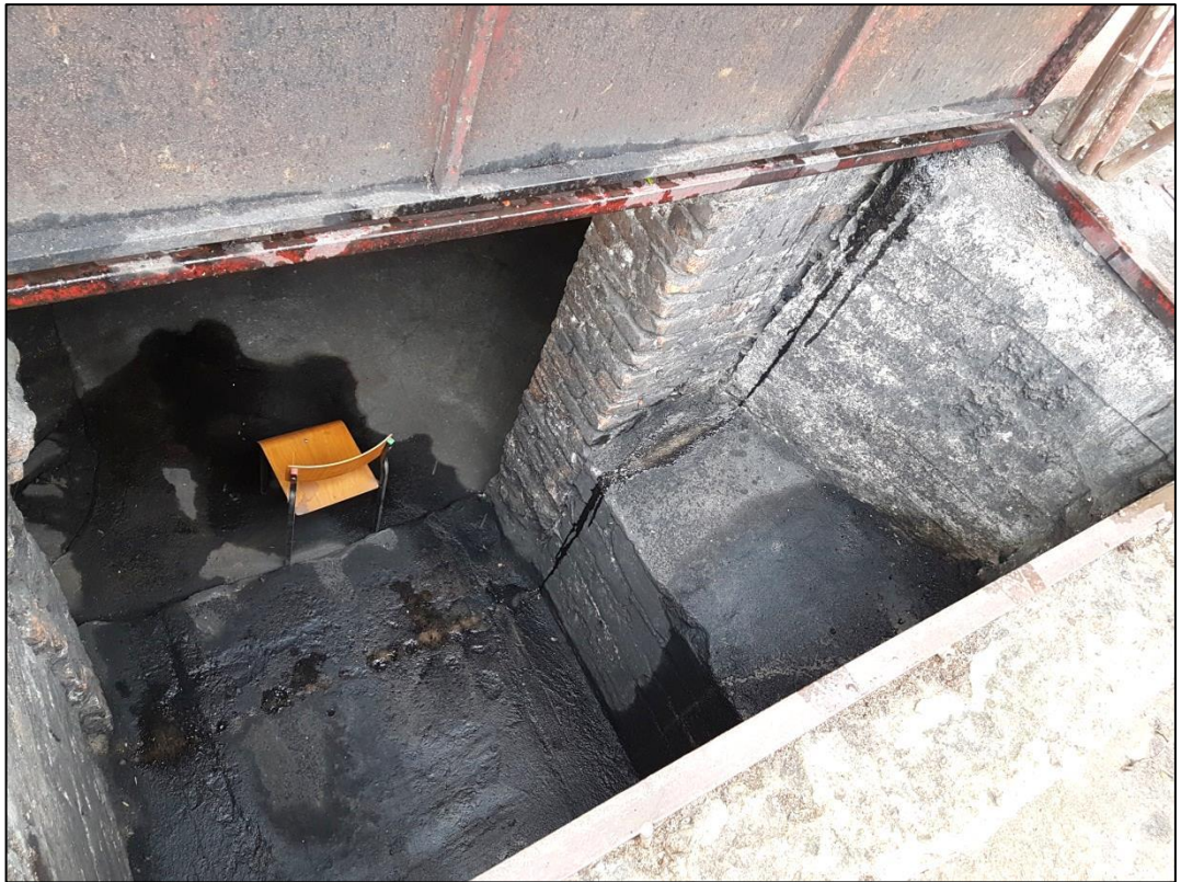
Widok zsypu węglowego kotłowni z zewnątrz budynku
