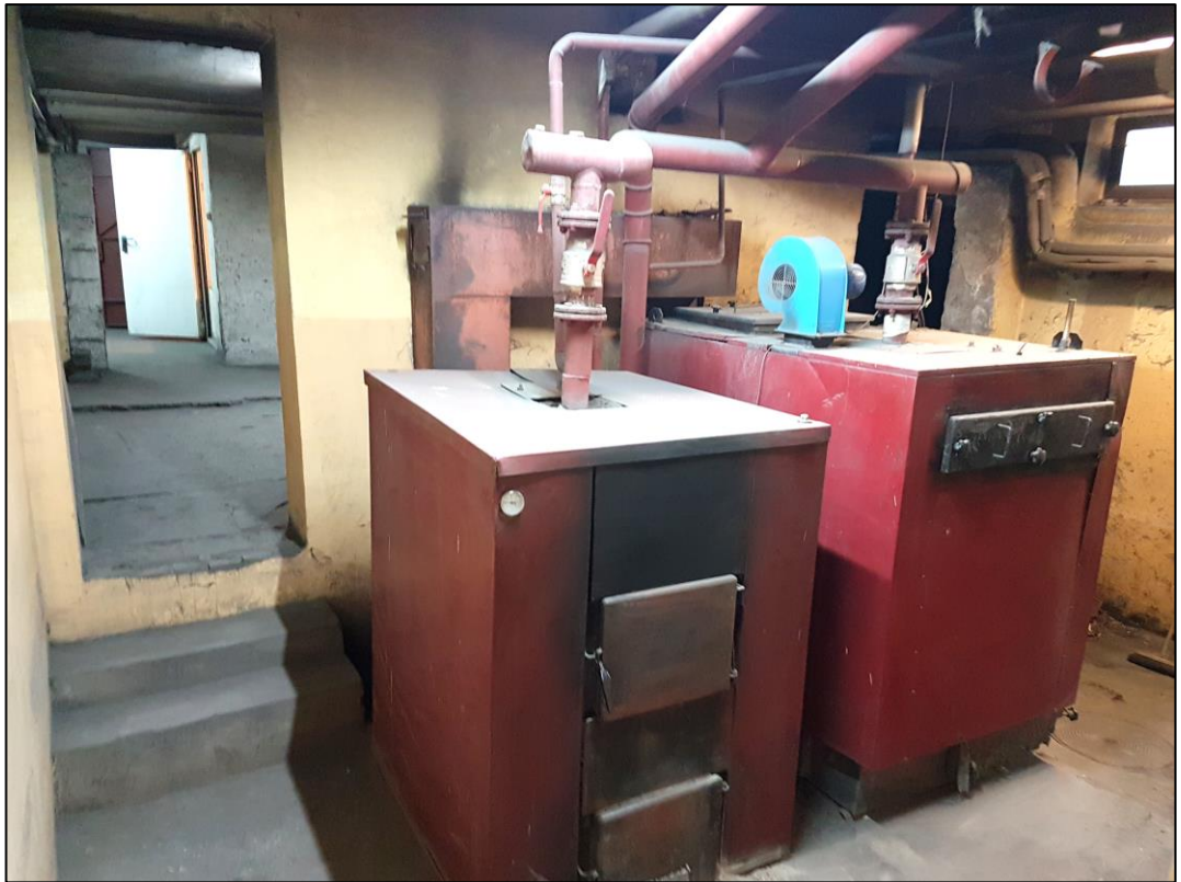
Widok kotłowni z kotłami węglowymi do likwidacji
