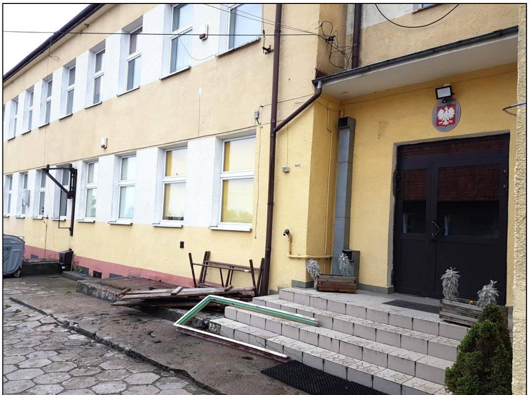
Widok wejścia głównego do budynku oraz zsyków węglowych do kotłowni
