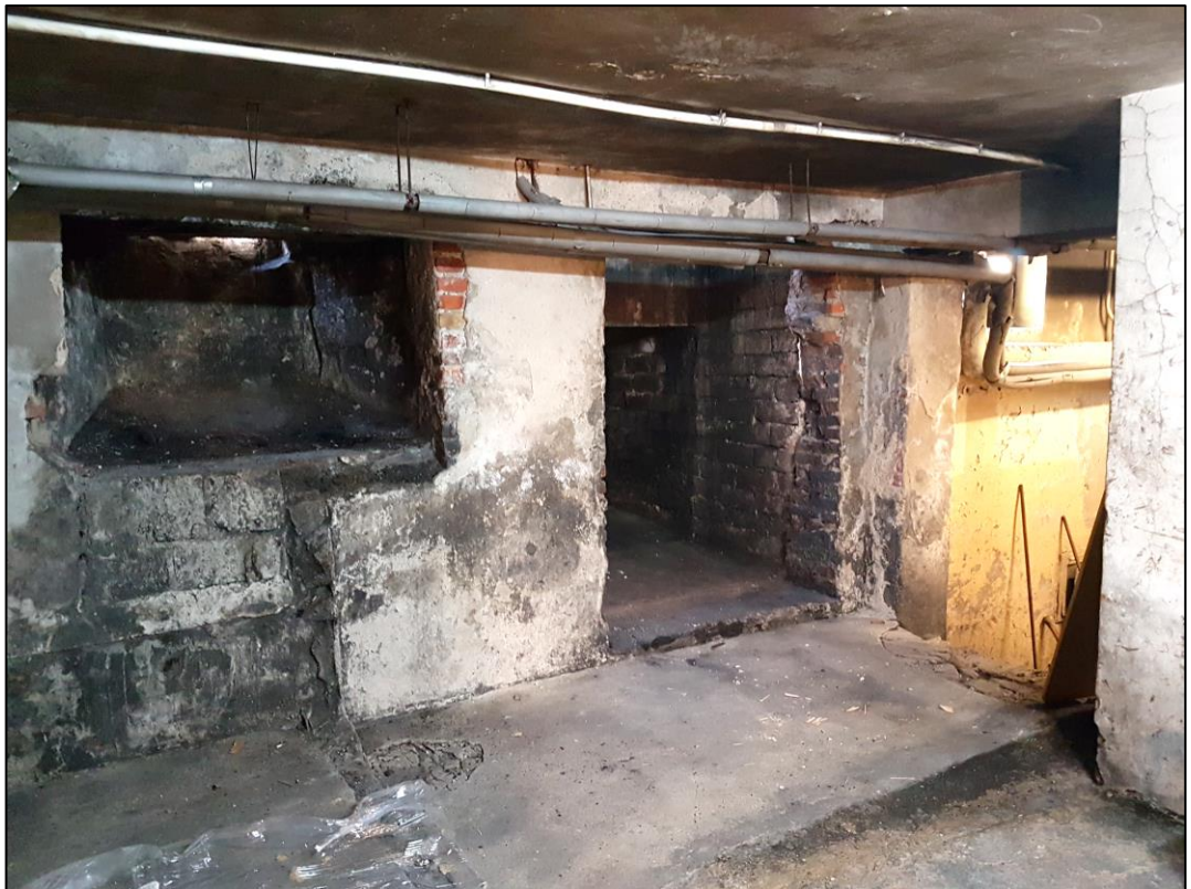
Widok zsypu węglowego z pomieszczenia kotłowni
