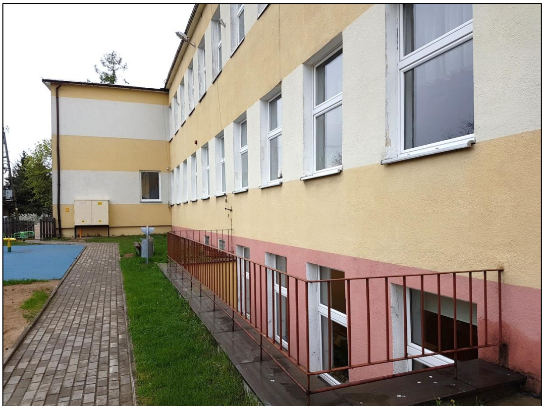
Widok zachodniej elewacji starej części budynku z przyłączem gazowym w szafce
