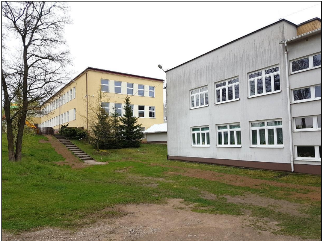
Widok zachodniej elewacji obu części budynku
