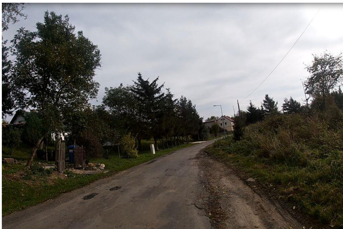
Zdj. nr 4 Końcowa część drogi
