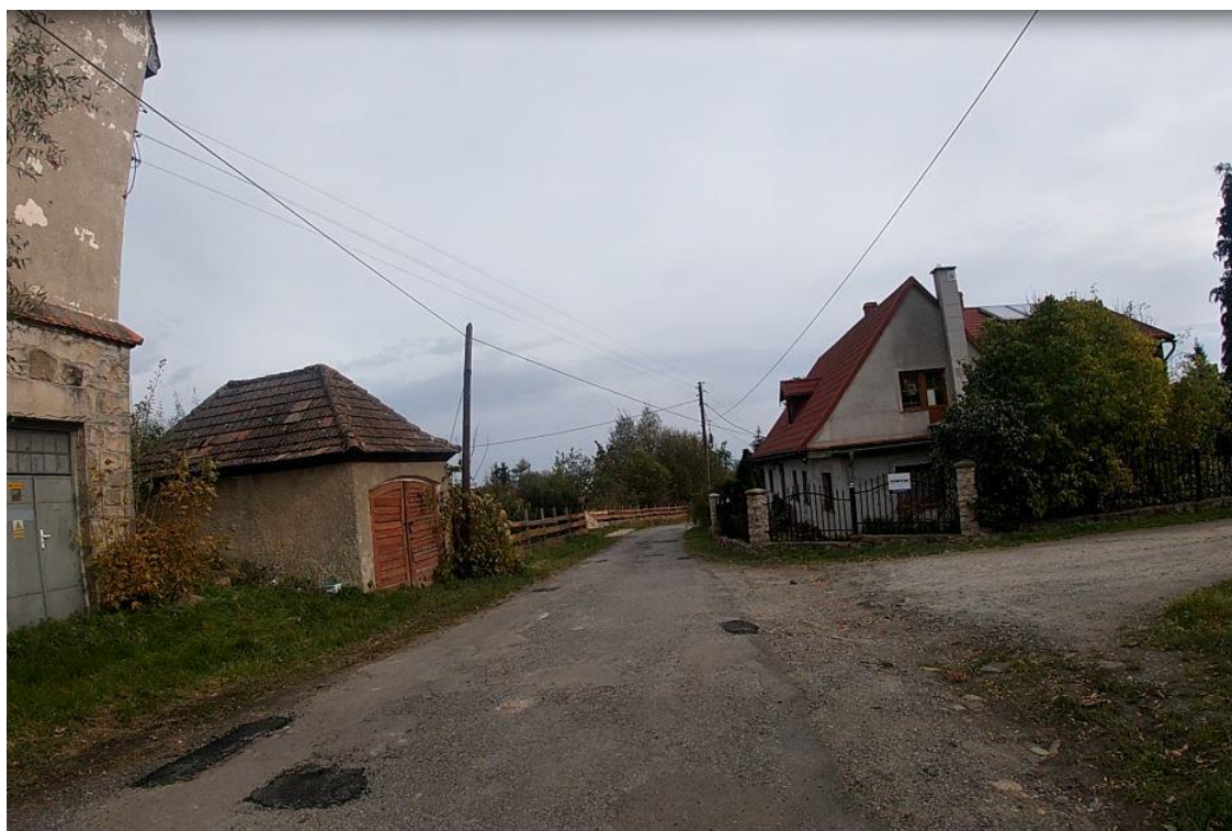
Zdj. nr 2 Początkowy odcinek drogi
