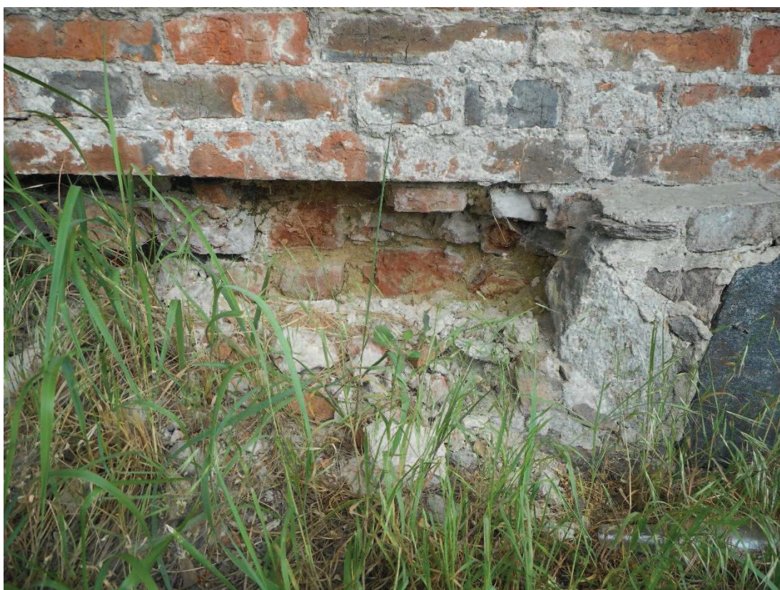
Fot. 8 Zabudowania pocysterskiego klasztoru w Owińskach. Ośrodek Szkolno- Wychowawczy dla Dzieci Niewidomych. Mur graniczny od strony ul. Cysterek. Brak odspojonych fragmentów lica części fundamentowej z widocznym wypełnieniem murowanym na „chudej” zaprawie wapiennej.
