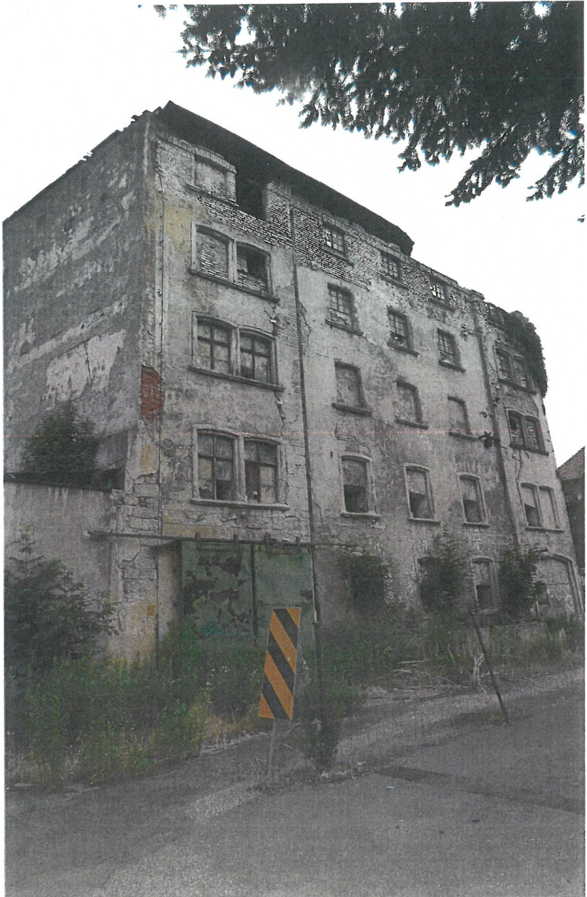
Widok ogólny ściany frontowej i bocznej budynku.
