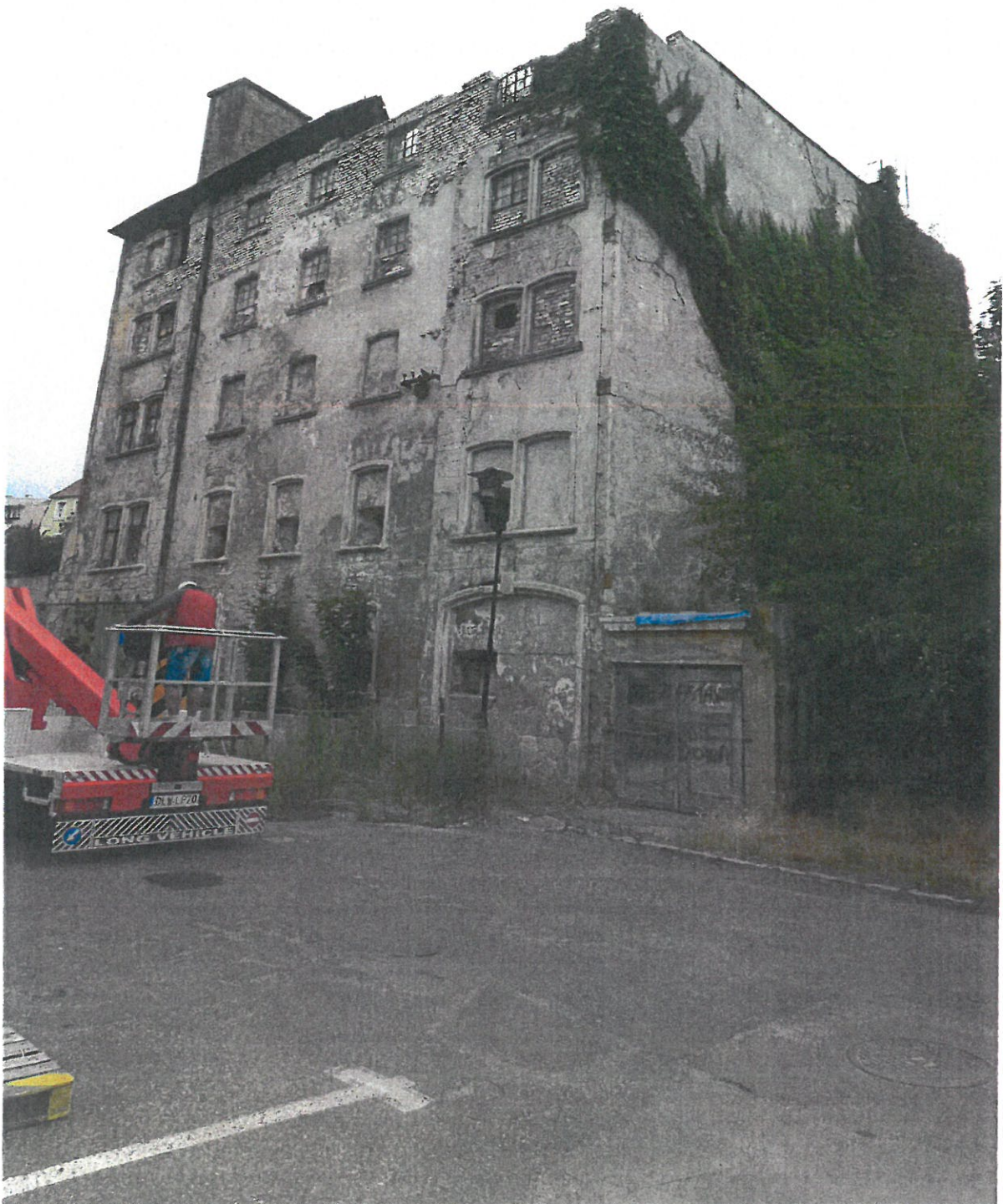
Widok ogólny ściany frontowej i bocznej budynku.
