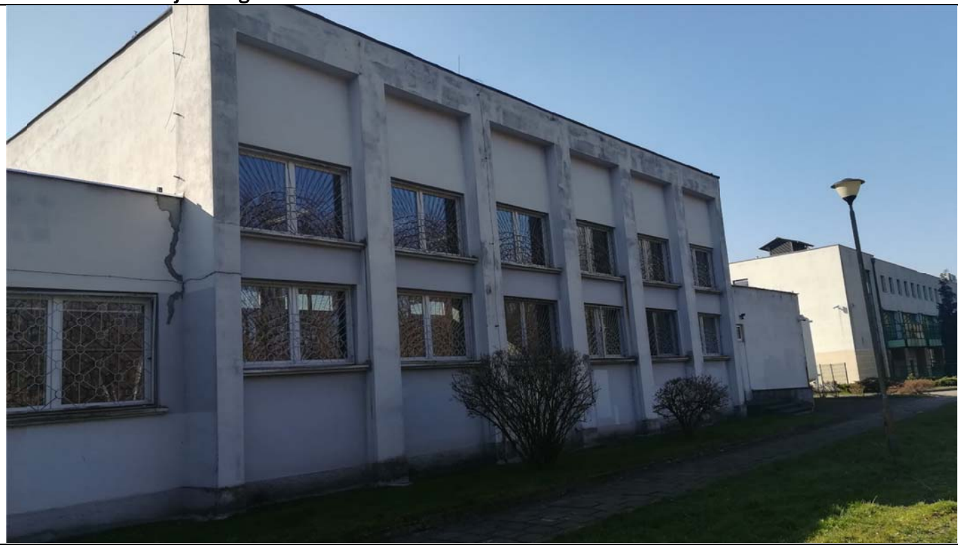
Budynek mieszczący bibliotekę – widok z zewnątrz
