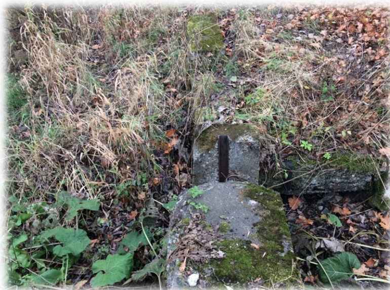
Ilustracja 33. Zastawka piętrząca w hm 2+12 na rowie nr 5 w zlewni nr 2 .
