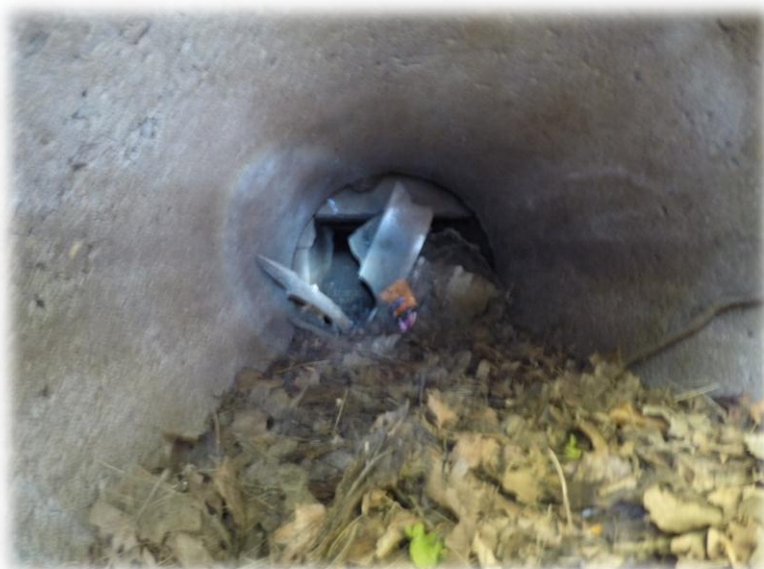
Ilustracja 24. Skanalizowany odcinek rowu nr5 w hm 4+19÷4+21 – widoczne przetamowanie i w dalszej części zamulenie kanału.
