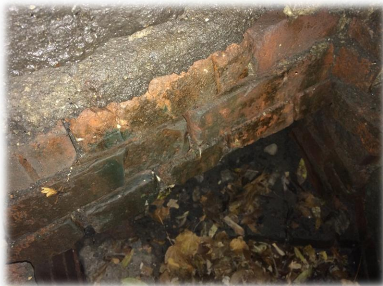
Ilustracja 35. Studnia kanalizacyjna z początkiem kanału o przekroju prostokątna o wym 0,4 x 0,4m.
