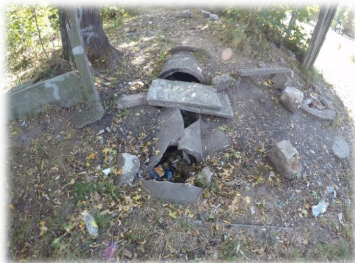
Ilustracja 3. Skanalizowany odcinek rowu w hm 0+30 – widoczne zapadliska na redukcji średnicy z DN800 na DN600.
