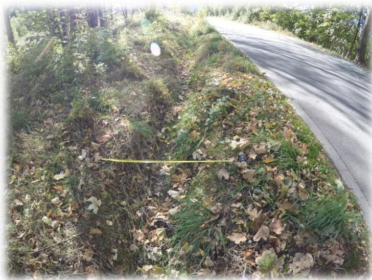
Ilustracja 14. Widok na odcinek rowu nr 4 przy niezamieszkałych nieruchomościach – rów utracił przekrój regulacyjny, co w znaczący sposób ogranicza jego przepustowość.
