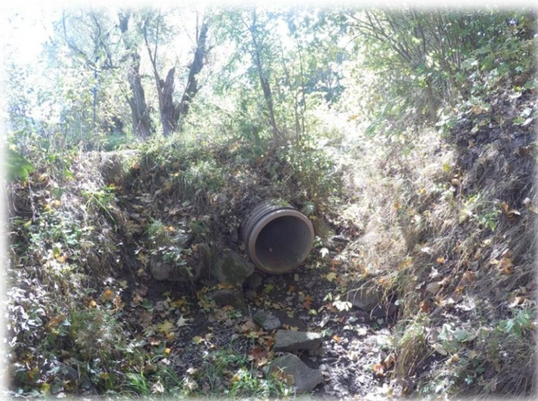
Ilustracja 9. Wylot z przepustu pod drogą gruntową w hm 4+66 oraz na ujście rowu drogowego odwadniającego ul. Lipową.
