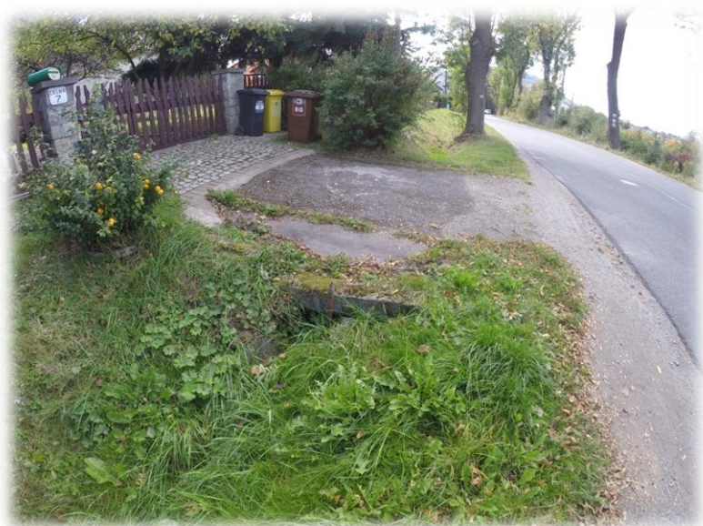
Ilustracja 29. Widok na odcinek rowu nr 7 porośniętego wysoką trawą przed wlotem do przepustu.
