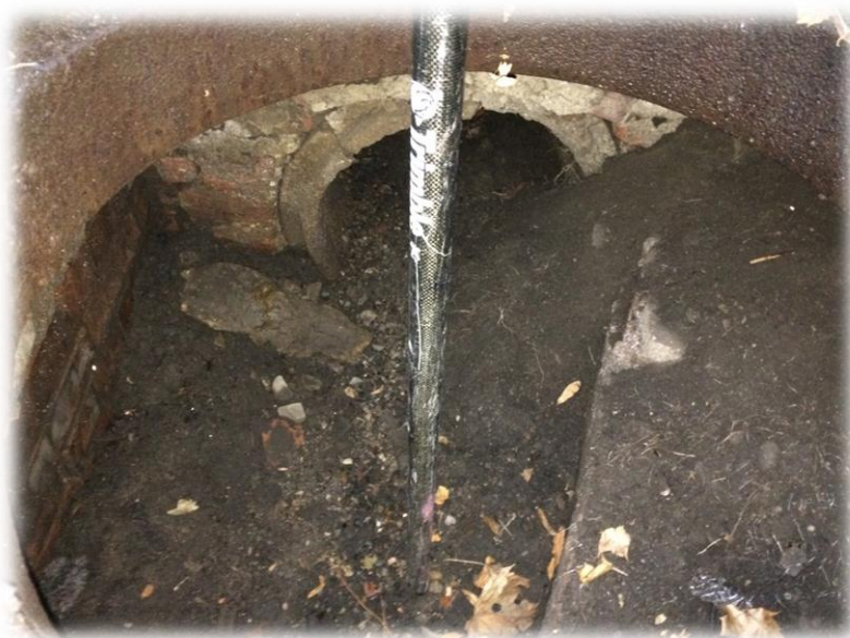
Ilustracja 34. Studnia z kanalizacją deszczową DN500. Widoczne nieszczelności studzienki i obsypanie gruntu .
