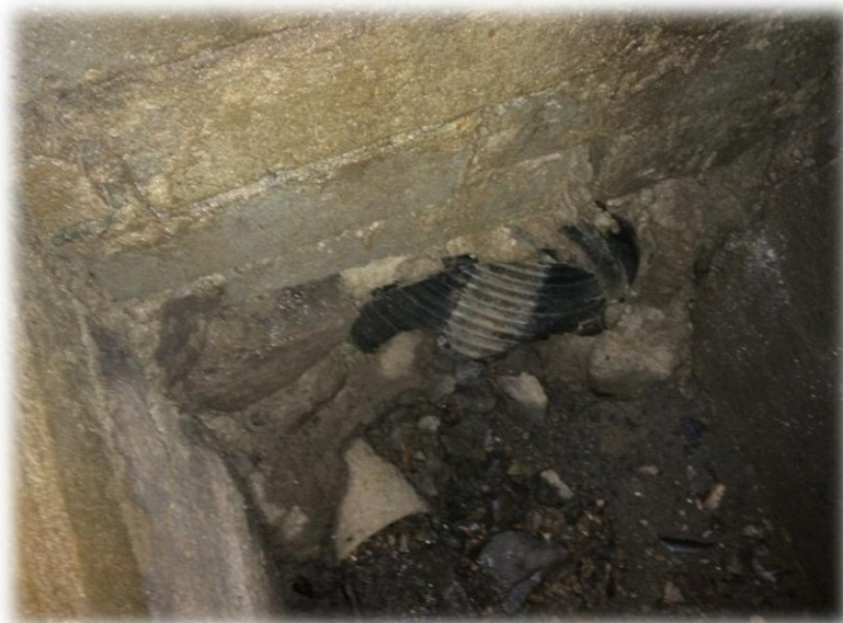
Ilustracja 36. Studnia z kanalizacją DN300. Poniżej ujście kanalizacji DN150 odwadniającej pobliskie osiedle.
