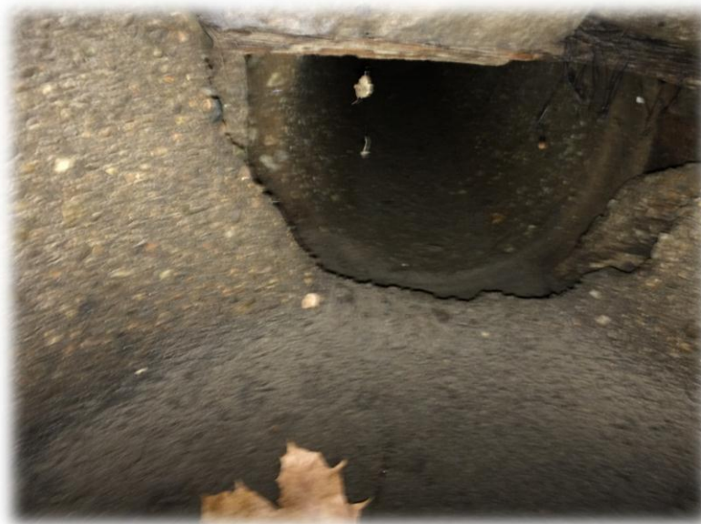
Ilustracja 37. Studnia kanalizacyjna do której wprowadzono rów nr 3. Widoczne nieszczelności pomiędzy studnią a rurociągiem kanalizacji deszczowej.
