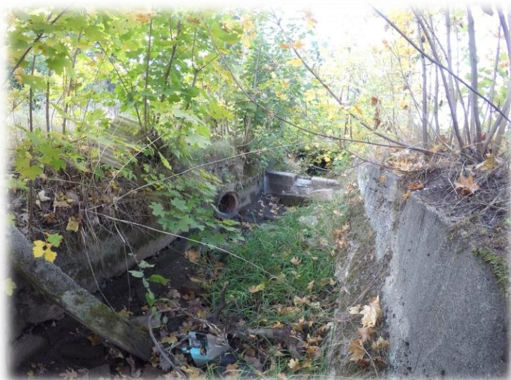
Ilustracja 32. Zastawka piętrząca w hm 2+42 na rowie nr 1 w zlewni nr 1 .
