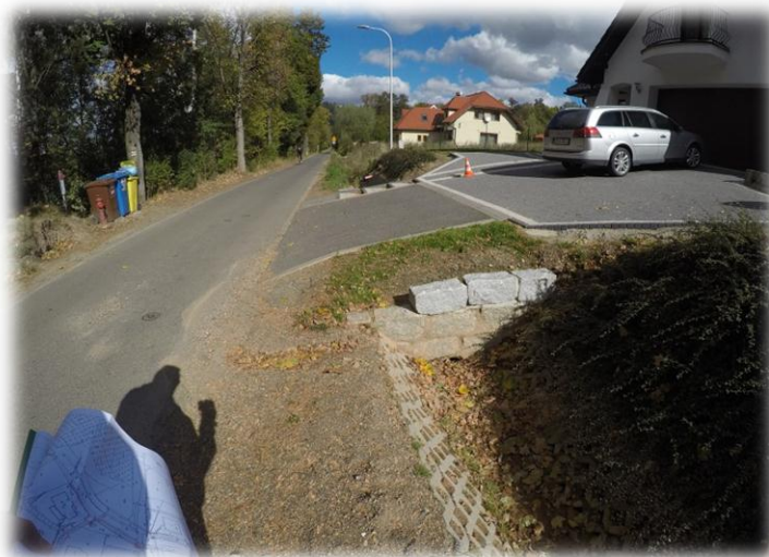
Ilustracja 16. Widok na wypłycony rów w wyniku niedrożności przepustu.
