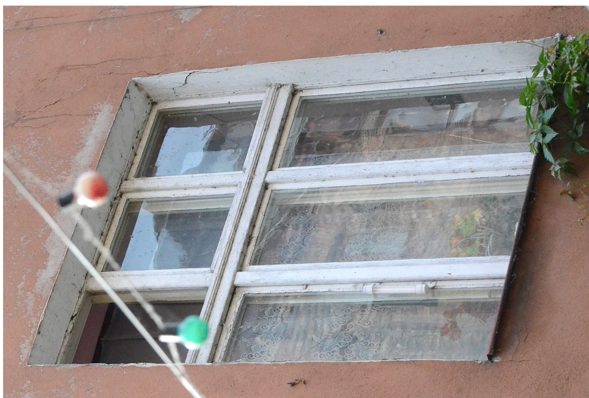
Il. 46 Grudziądz, Kamienica przy ul. Pańskiej 2/ ul. Reja 1 - wtórna stolarka TYP O/V – widok na awers stolarki
