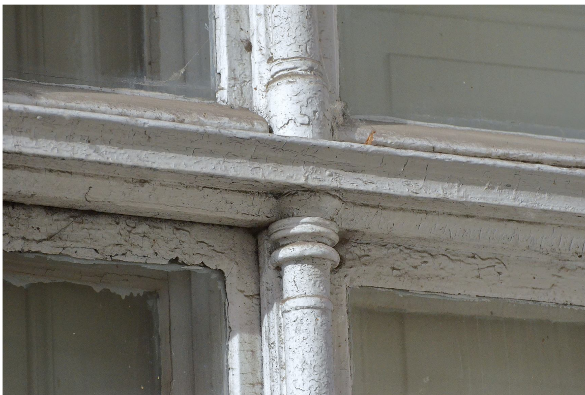
Il. 35 Grudziądz, Kamienica przy ul. Pańskiej 2/ ul. Reja 1- elewacja północna (klatka schodowa) - pierwotna stolarka TYP O/IB – widok na fragment półpozornego krzyża okiennego
