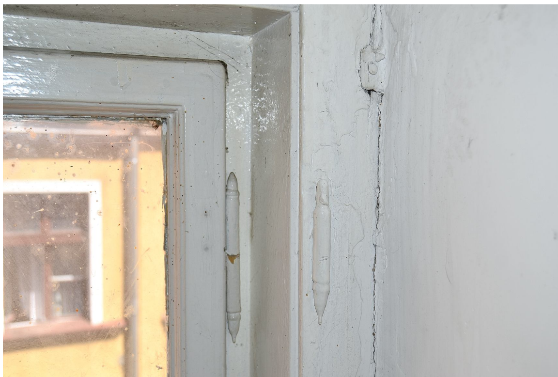
Il. 34 Grudziądz, Kamienica przy ul. Pańskiej 2/ ul. Reja 1- elewacja północna (klatka schodowa) - pierwotna stolarka TYP O/IB – widok na fragment skrzynki oraz zawiasy czopowe wpuszczane fot. Ewa Bożejewicz 2018 r.
