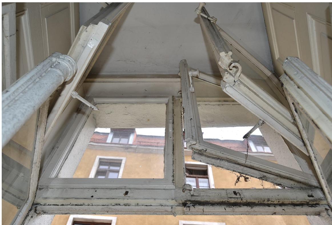
Il. 13 Grudziądz, Kamienica przy ul. Pańskiej 2/ ul. Reja 1 - elewacja północna (parter) - pierwotna stolarka TYP O/IA – widok na nadślepię stolarki
