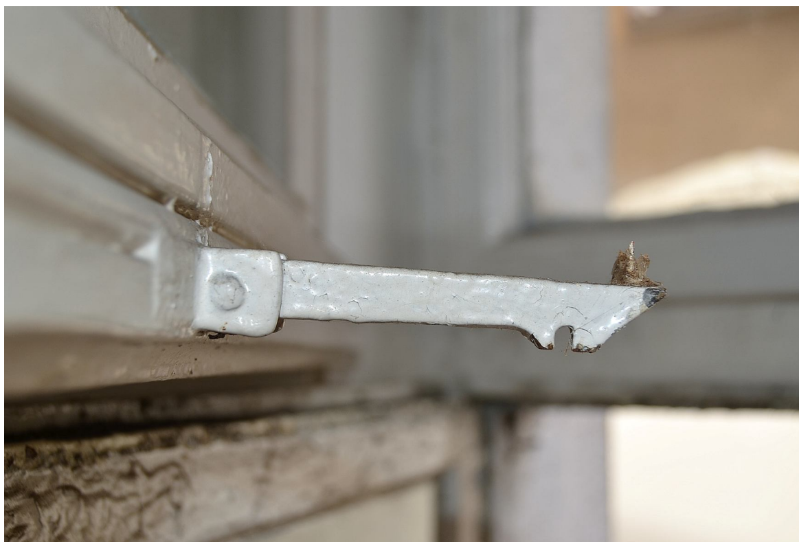
Il. 17 Grudziądz, Kamienica przy ul. Pańskiej 2/ ul. Reja 1- elewacja północna (parter)
