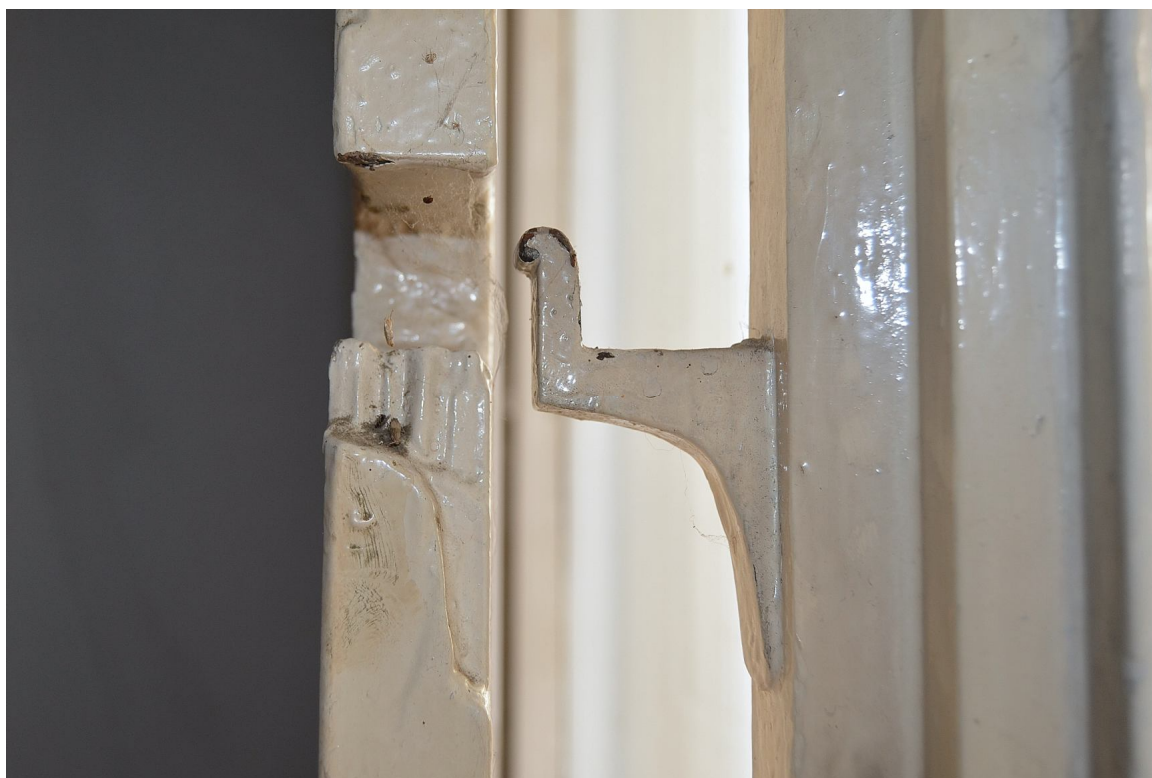
Il. 28 Grudziądz, Kamienica przy ul. Pańskiej 2/ ul. Reja 1- elewacja północna (parter) - pierwotna stolarka TYP O/IA – widok na hak okucia zamykającego okiennicę
