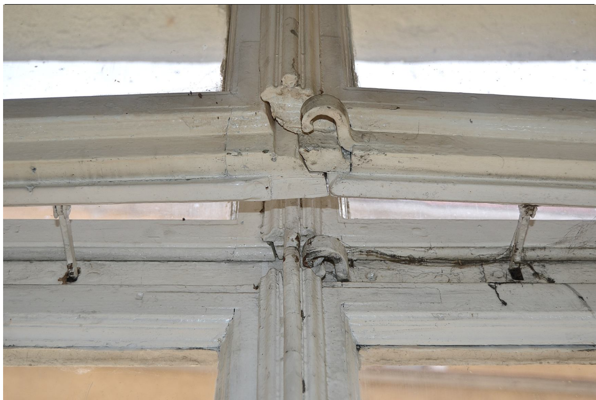
Il. 14 Grudziądz, Kamienica przy ul. Pańskiej 2/ ul. Reja 1 - elewacja północna (parter) - pierwotna stolarka TYP O/IA – widok na fragment skrzydeł okiennych i ich okucia zamykające
