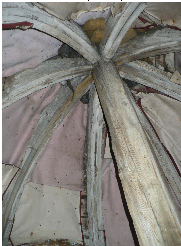
Widok konstrukcji hełmu wykusza
