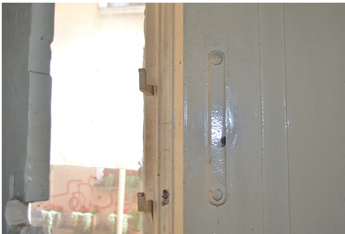
Il. 27 Grudziądz, Kamienica przy ul. Pańskiej 2/ ul. Reja 1- elewacja północna (parter) - pierwotna stolarka TYP O/IA – widok na okucie zamykające okiennicę
