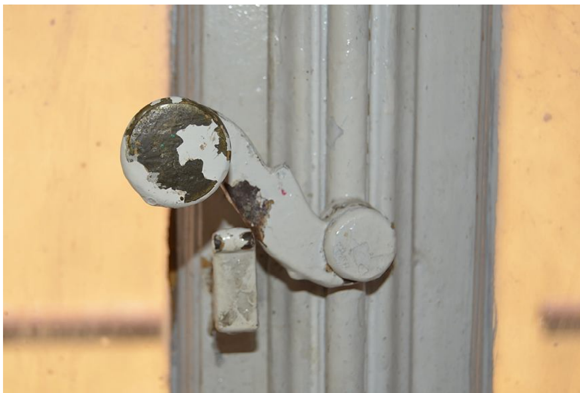
II. 39 Grudziądz, Kamienica przy ul. Pańskiej 2/ ul. Reja 1- elewacja północna (klatka schodowa) - pierwotna stolarka TYP O/IB – widok na fragment zawrotnicy z zakrętką dźwigniową z hakiem fot. Ewa Bożejewicz 2018 r.
