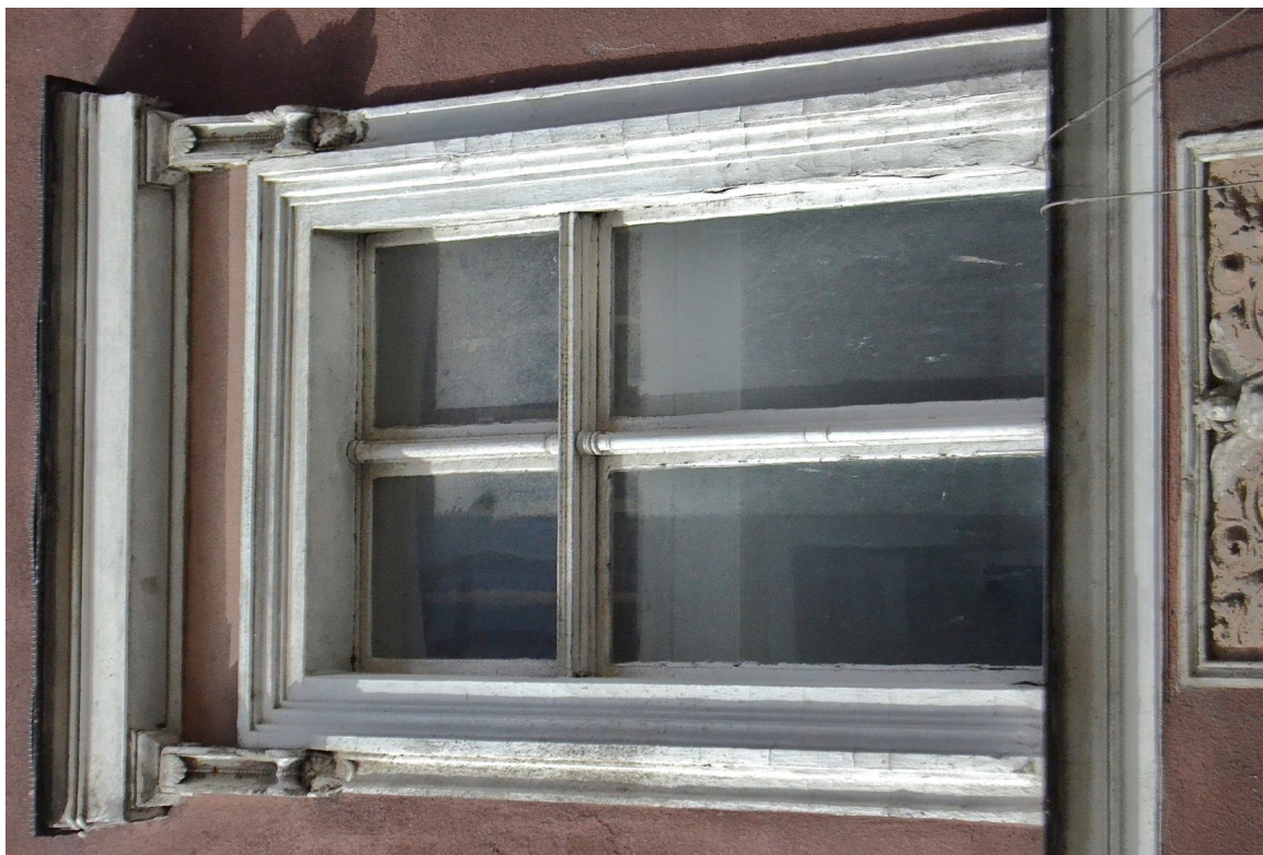
Il. 31 Grudziądz, Kamienica przy ul. Pańskiej 2/ ul. Reja 1- elewacja północna (klatka schodowa) - stolarka TYP O/IB – pierwotna stolarka okienna - awers
