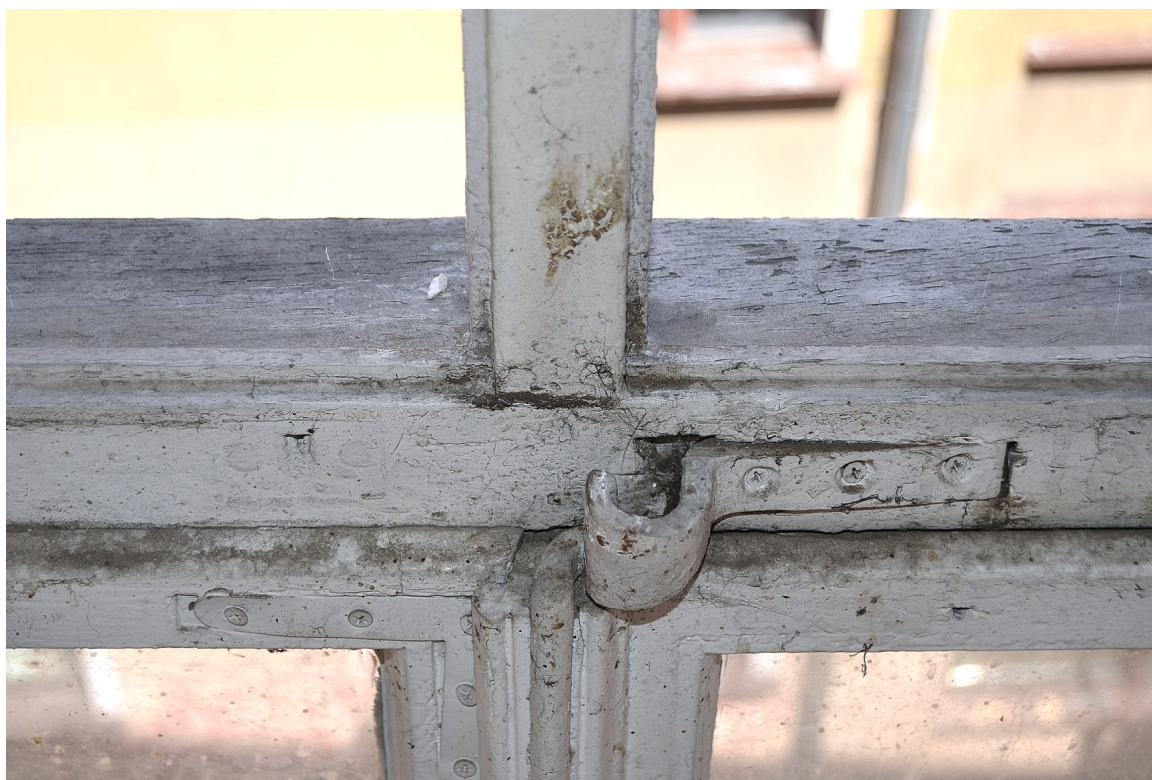
Il. 41 Grudziądz, Kamienica przy ul. Pańskiej 2/ ul. Reja 1- elewacja północna (klatka schodowa) - pierwotna stolarka TYP O/IB – widok na ślemię oraz słupek w nadświetleniu oraz hak zawrotnicy fot. Ewa Bożejewicz 2018 r.
