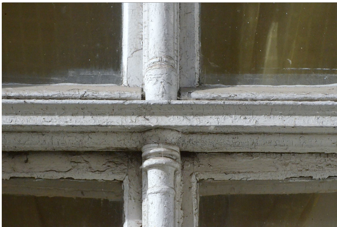
Il. 7 Grudziądz, Kamienica przy ul. Pańskiej 2/ ul. Reja 1- elewacja północna (parter) - stolarka TYP O/IA – widok na fragment półpozornego krzyża okiennego
