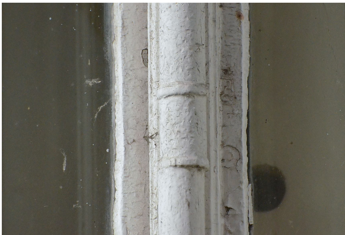
Il. 37 Grudziądz, Kamienica przy ul. Pańskiej 2/ ul. Reja 1- elewacja północna (klatka schodowa) - pierwotna stolarka TYP O/IB – widok na opaski dekorujące środkową część wałka listwy przymykowej fot. Ewa Bożejewicz 2018 r.
