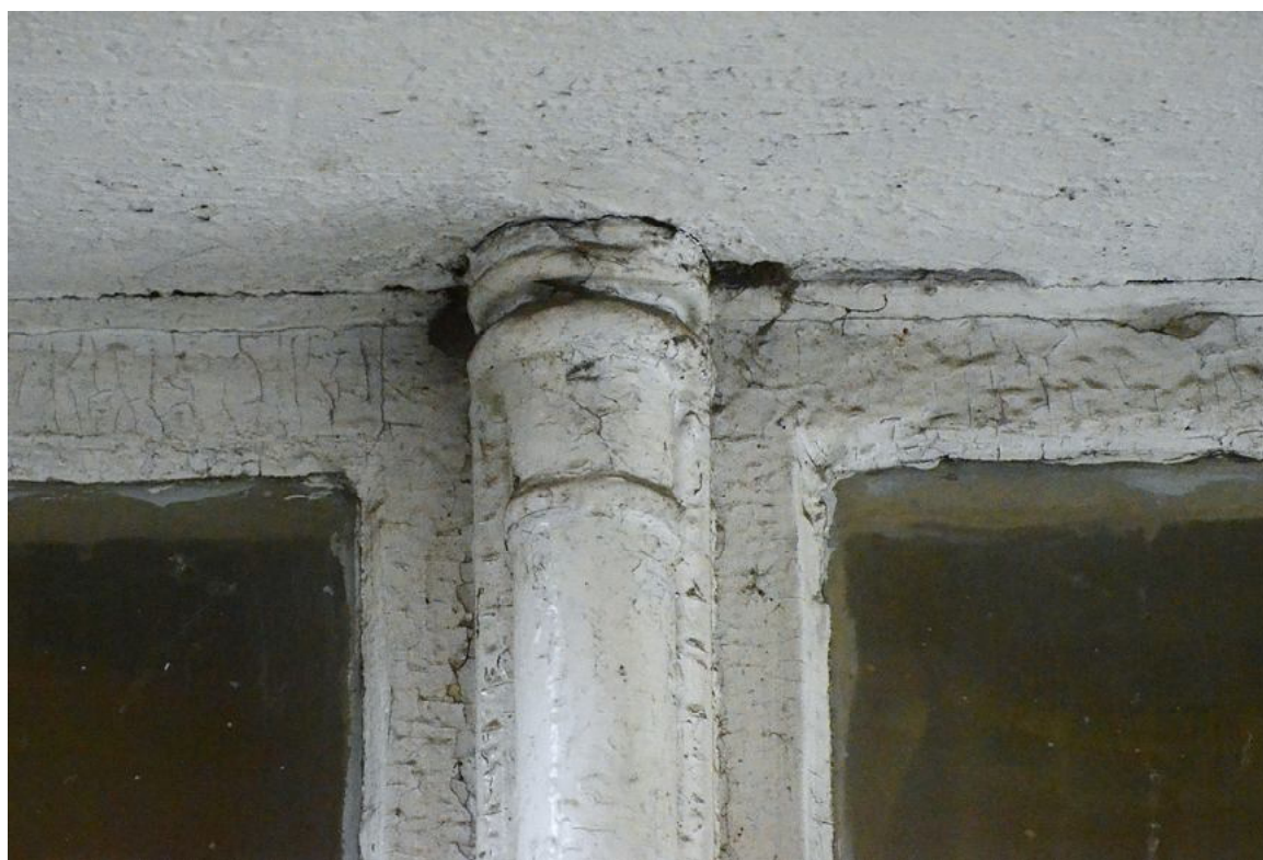
Il. 36 Grudziądz, Kamienica przy ul. Pańskiej 2/ ul. Reja 1- elewacja północna (klatka schodowa) - pierwotna stolarka TYP O/IB – widok na głowiczkę listwy przymykowej
