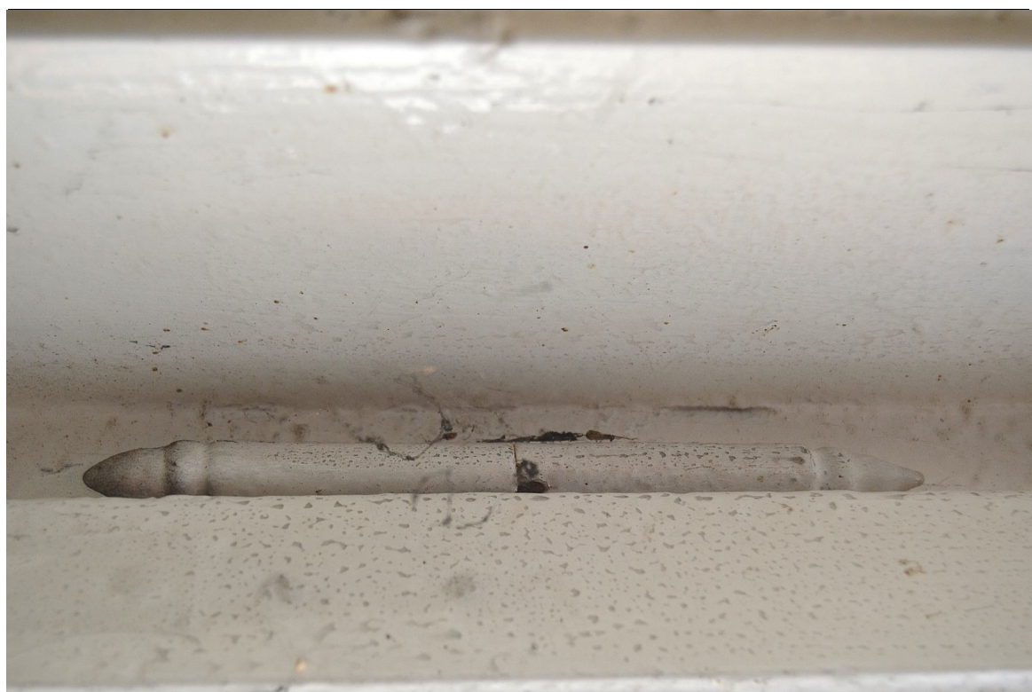
Il. 22 Grudziądz, Kamienica przy ul. Pańskiej 2/ ul. Reja 1- elewacja północna (parter) - pierwotna stolarka TYP O/IA – widok na zawias czopowy wpuszczany profilowany
