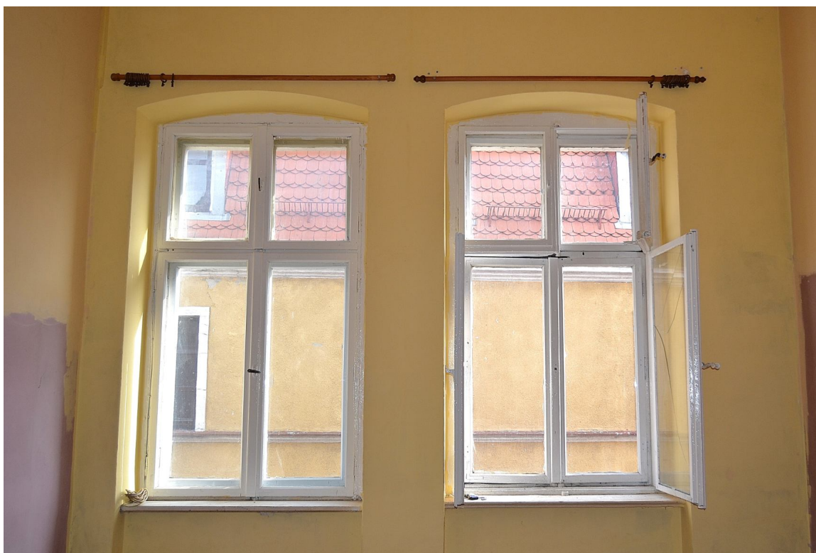
Il. 30 Grudziądz, Kamienica przy ul. Pańskiej 2/ ul. Reja 1 - elewacja północna (I i II piętro) - stolarka TYP O/IB – pierwotna i wtórna stolarka okienna - rewers
