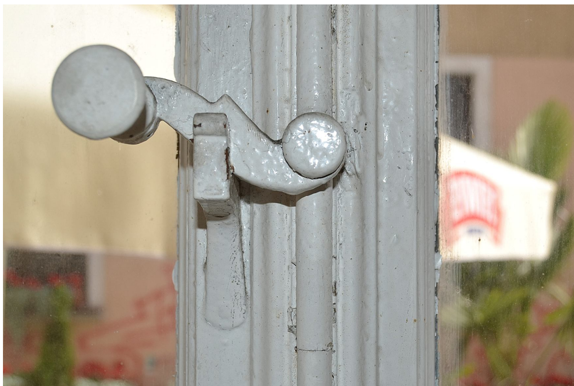
Il. 19 Grudziądz, Kamienica przy ul. Pańskiej 2/ ul. Reja 1- elewacja północna (parter) - pierwotna stolarka TYP O/IA – widok na fragment zawrotnicy z zakrętką dźwigniową z hakiem fot. Ewa Bożejewicz 2018 r.
