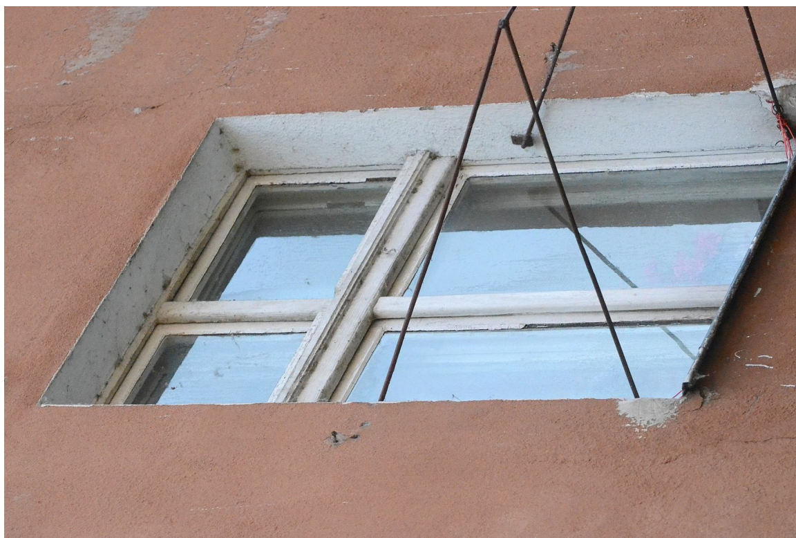
Il. 45 Grudziądz, Kamienica przy ul. Pańskiej 2/ ul. Reja 1- elewacja zachodnia (I i II piętro) - wtórna stolarka TYP O/IV – widok na awers stolarki
