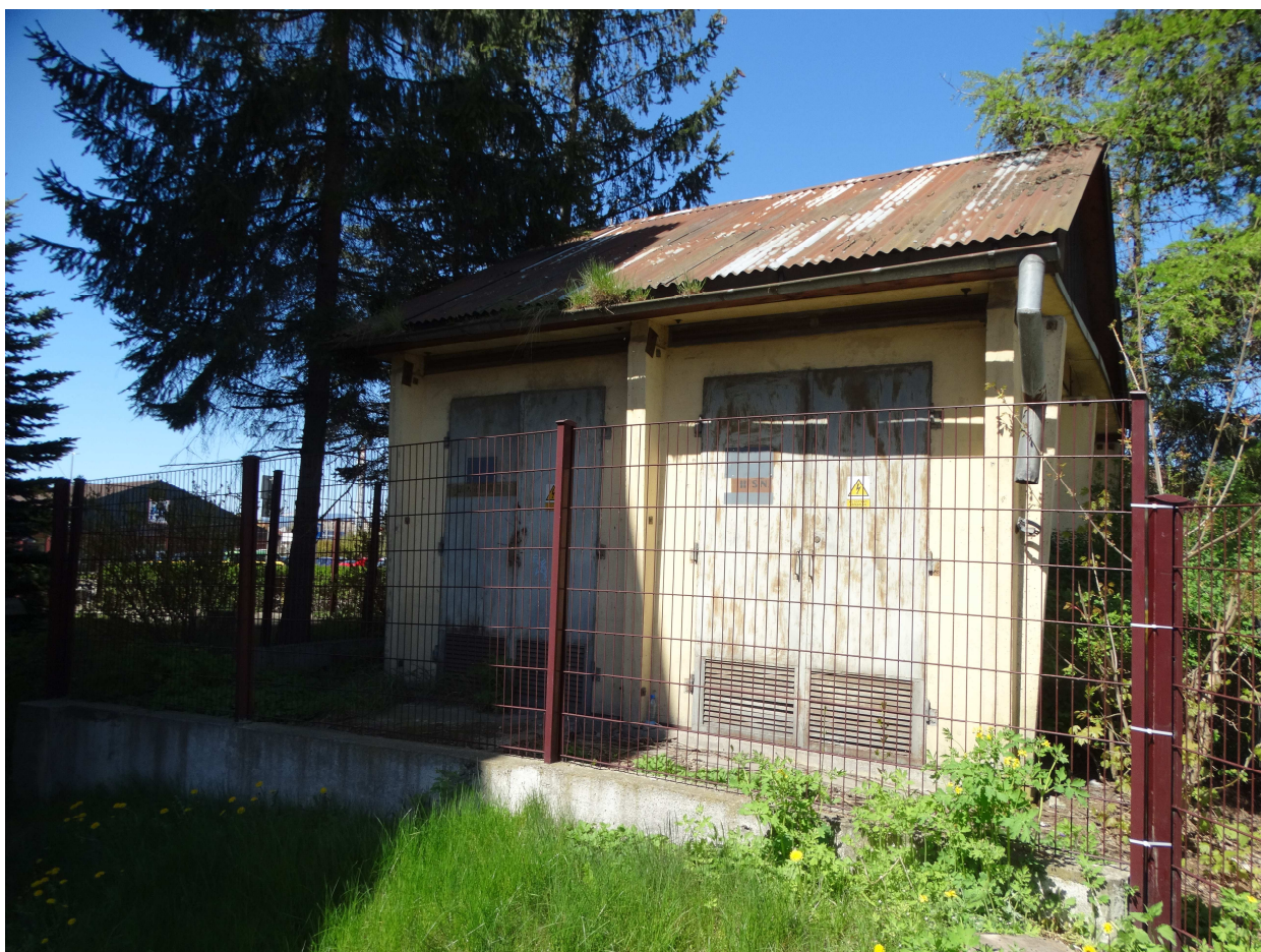
Widok stacji trafo (widoczna ściana od strony szkoły, otwory stanowią 57 % jej powierzchni)
