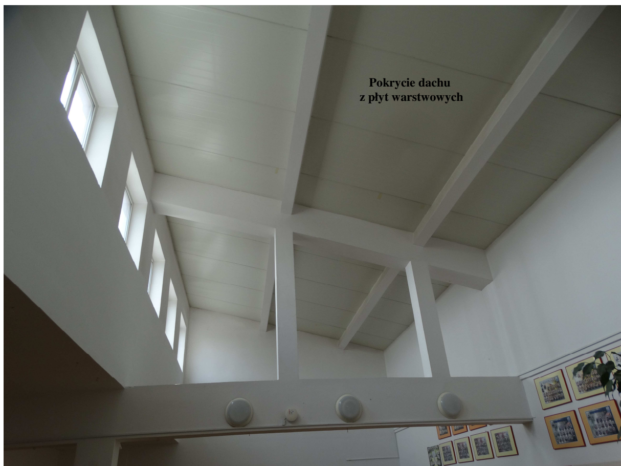
Widok fragmentu dachu z naświetlami i pokryciem z płyt warstwowych PW8/B02
