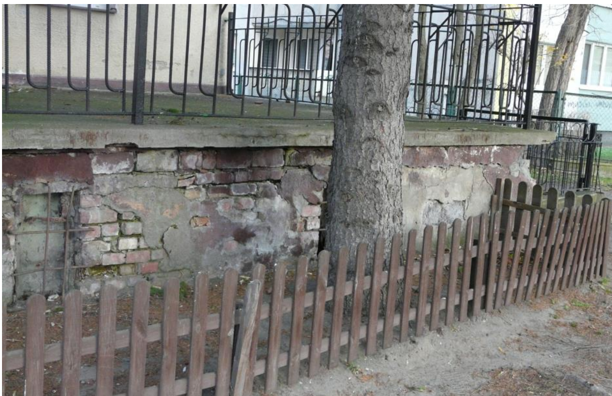
Zdjęcie nr 3: Obudowa tarasu – zły stan techniczny
