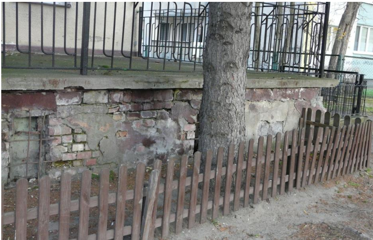
Zdjęcie nr 3: Obudowa tarasu – zły stan techniczny
