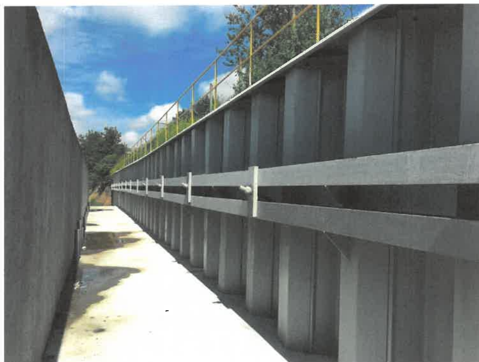
Rys. 4 – ściana oporowa kompostowni (z lewej) z wyprowadzonymi króćcami napowietrzania
