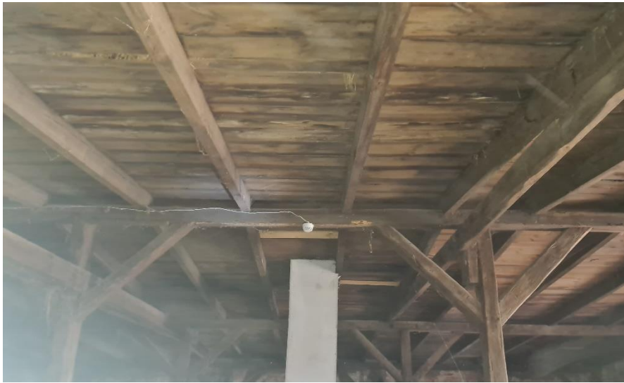
Rys. 57 Komin ocieplony w części poddasza.
