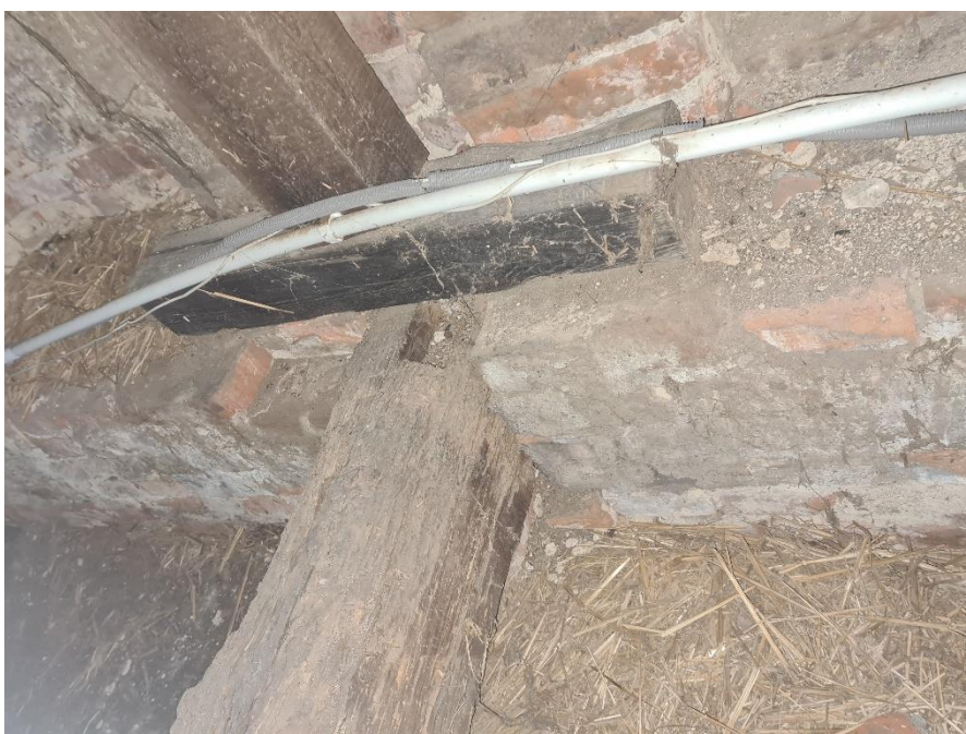
Rys. 53 Węzeł środkowy dolny ramy drewnianej z belką podwalinową prostopadłą do osi ramy.
