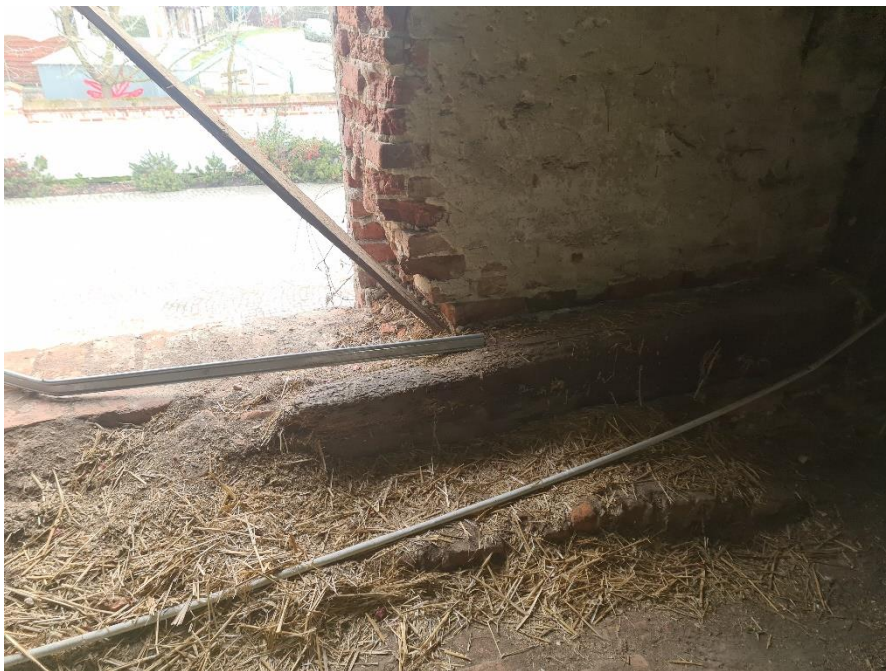
Rys. 3 Niezabezpieczony przed opadami atmosferycznymi otwór okienny.
