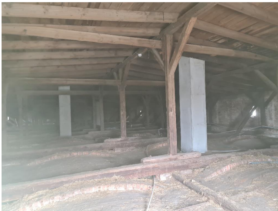
Rys. 5 Ogólny widok konstrukcji ram drewnianych wsporczych.
