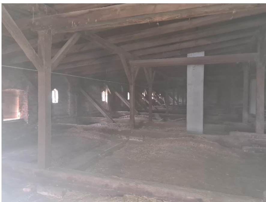
Rys. 6 Ogólny widok konstrukcji ram drewnianych wsporczych.
