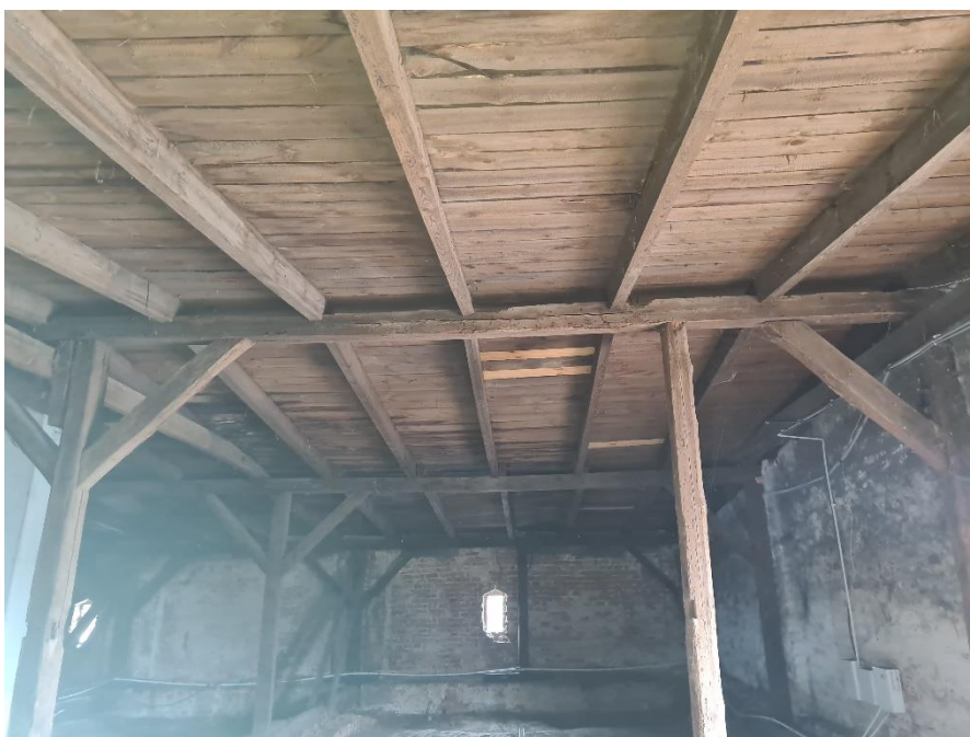
Rys. 8 Dodatkowy słup wsporczy w ramie drewnianej.
