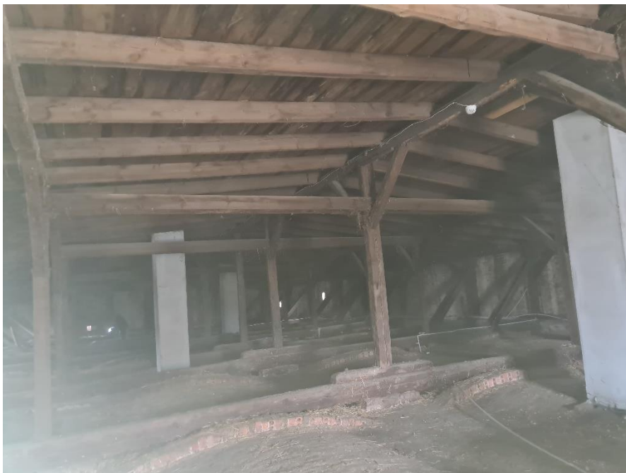
Rys.1 Ogólny widok konstrukcji elementów wsporczych dachu budynku.
