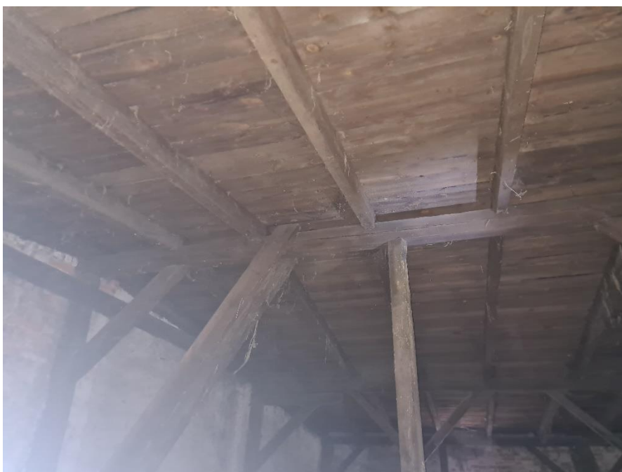
Rys. 2 Górny pas ramy drewnianej, słupy rozpory, krokwie, słupy i poszycie drewniane dachu.
