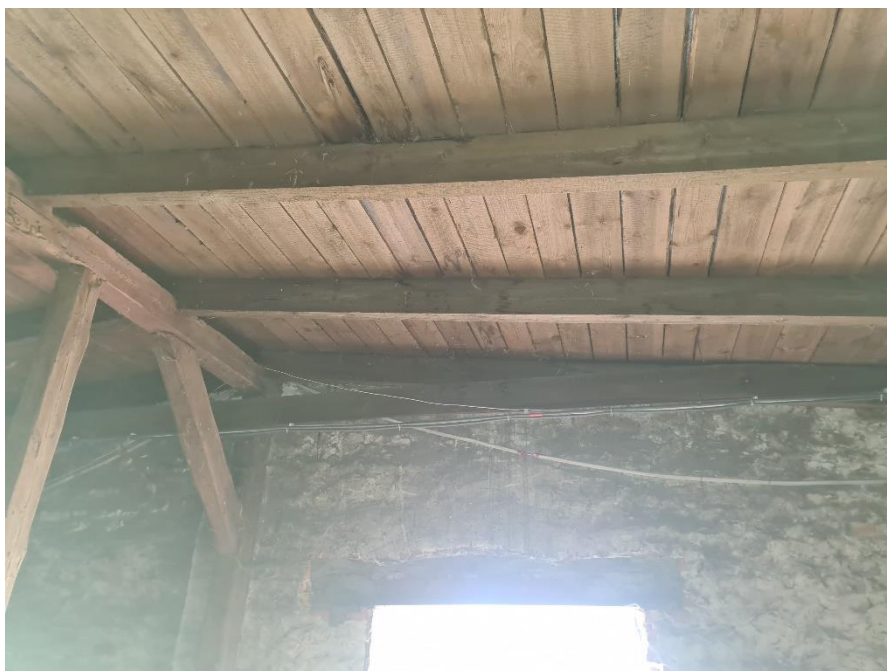
Rys10 . Widok poszycia dachu i wsparcia na belkach drewnianych.
