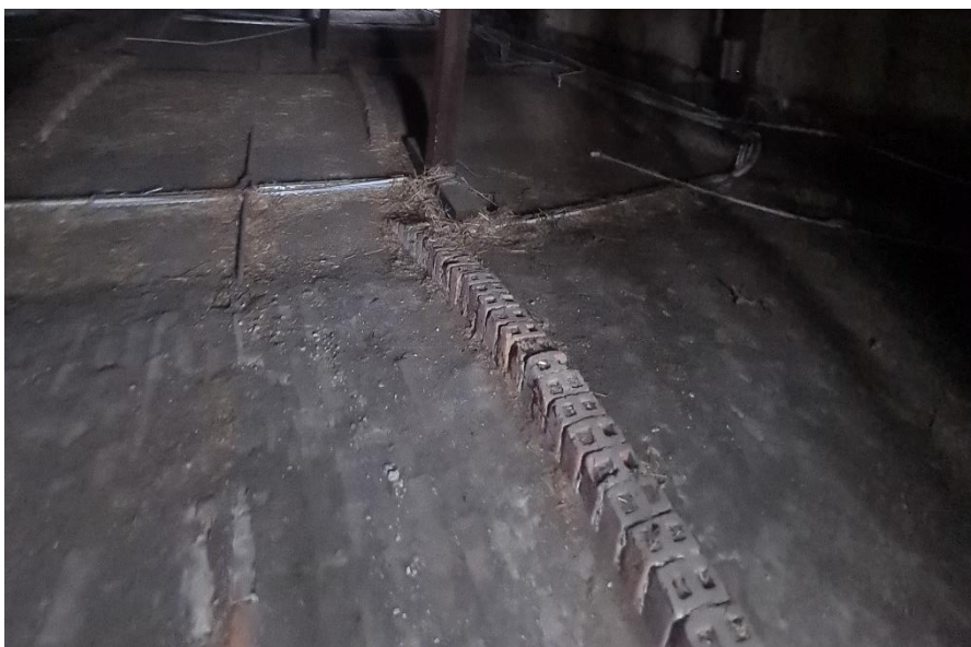
Rys. 20 Stalowy ściąg, żebro z cegły dziurawki usztywnijają strop kolebkowy.
