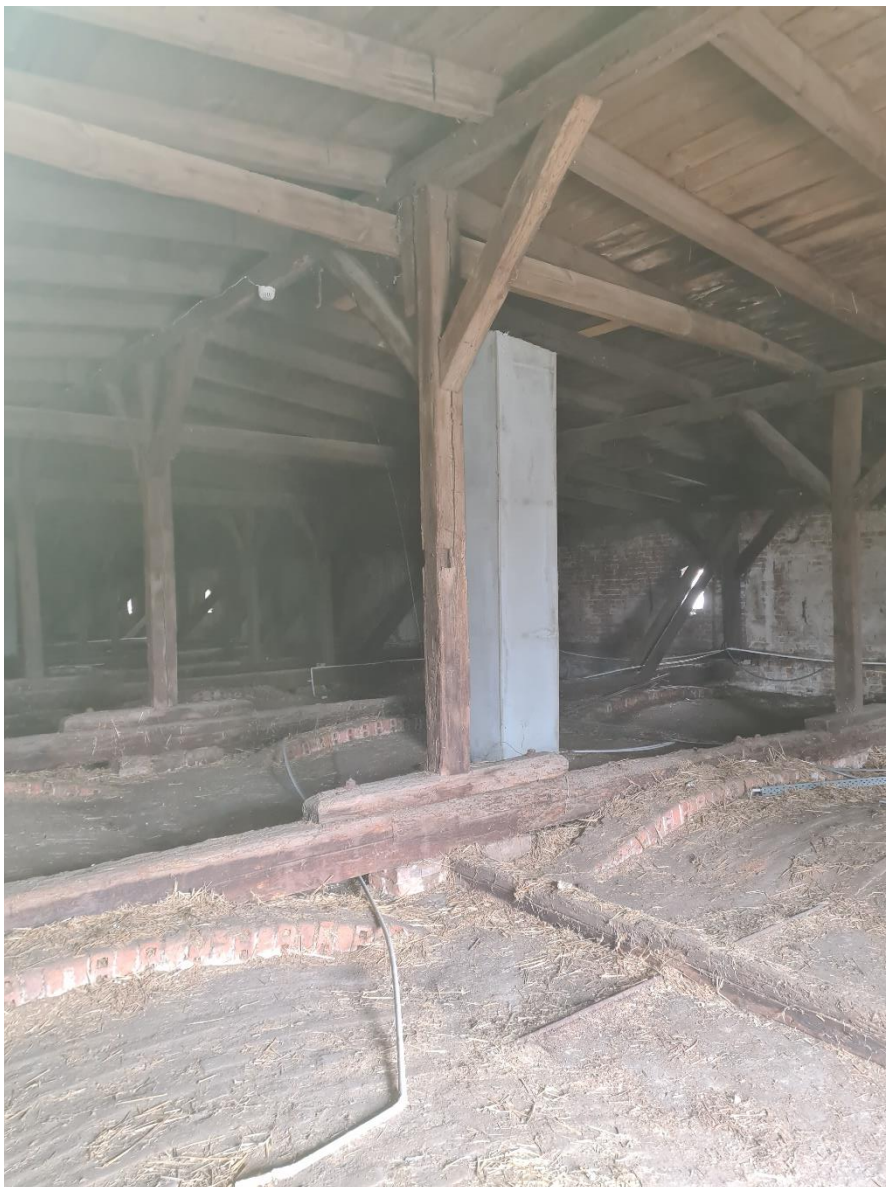
Rys. 53 Węzeł środkowy dolny ramy drewnianej z belką podwalinową prostopadłą do osi ramy.
