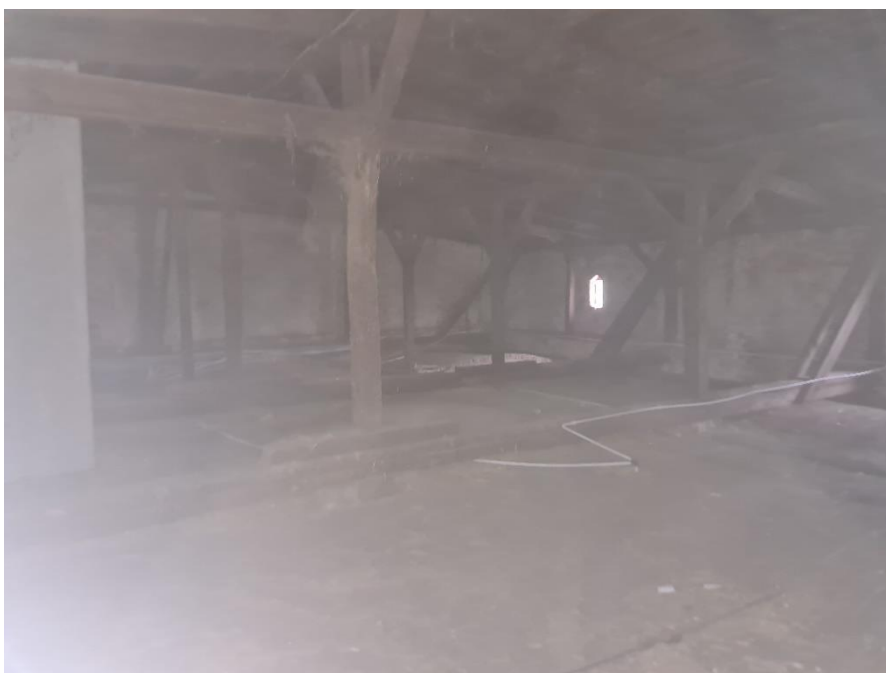
Rys.9 Jętka spinająca ramę drewnianą.
