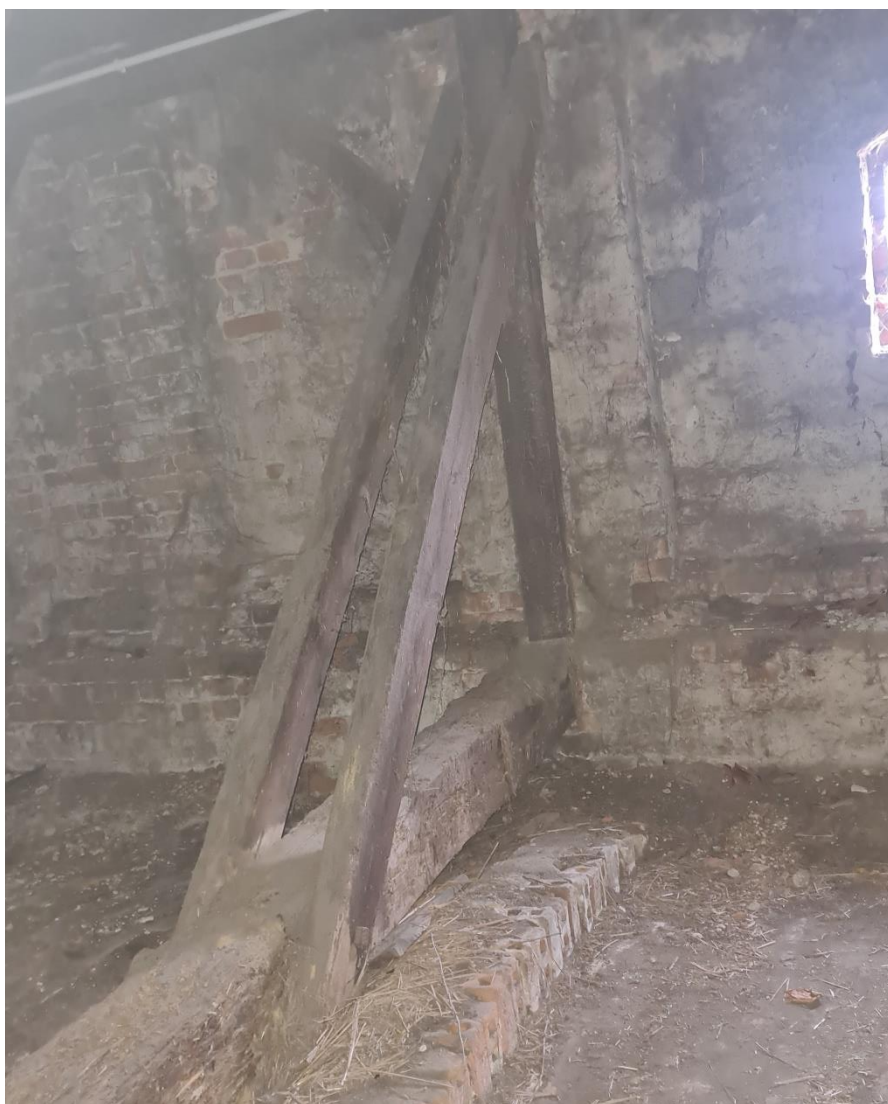
Rys. 39 Typowy wygląd węzła dolnego ramy drewnianej.
