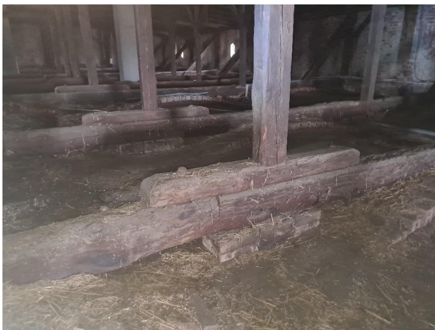
Rys. 50 Ogólny widok dolnego pasa ram drewnianych.
