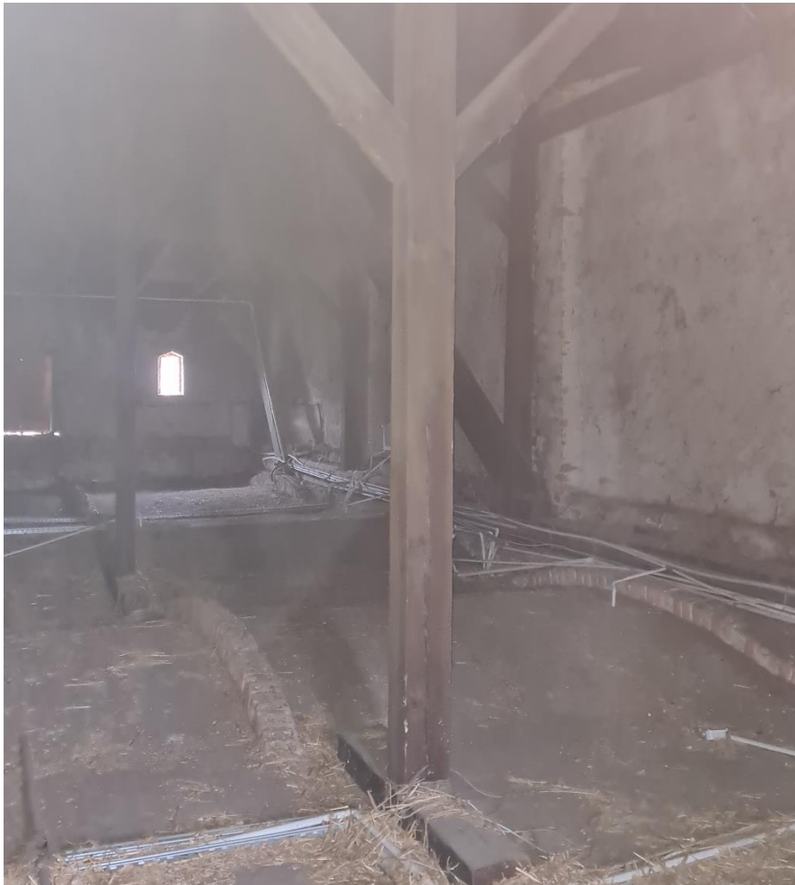
Rys. 21 Słup pośredni, miecze pod konstrukcję wsporczą dachu.
