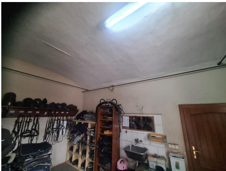
Rys. 62 Strop kolebkowy w pomieszczeniu siodłowni.
