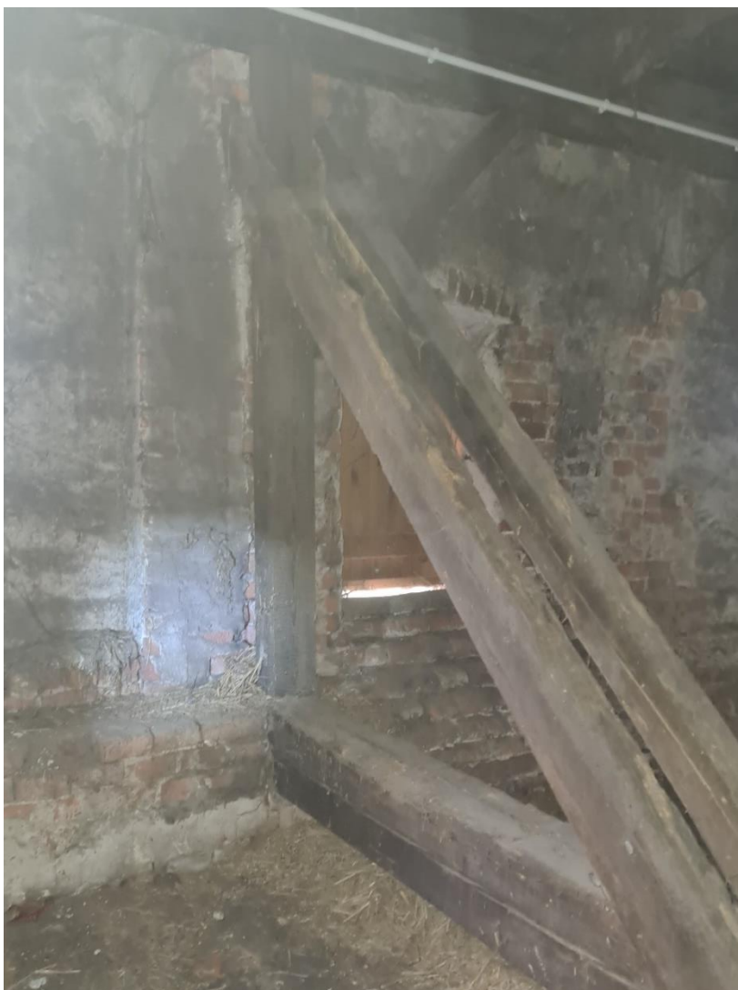
Rys. 37 Otwór okienny i widoczne elementy słupa, belki podwalinowej i zastrzały jako typowe dla węzła podporowego ramy drewnianej.
