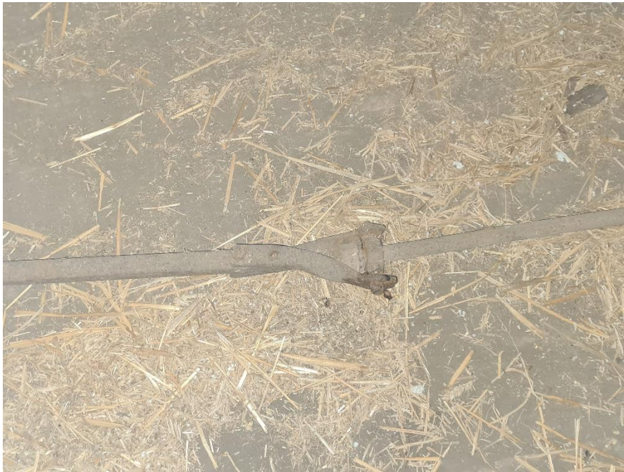
Rys. 32 Ściąg stalowy wymieniony ze śrubą w ściągu innym niż w przypadku śruby rzymskiej.
