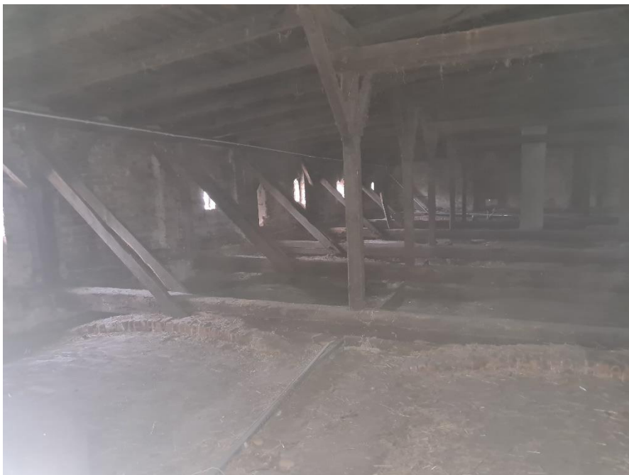
Rys. 7 Ogólny widok konstrukcji ram drewnianych wsporczych.
