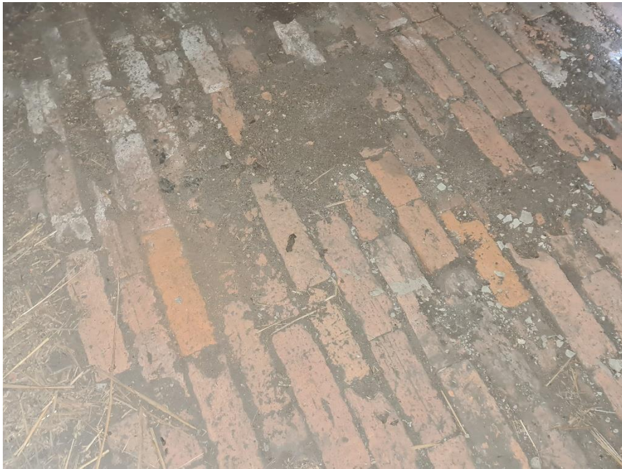
Rys. 29 Typowy wygląd powierzchni górnej przekrycia stropu kolebkowego.
