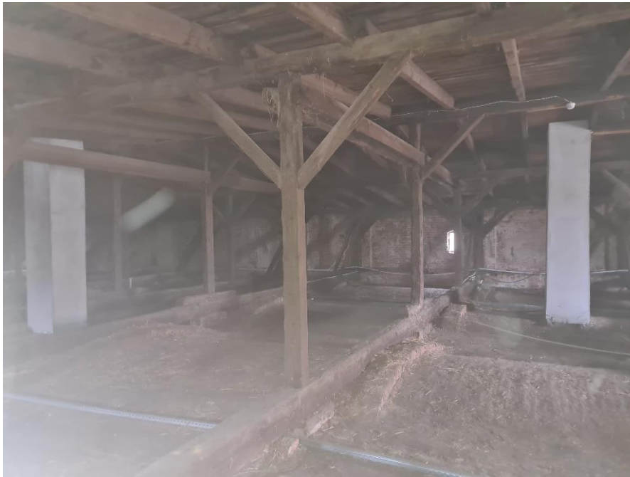
Rys. 12 Układ ram i obecność kominów.
