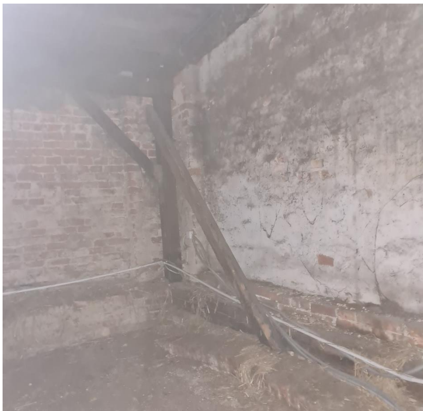
Rys. 55 Węzeł skrajny ramy w narożu północno wschodnim budynku.
