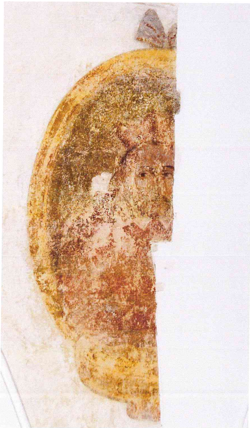
Fot.6. Wysklepek zachodni z częściowo odsłoniętym wizerunkiem kardynała. Widoczne na całej powierzchni liczne ubytki warstwy malarskiej wraz z zewnątrzną warstwą zaprawy
