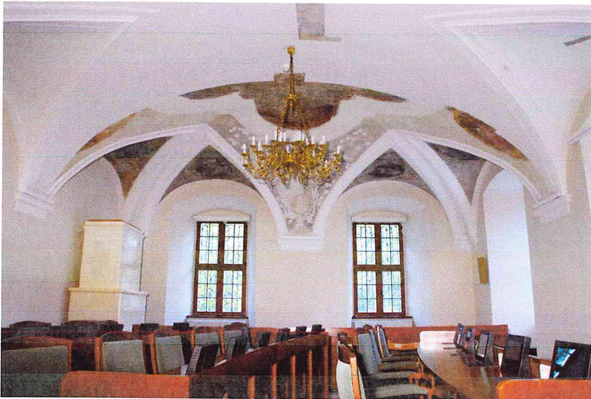
Fot.1. Urząd Miasta Poznania, Sala Sesyjna, (dawniej Wielki Refektarz), Widok partii południowej Stan po odsłonięciu w 2018 roku części malowideł ściennych i sztukaterii – ok. 1730r.
