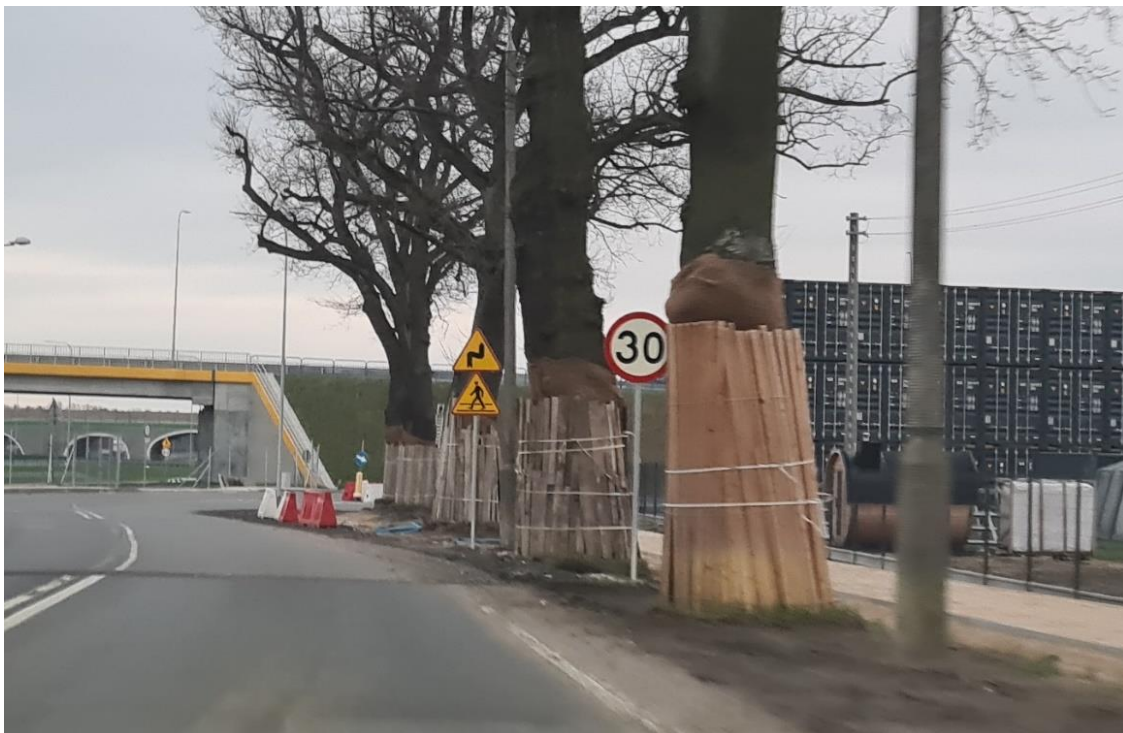
Powyżej prezentacja fotografii z przykładem jak należy zabezpieczyć pnie drzew jutą oraz dekami.
